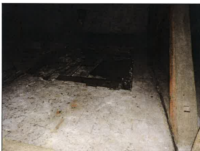
FOTO 37 Widok zagłbienia podłogi strych 6
