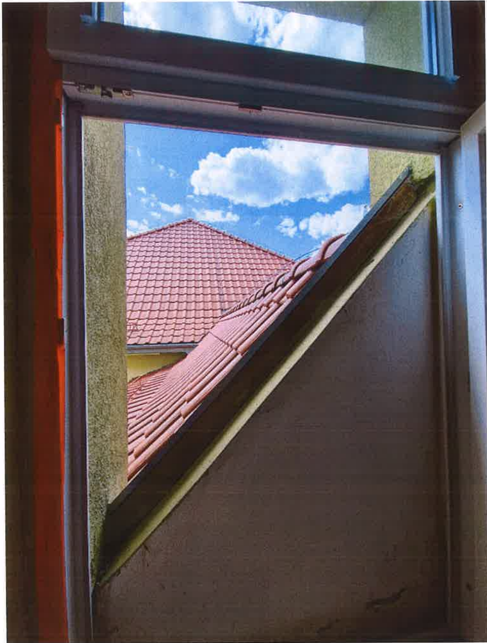
Zdjęcie nr. 2 Widok dachu łącznika z okna budynku sąsiedniego
