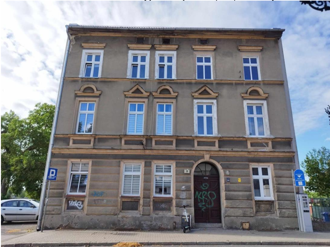
Fot. 1 – widok na elewację frontową od strony ulicy Teatralnej
