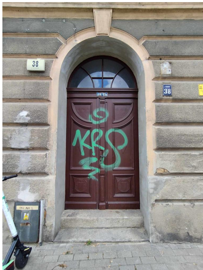
Fot. 2 – Front budynku, główne wejście do budynku
