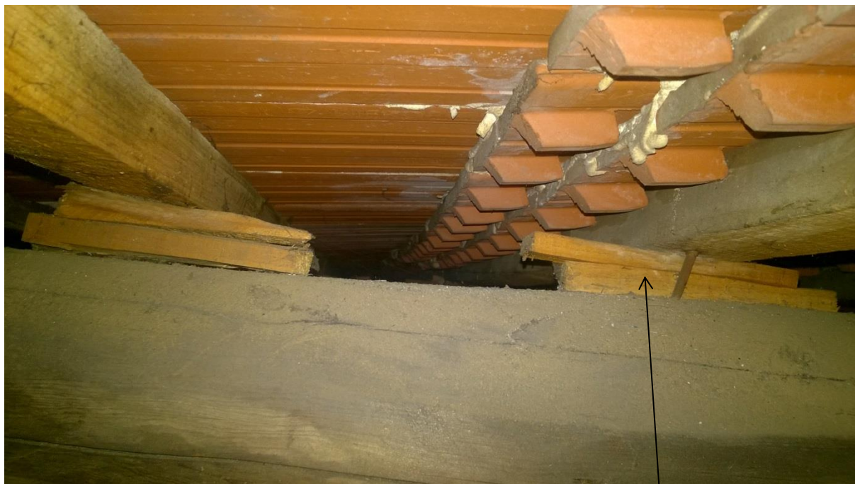
klinowanie łąty w celu równania płaszczyzny połąci dachowej
