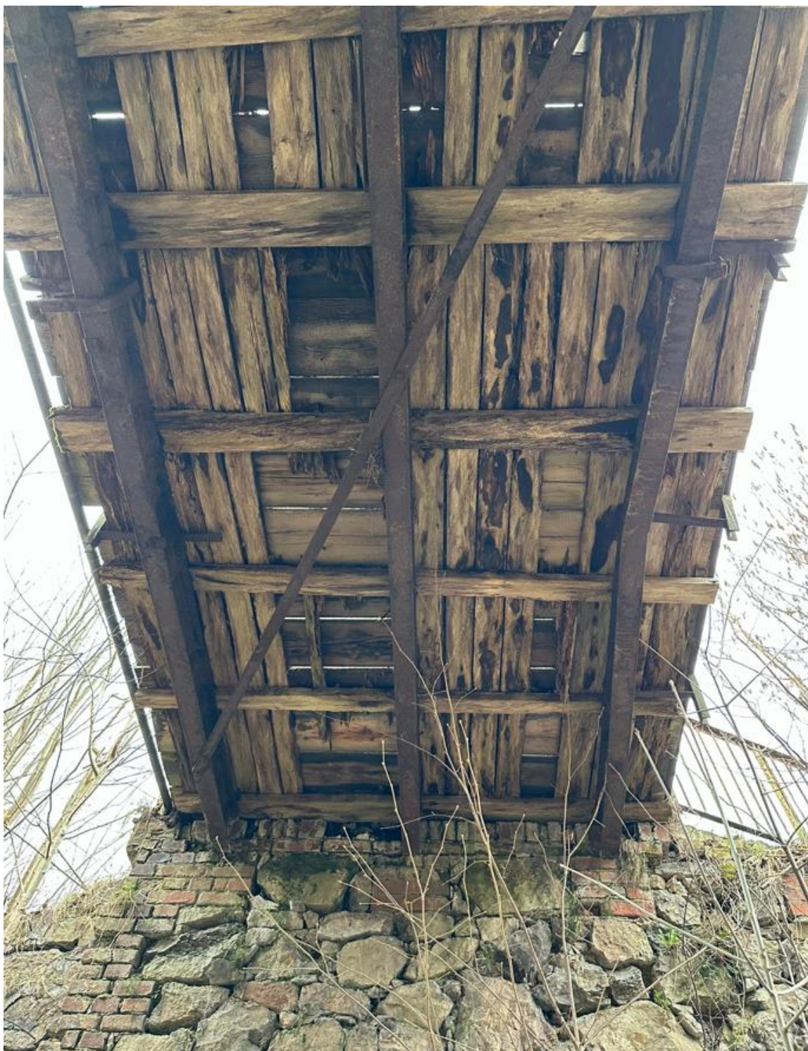
Rysunek 24. Obiekt nr 5 – nadmierna deformacja dźwigara (po prawej), znaczna degradacja i ubytki w pomoście, wegetacja oraz ubytki murowanego przyczółku
