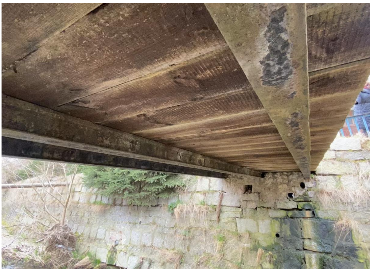
Rysunek 23. Obiekt nr 4 – widok na przyczółek (wegetacja, błędnie rozwiązane odwodnienie)
