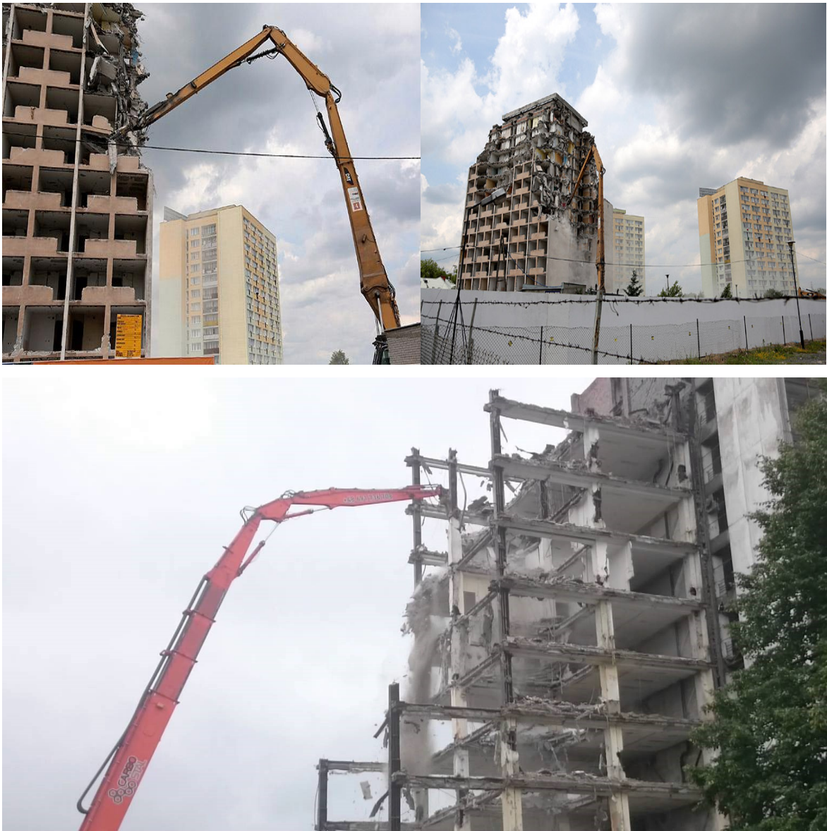
Prace rozbiórkowe budynków wysokich prowadzone mechanicznie –schodkowo .
