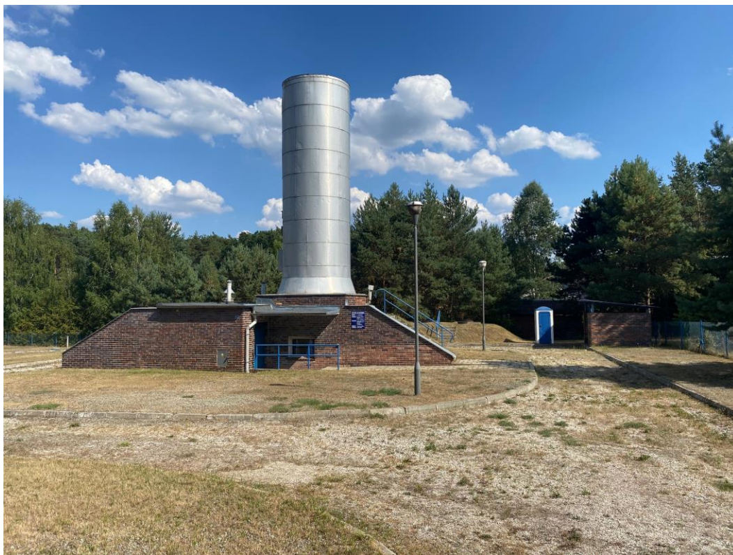
Zdjęcie nr 2 Budynek istniejącej Stacji Uzdatniania Wody
