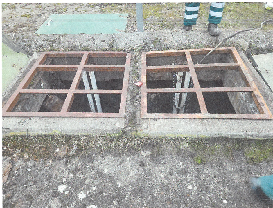
Zdjęcie 5 Otwory w pokrywie przepompowni ścieków
