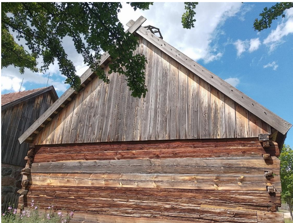
Fot. 3. Stodoła z Czarnej Dąbrowy, elewacja południowa (fot. K. Oziębłowska, czerwiec 2024).
