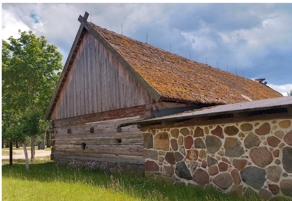
Fot. 4. Stodoła z Czarnej Dąbrowy, narożnik północno-zachodni budynku (fot. K. Oziębłowska czerwiec 2024).
