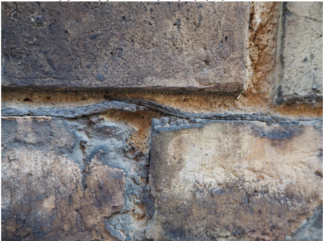
Fot.37. Gorzów Wlkp. ul. Wyszyńskiego 29, elewacja szczytowa, miejsce łączenie izolacji poziomej (wyk. P. Antoniuk).
