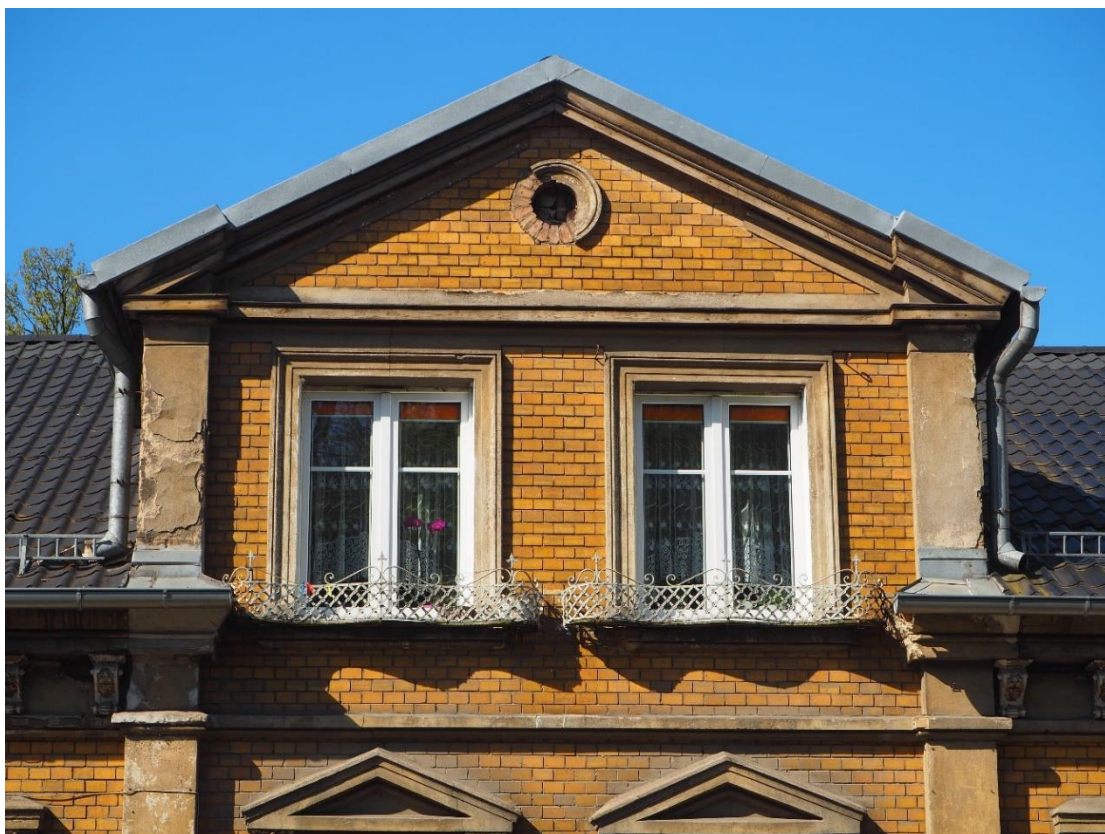
Fot.16. Gorzów Wlkp. ul. Wyszyńskiego 29, fasada, mansarda, widoczne uszkodzenie okulusa oraz zniszczenia w obrębie tynków – gizmsów i pilastrów (wyk. P. Antoniuk).
