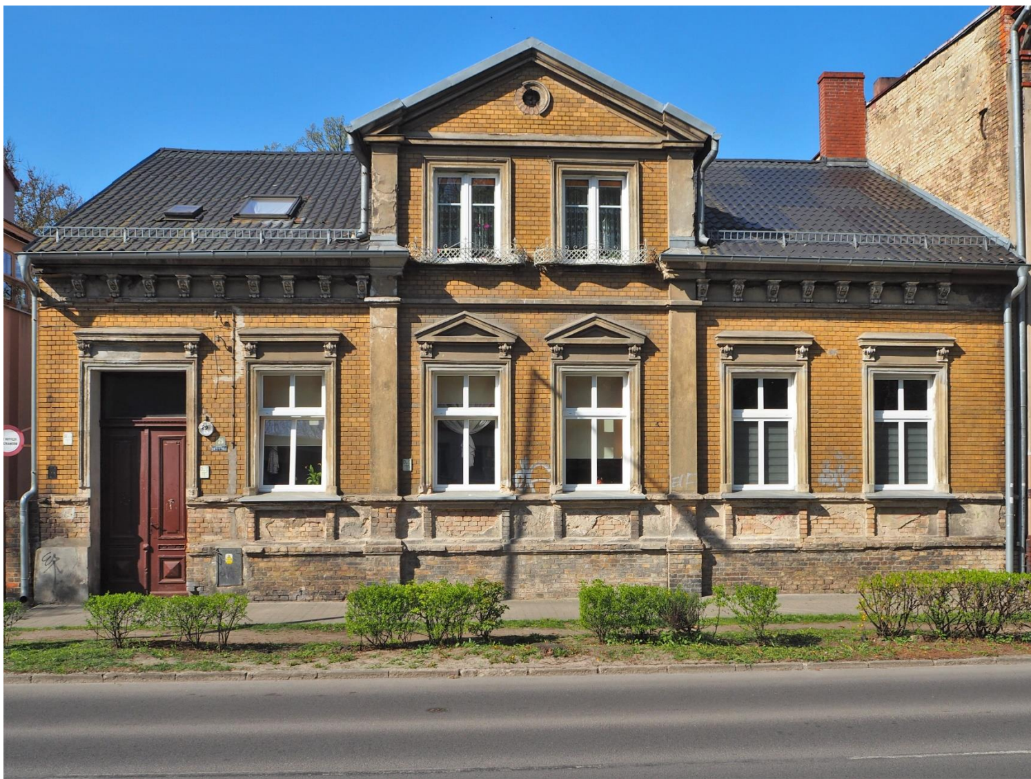
Fot.9. Gorzów Wlkp. ul. Wyszyńskiego 29, fasada (wyk. P. Antoniuk).
