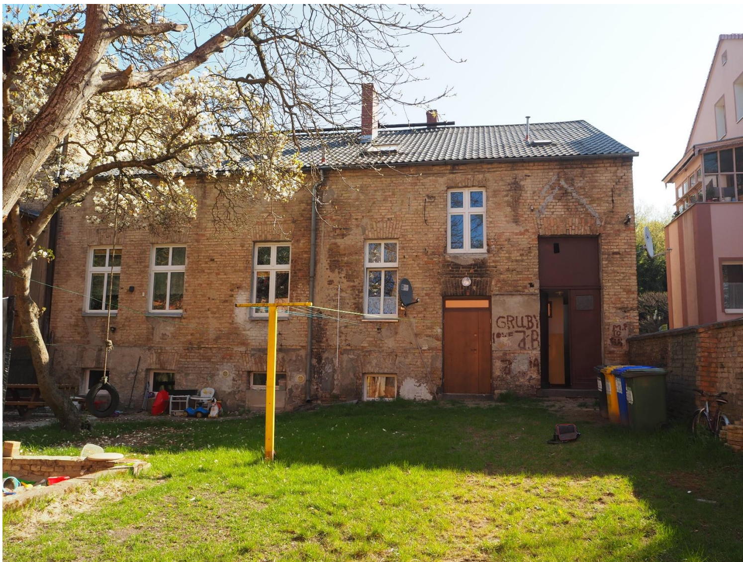
Fot.10. Gorzów Wlkp. ul. Wyszyńskiego 29, elewacja od strony podwórza (wyk. P. Antoniuk).
