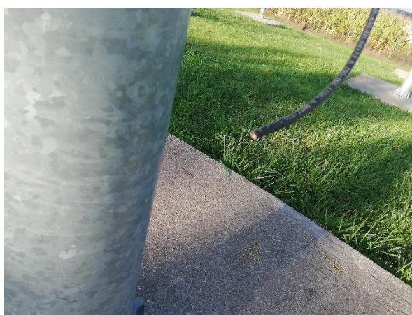
Rysunek 23 - luźno wiszący zerwany przewód DC
