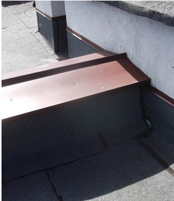
FOT. 11. Obróbka dylatacji
