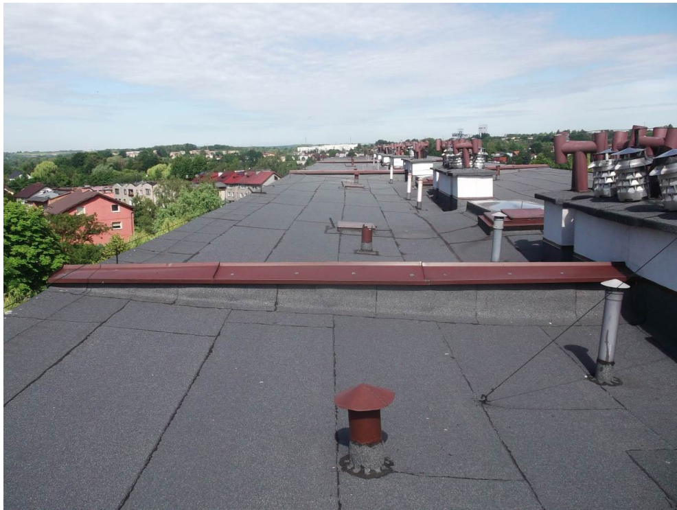
FOT. 4. Widok ogólny dachu budynku
