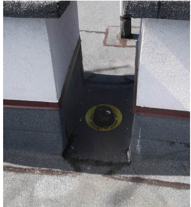
FOT. 12. Odpływ dachowy
