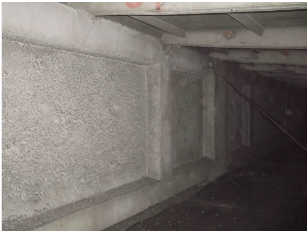
FOT. 2. Widok oparcia płyt dachowych na ścianie attykowej
