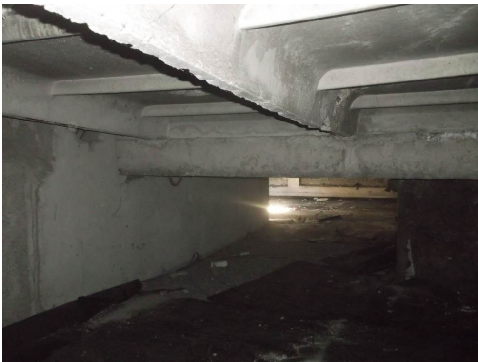
FOT. 3. Widok oparcia płyt dachowych na belce korytkowej
