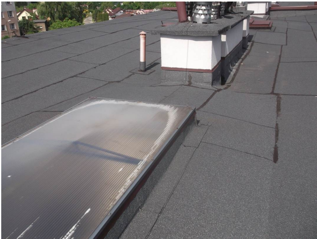
FOT. 13. Widok pokrycia dachu
