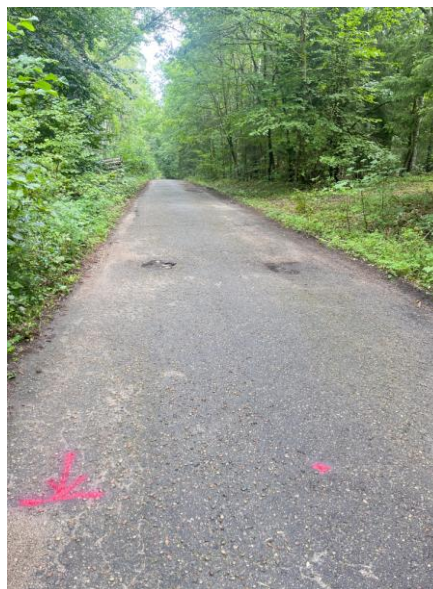
Zdjęcie nr 2-koniec odcinka
