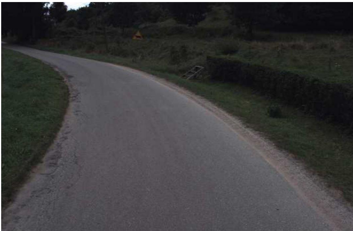
Zdj. nr 11 Dalsza część drugiego odcinka, remont pęknięć przy krawędzi jezdni
