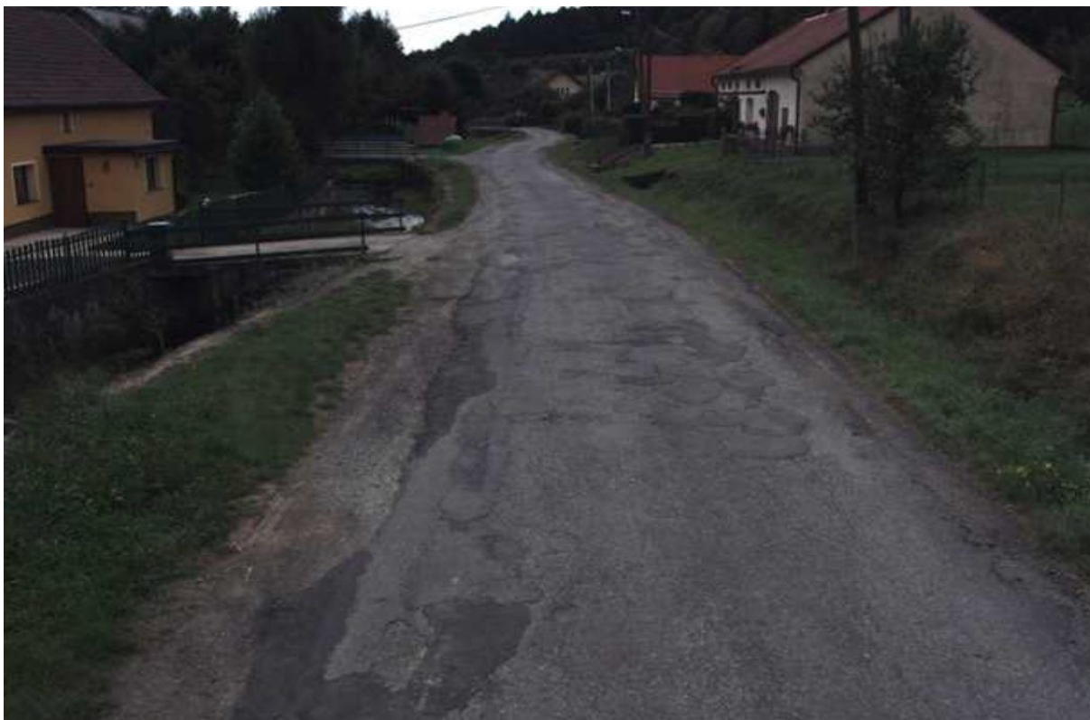
Zdj. nr 7 bariery na murze, brukowanie pobocza, czyszczenie rowu
