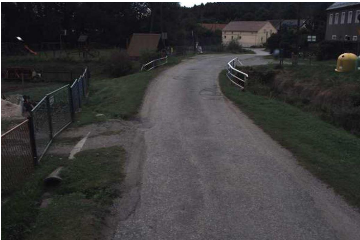
Zdj. nr 5 remont mostu i zjazdu
