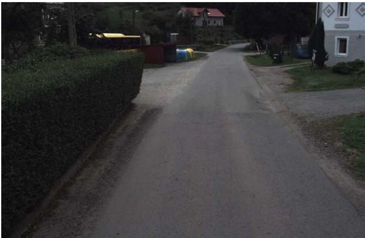
Zdj. nr 9 Początek drugiego odcinka km 4+865, wykonanie mijanek
