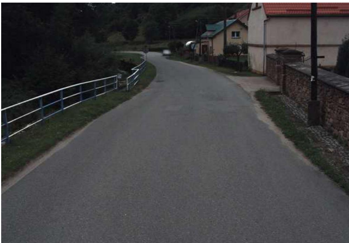
Zdj. nr 10 brukowanie pobocza, malowanie poręczy
