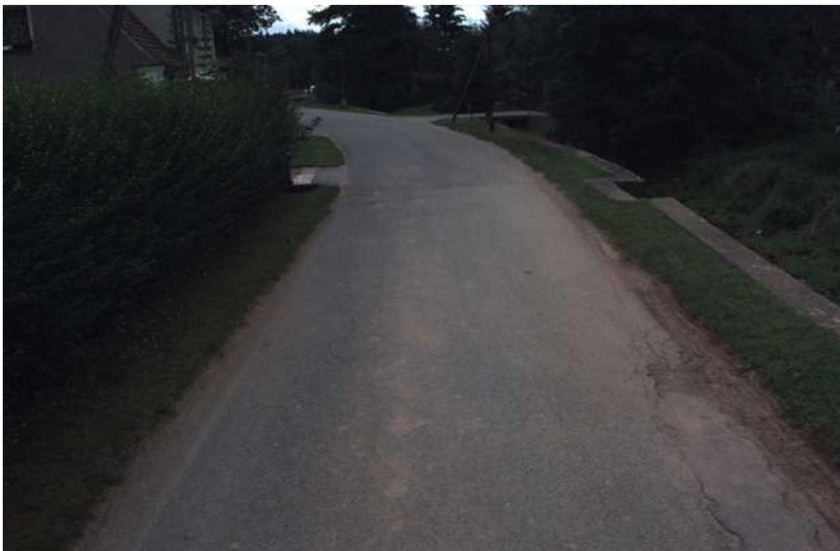
Zdj. nr 12 Koniec drugiego odcinka km 5+765
