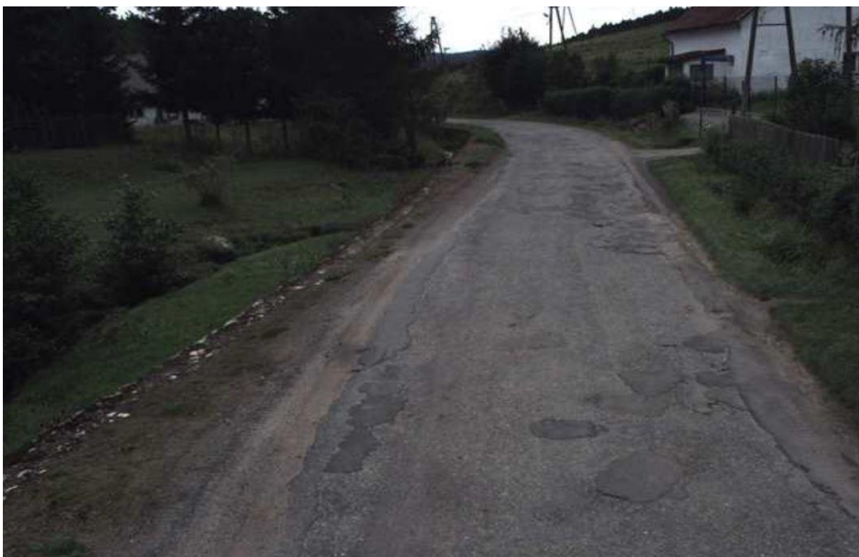
Zdj. nr 6 bariery na murze, brukowanie pobocza, czyszczenie rowu
