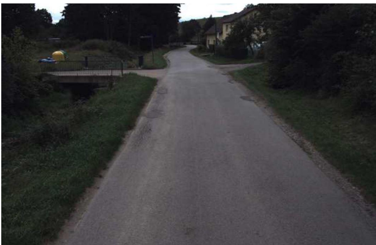
Zdj. nr 12 Dalsza część drugiego odcinka, remont pęknięć przy krawędzi jezdni
