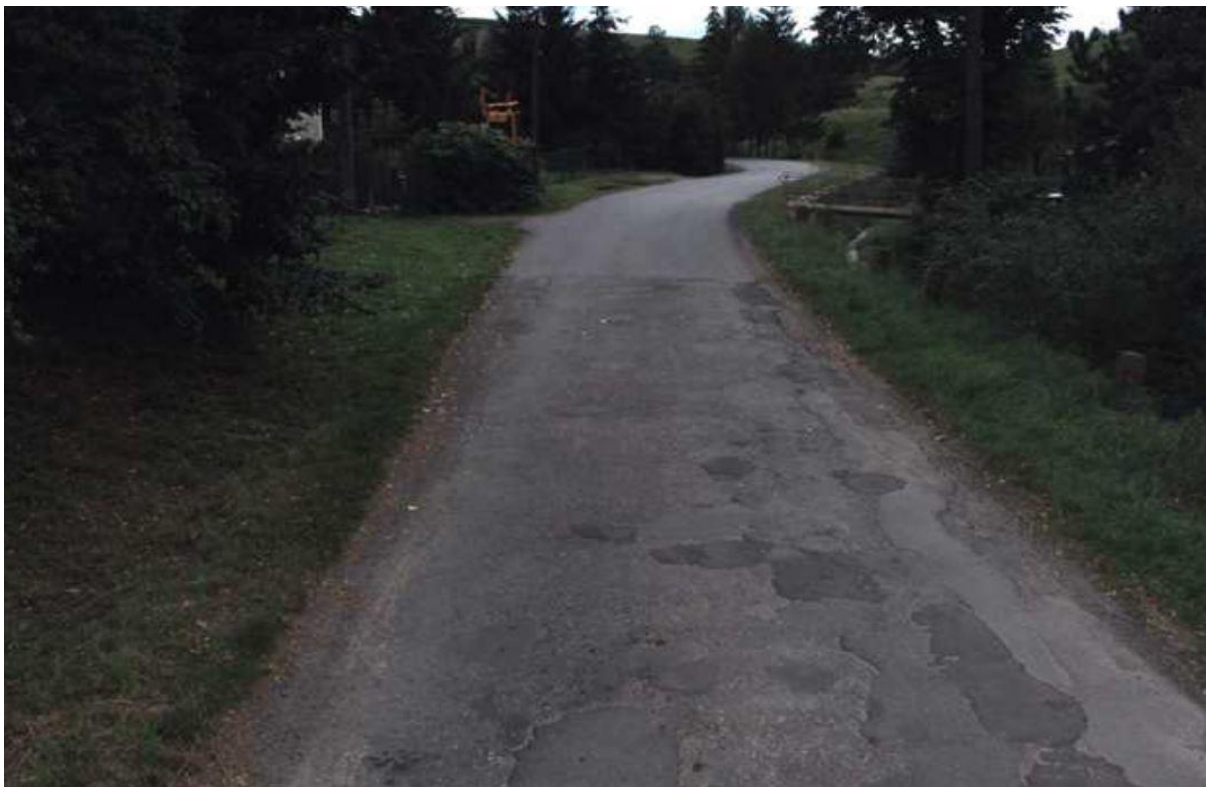
Zdj. nr 8 Końcowa część pierwszego odcinka km 4+520
