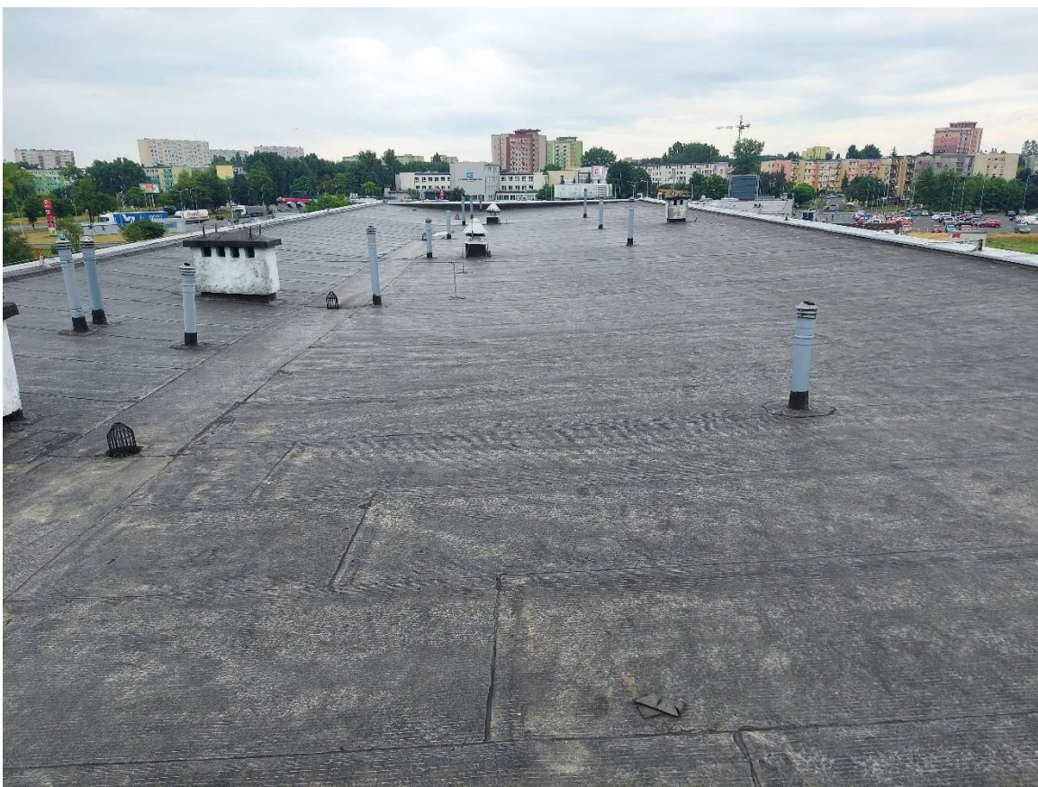
Fot. 1. Segment dachu nr 1
