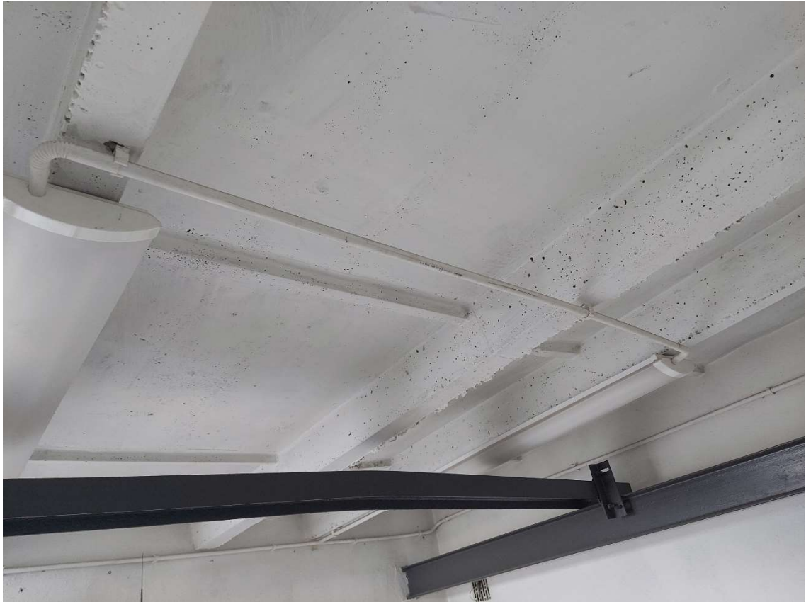
Fot. 6. Widok na konstrukcję dachu maszynowni – Płyty panwiowe, które stanowią również konstrukcję stropodachu
