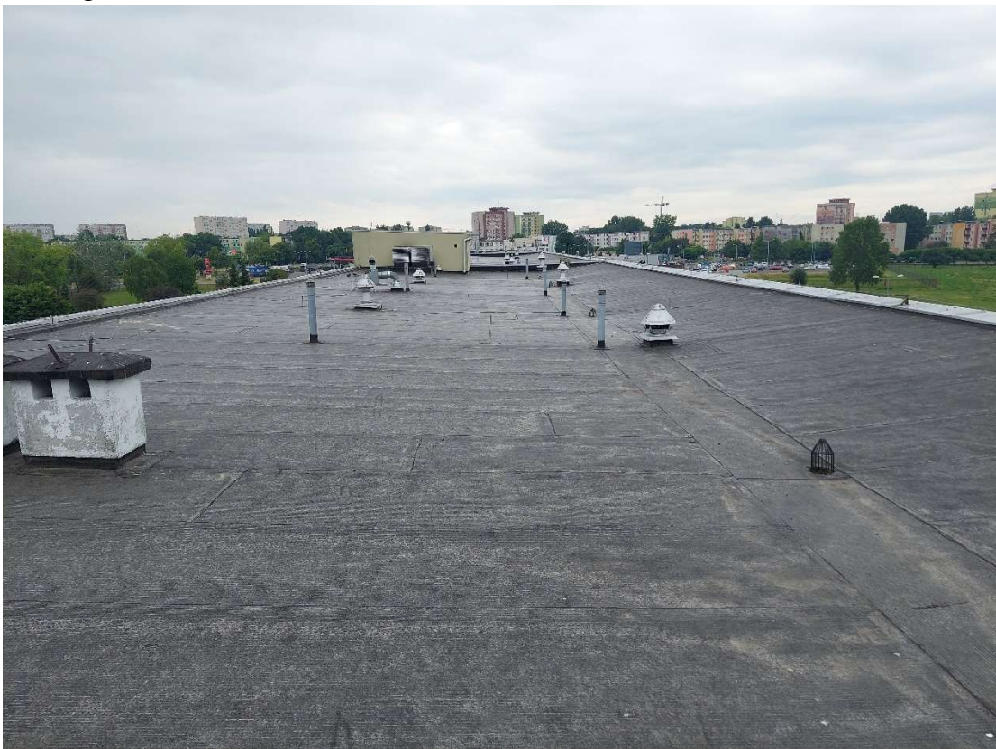
Fot.3. Segment dachu nr 3
