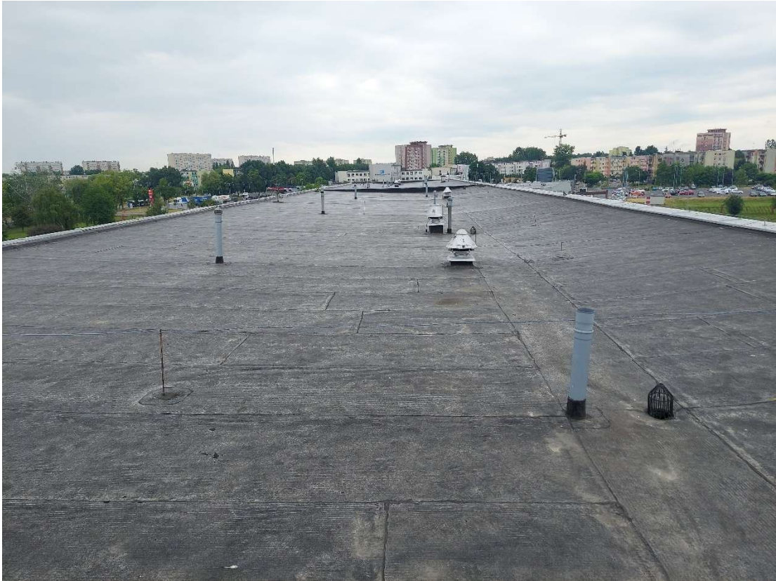
Fot. 2. Segment dachu nr 2
