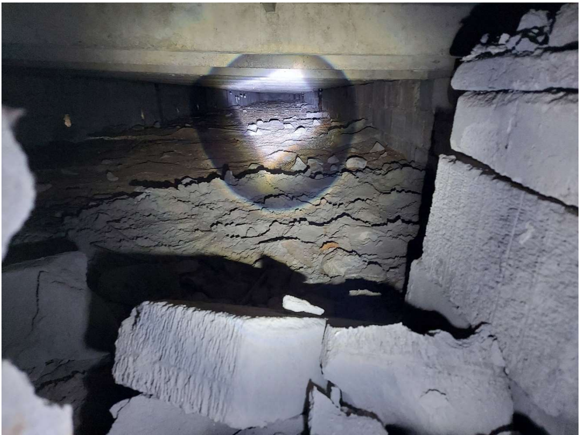
Fot. 2. Widok przestrzeni poddasza nieużytkowego
