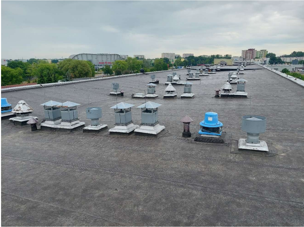
Fot. 4. Segment dachu nr 4
