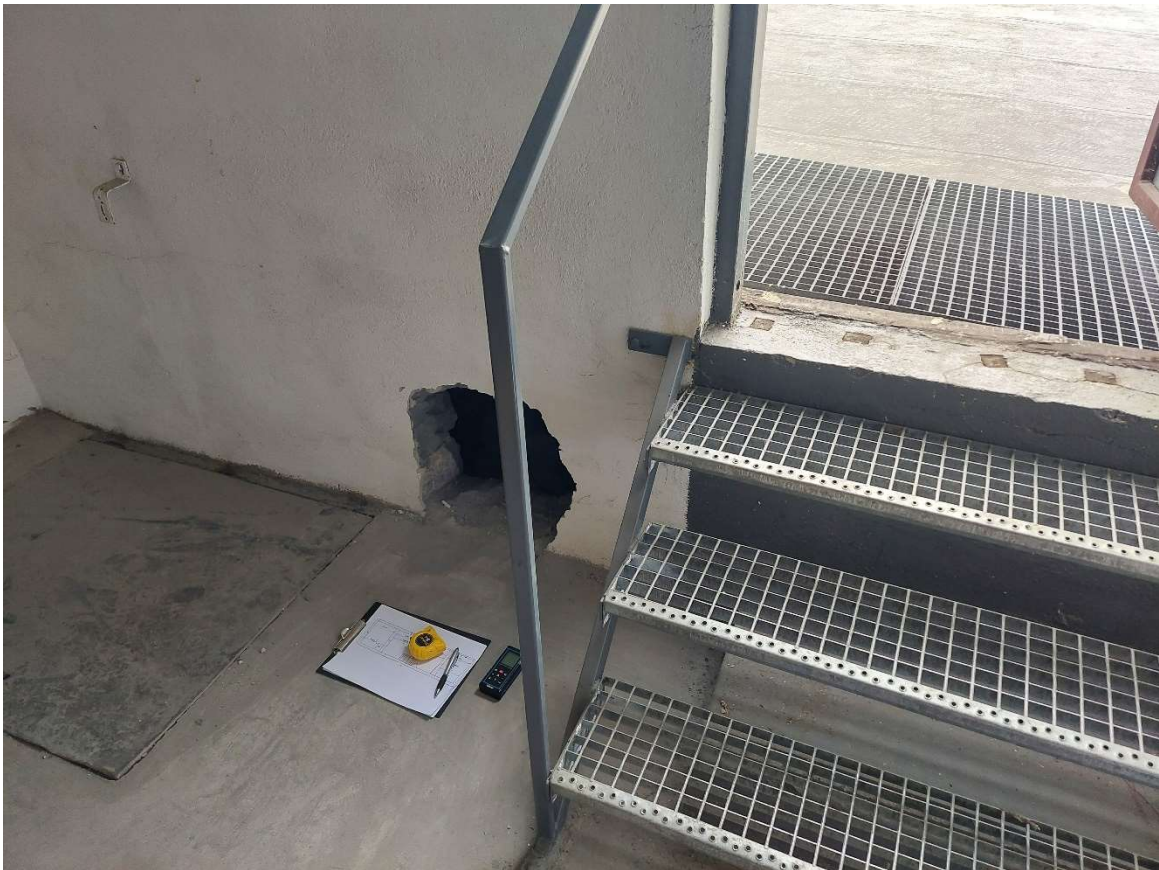
Fot. 5. Widok wykonanej odkrywki w pom. maszynowni
