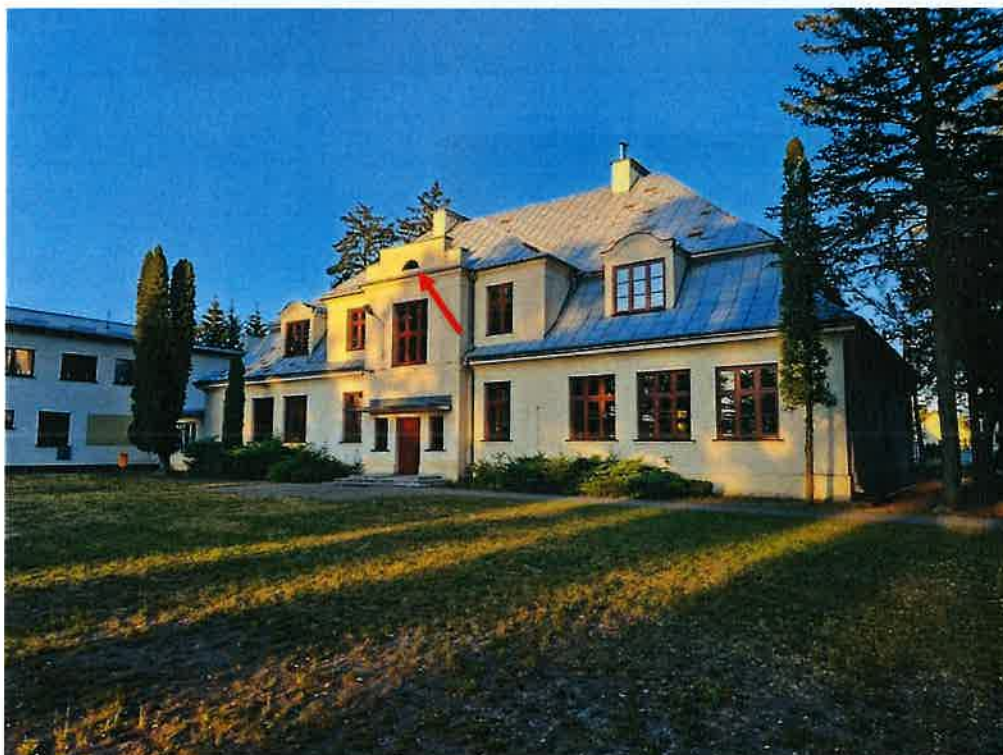
Ryc. 1. Elewacja północno-zachodnia. Zaznaczony wlot do kolonii nietoperzy na strychu budynku.
