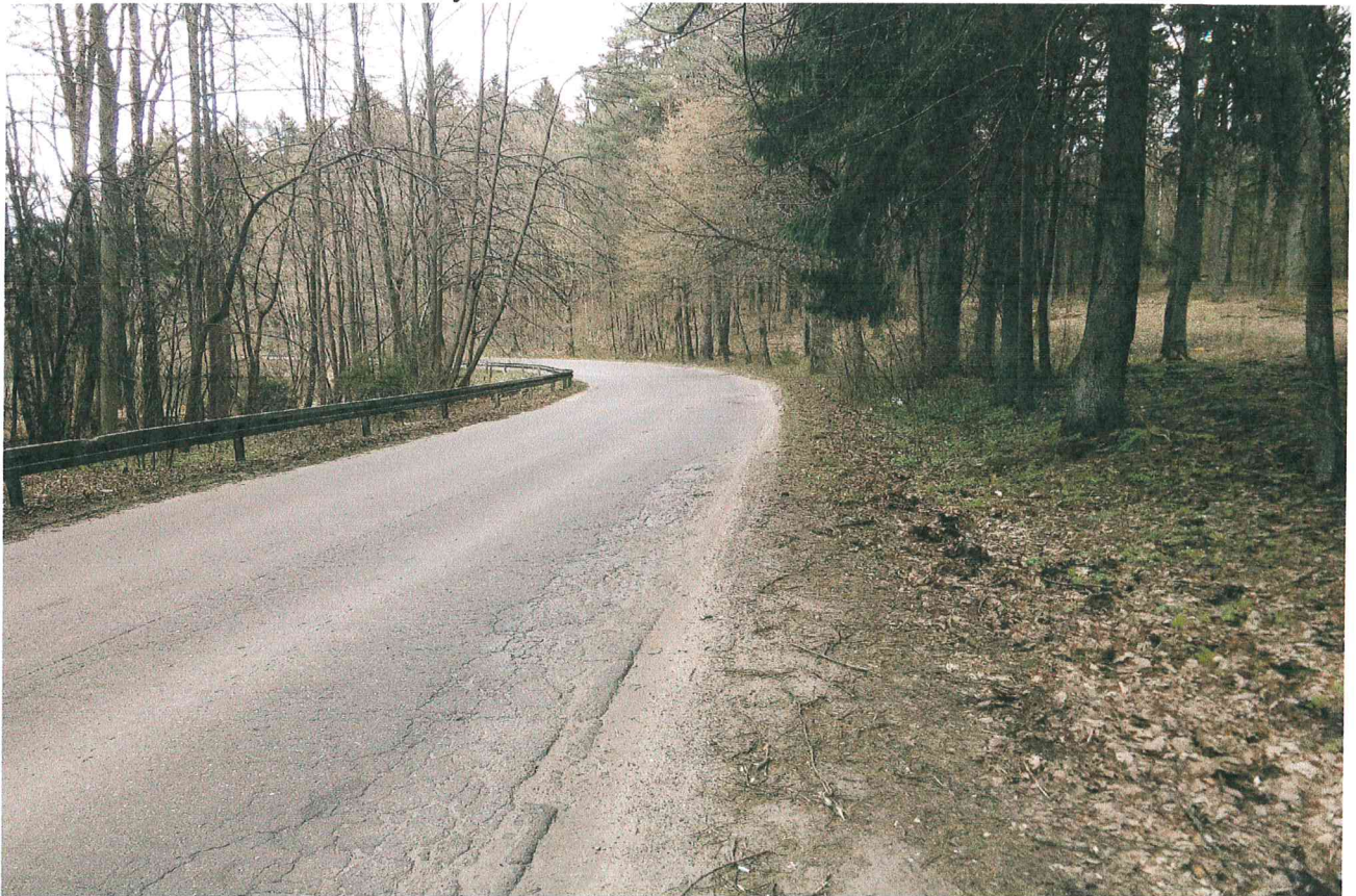
Foto nr4 widok w kierunku Słupów spękania krawędziowe szerokości ok 1m
