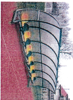
Wiaty w całości pokryta poliwęglanem komorowym bezbarwnym
