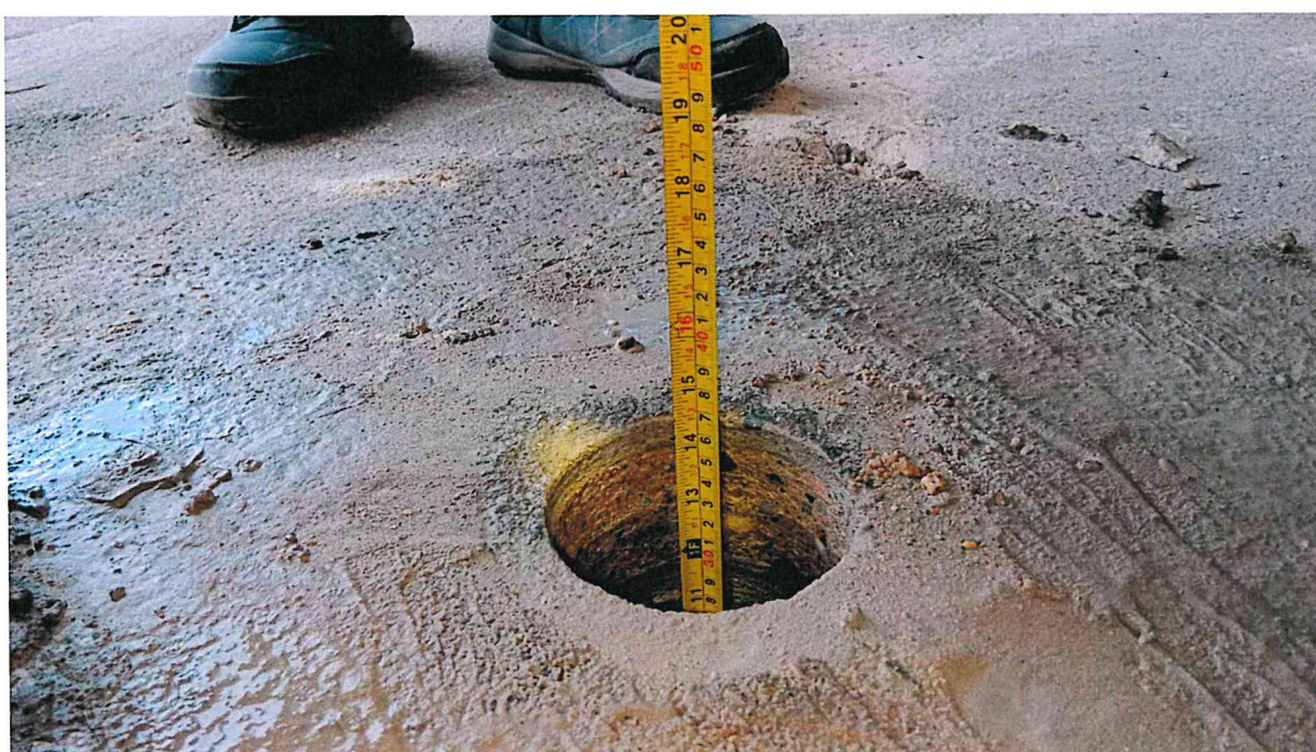
fot. 4 – pomiar głębokości otworu nr 2.
