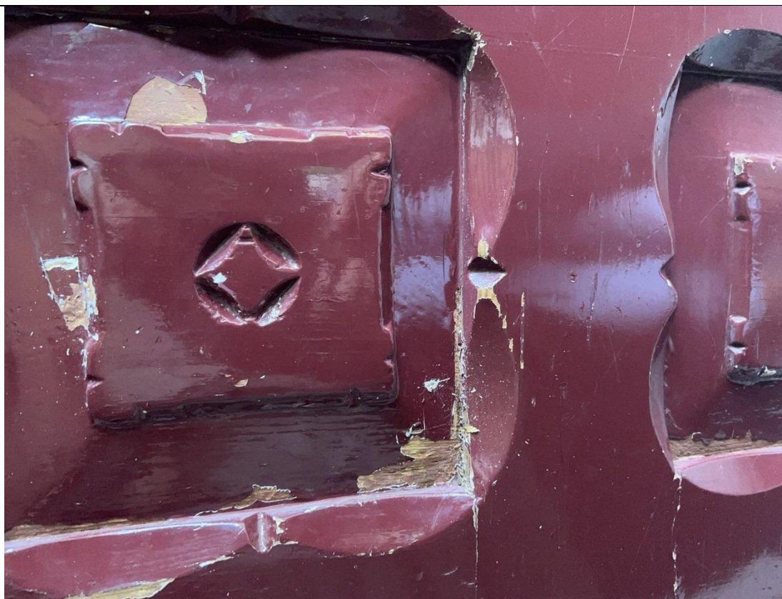
Fot.8. Kętrzyn- stolarka drzwiowa z budynku Starostwa Powiatowego - drzwi główne- stan obecny. Fot. Barbara Kwasiborska.
