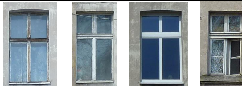
Zbliżenie – okna w elewacji zaplecza
