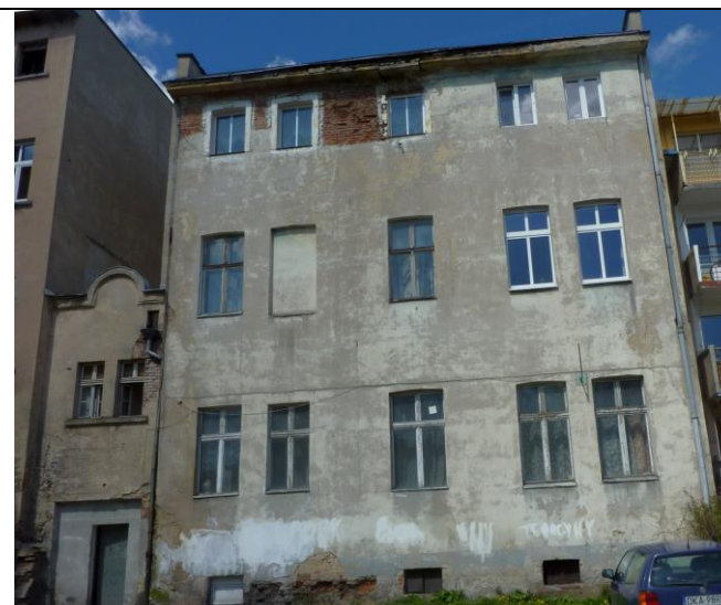
Elewacja zaplecza pd.– wsch.
