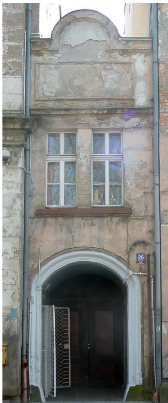
Zbliżenie – przejazd bramowy
