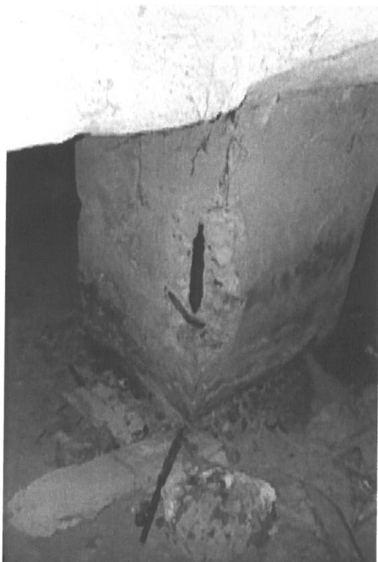
Zdj. nr 4 i 5. Ubytki w konstrukcji słupów podporowych.
