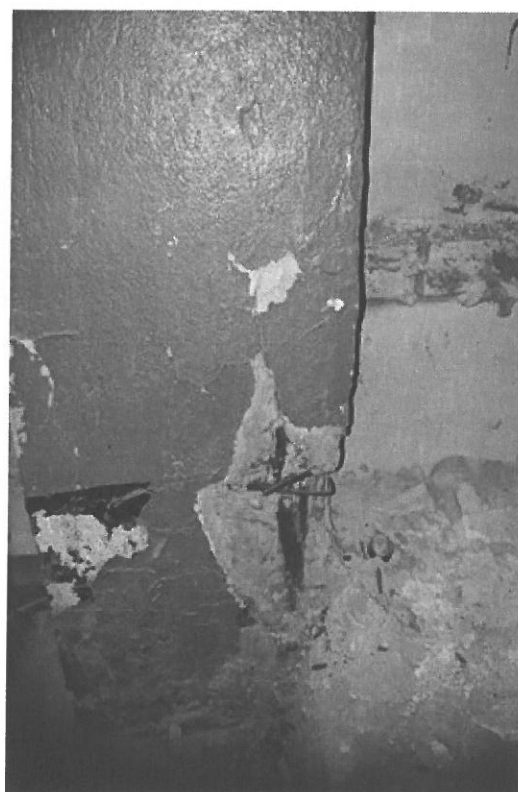
Zdj. nr 4 i 5. Ubytki w konstrukcji słupów podporowych.
