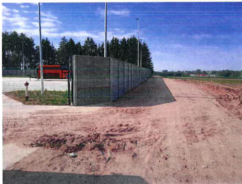
Rysunek 1 Wjazd na teren obiektu
