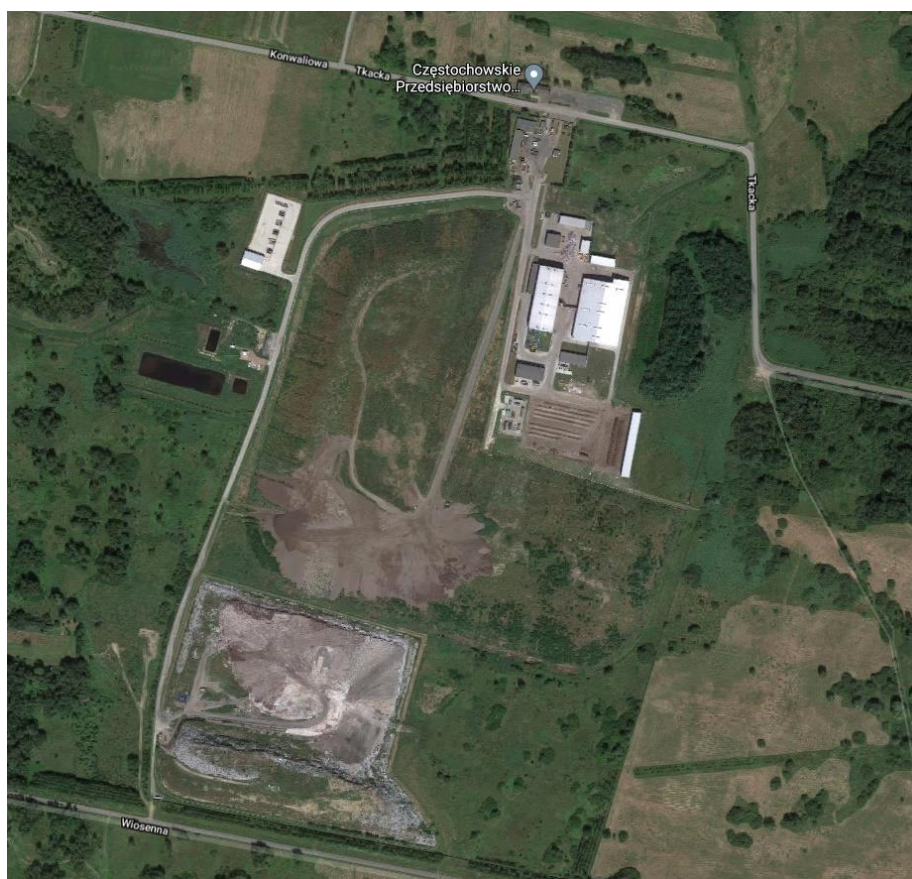
Widok budynków CZPK wraz ze składowiskiem
