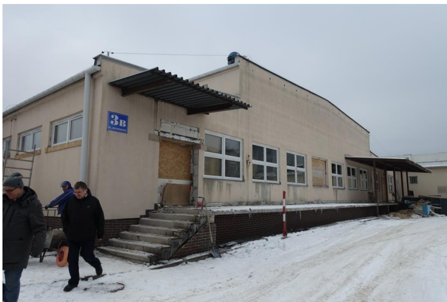
Fot. 1. Budynek dawnej pralni Świętokrzyskiego Centrum Onkologii w widoku od strony północno-wschodniej
