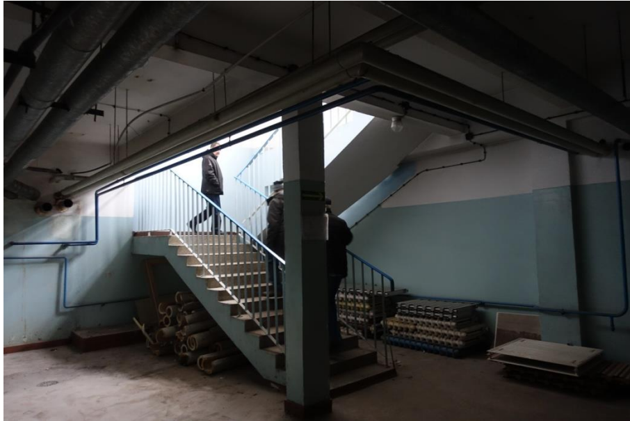
Fot. 7. Klatka schodowa, widoczna z poziomu piwnicy
