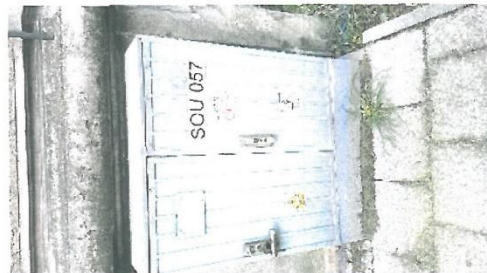
SZAFKA OŚWIEŚLENIOWA 1250x400x900mm FUNDAMENT BETONOWY 1250x400x1400mm
