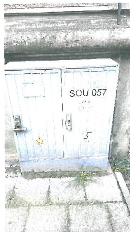
SZAFKA OŚWIETLENIOWA 1250x400x900mm FUNDAMENT BETONOWY 1250x400x1400mm
