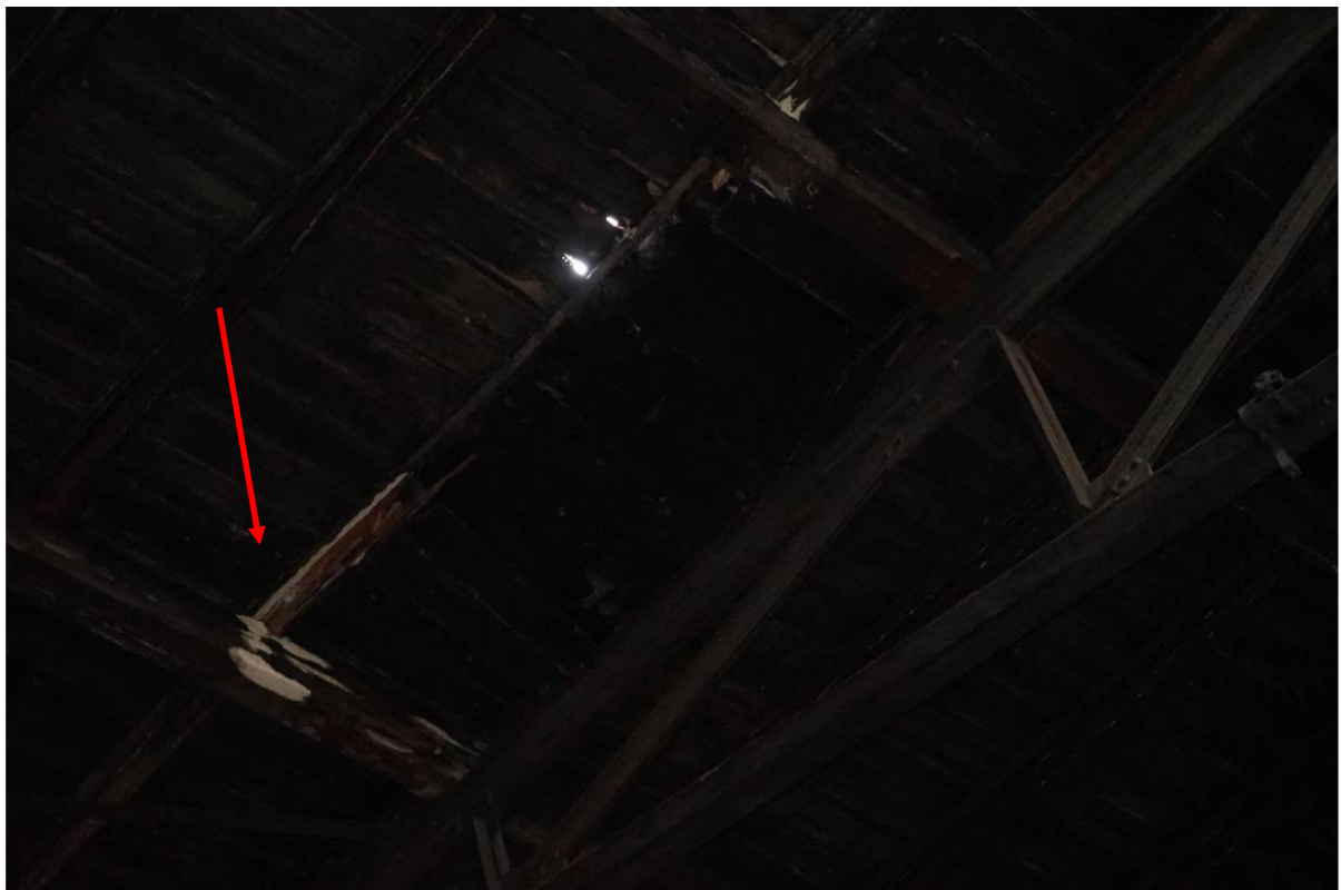
zdz. 4. Widoczne dziury w pokryciu oraz zawilgocone i zaatakowane biologicznie i zniszczone belki konstrukcji dachu.
