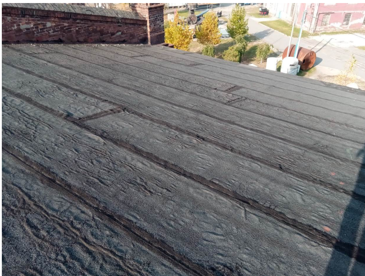
zdj.14,15. Dach nad częścią zachodnią.
