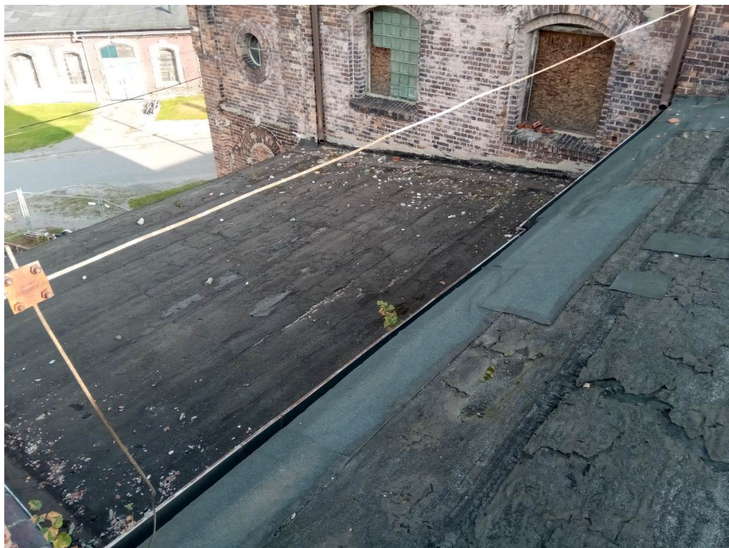
zdj.20,21. Pokrycie dachu od strony północnej
