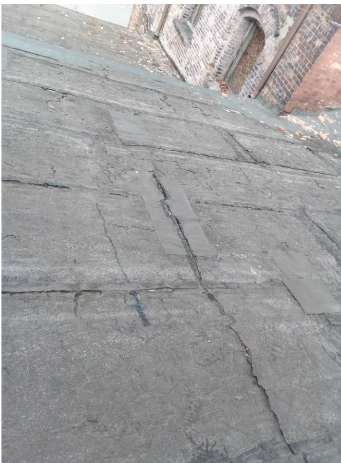
zdj.24. Pokrycie dachu od strony północnej
