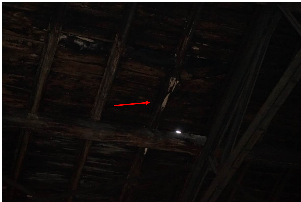
zdj. 1. Widoczne dziury w pokryciu oraz zawilgocone i zaatakowane biologicznie i zniszczone belki konstrukcji dachu.
