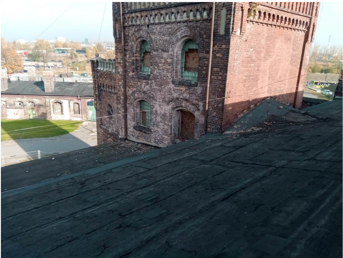
zdj.22,23. Pokrycie dachu od strony północnej.
