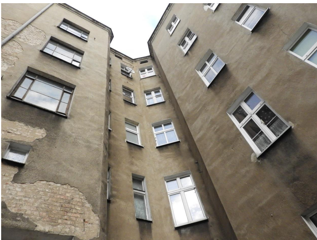
Fot. 6. Elewacja od strony podwórza, oficyna lewa.
