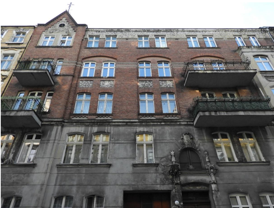
Fot. 2. Elewacja frontowa.
