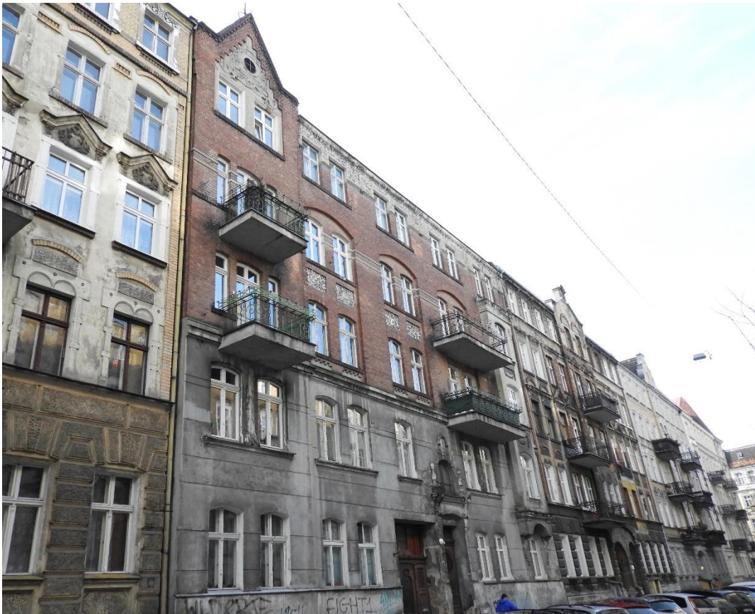
Fot. 1. Elewacja od strony ulicy Kilińskiego.
