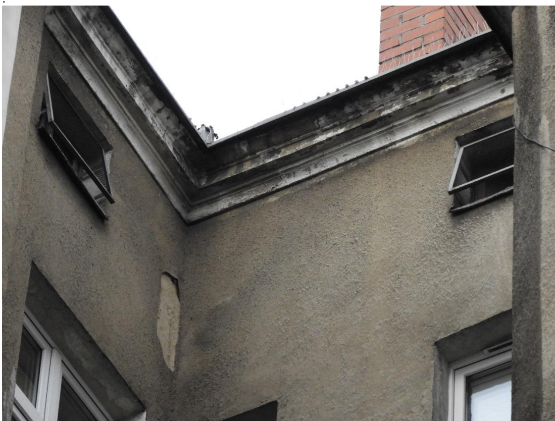
Fot. 10. Uchylone okienka na strych.
