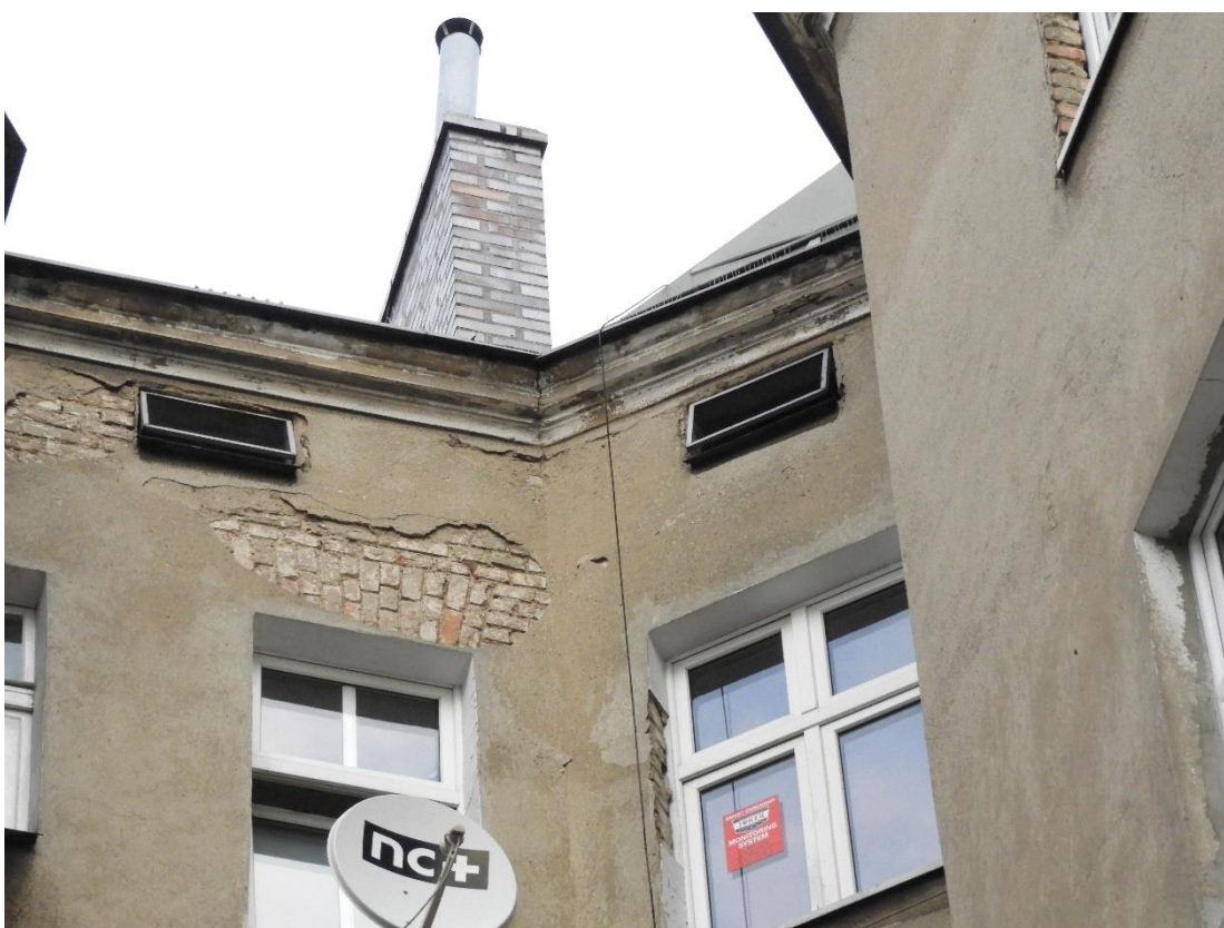
Fot. 8. Elewacja od strony podwórza, uchylone okienka (siatki) na strychu.
