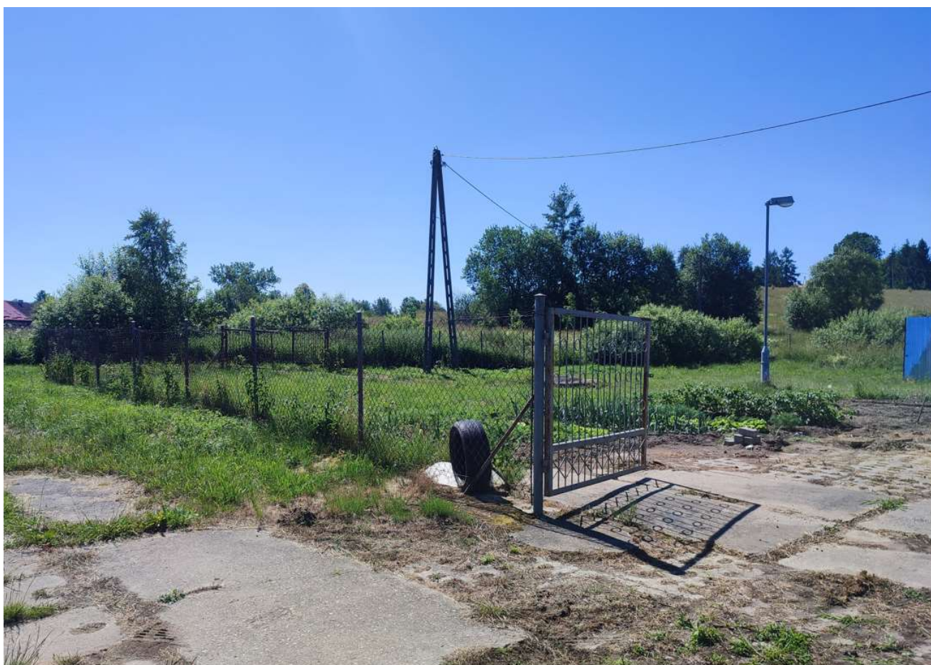
Istniejące ogrodzenie i brama wjazdowa 2
