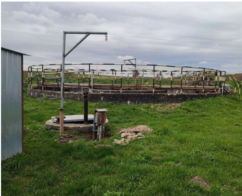
Istniejąca przepompownia ścieków
