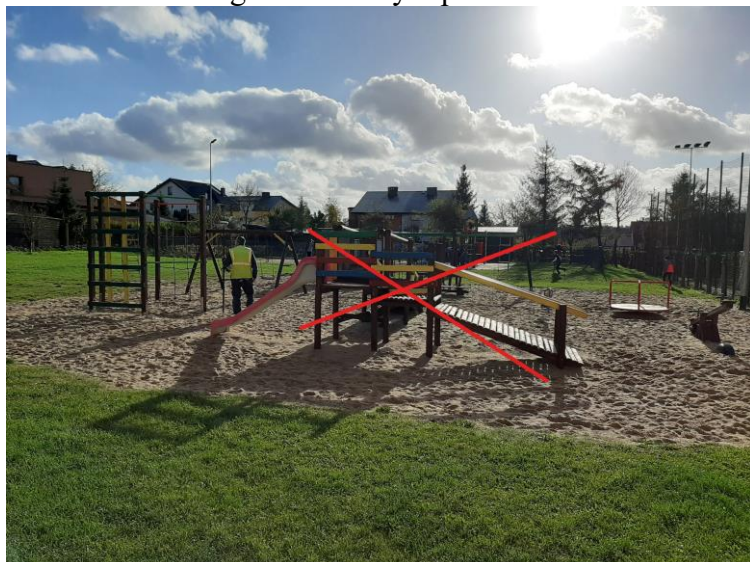
Urządzenie przeznaczone do rozbiórki
