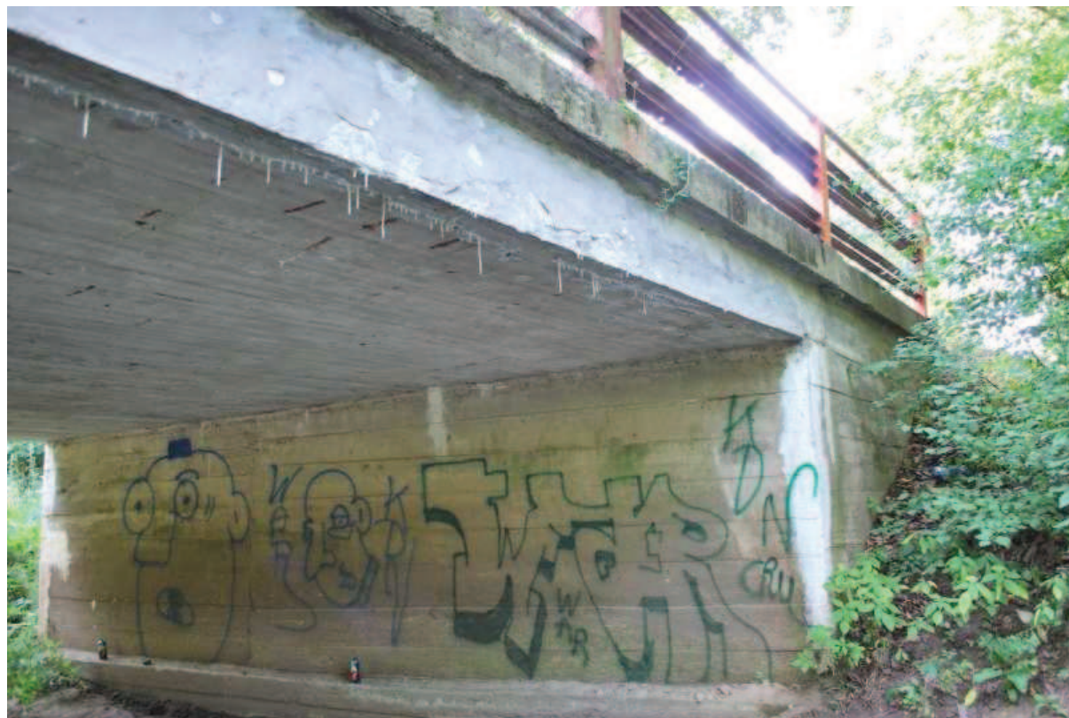
Fot. 2. Widok od strony południowej na przyczółek wschodni.
