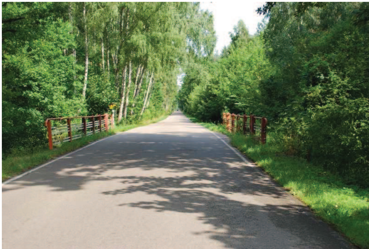
Fot. 1. Widok od strony wschodniej.
