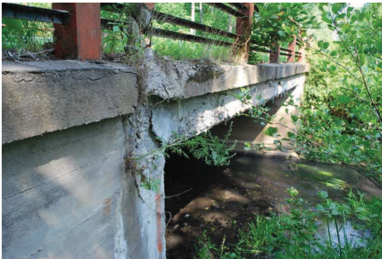
Widok ogólny mostu
