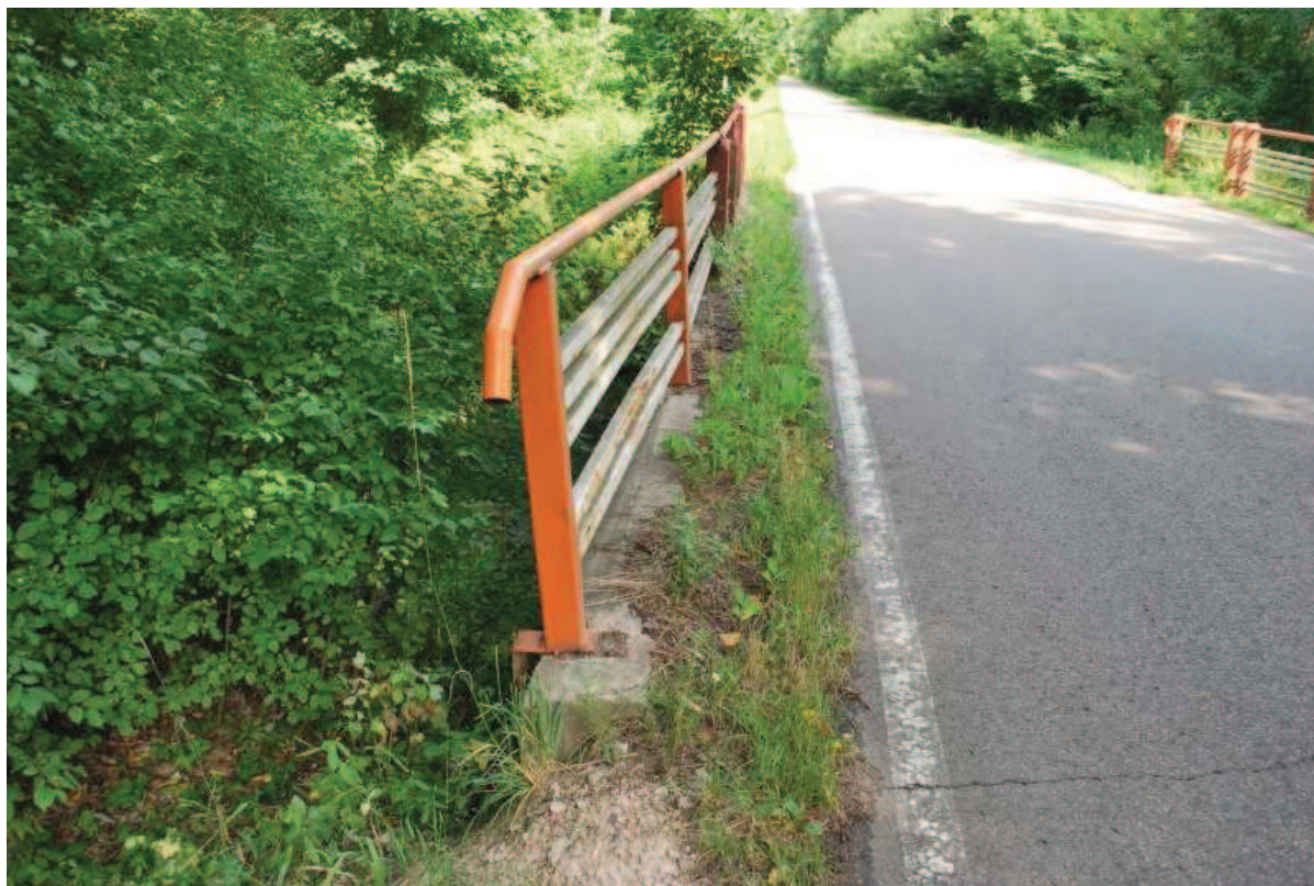
Fot. 13. Widok na intensywną wegetację roślinności po południowej stronie nawierzchni spowodowaną brakiem systematycznych prac utrzymaniowych.
