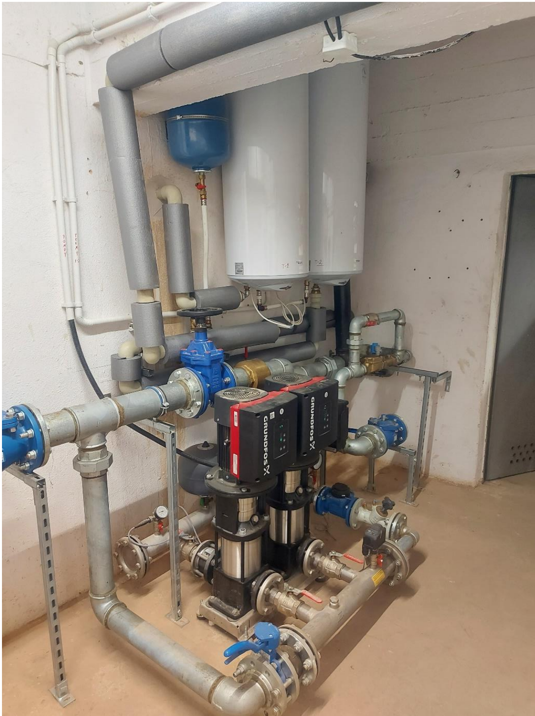
Rysunek 1 Aktualny widok nowej instalacji hydroforowej
