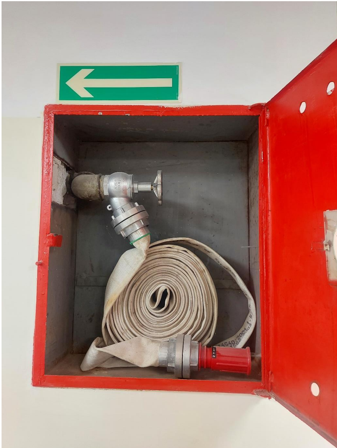
Rysunek 7 Aktualny widok hydrantu wewnętrznego w części niskiej budynku – klatka schodowa
