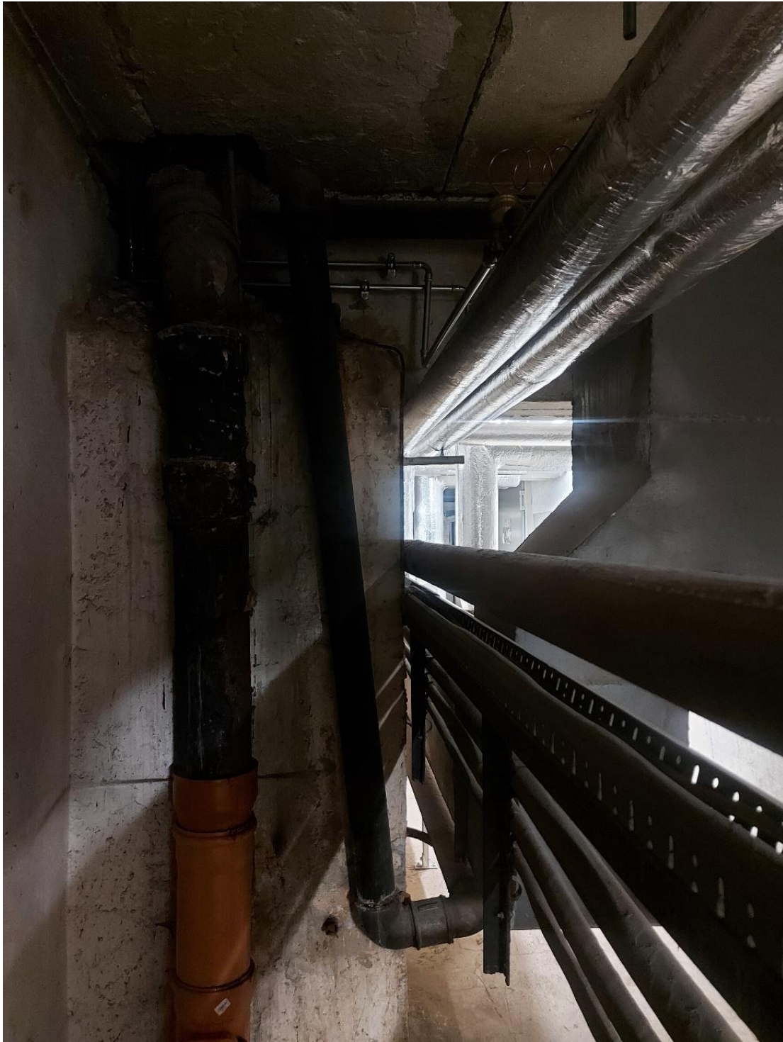
Rysunek 12 Aktualny widok elementów instalacji wodociągowej w części niskiej budynku - piwnica
