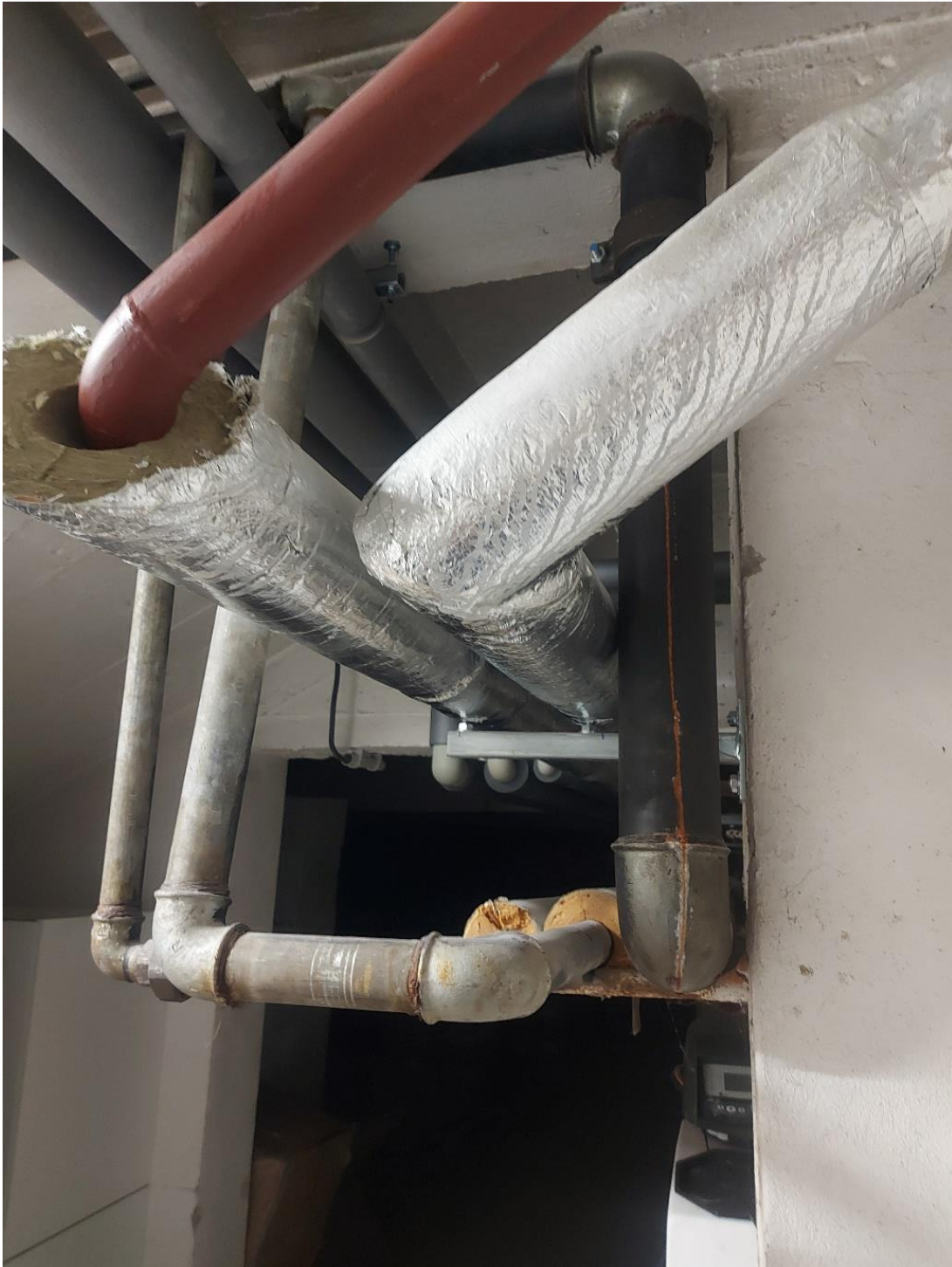
Rysunek 5 Aktualny widok elementów instalacji hydrantowej w części niskiej budynku - piwnica
