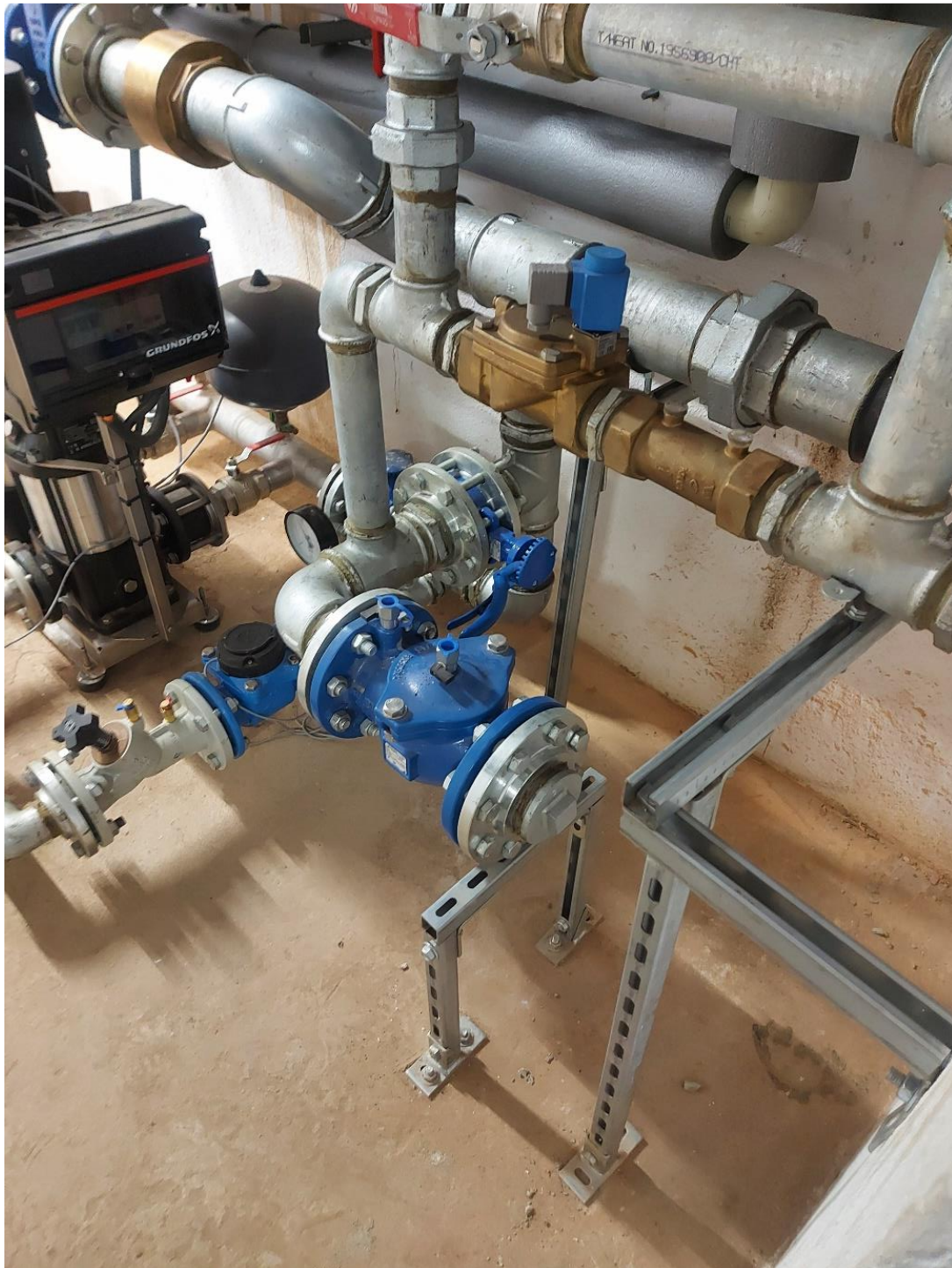
Rysunek 2 Aktualny widok przyłącza planowanej instalacji hydrantowej
