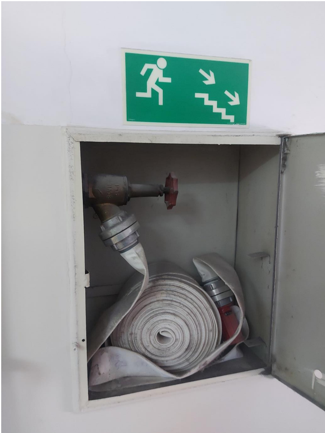
Rysunek 6 Aktualny widok hydrantu wewnętrznego w części wysokiej budynku – klatka schodowa
