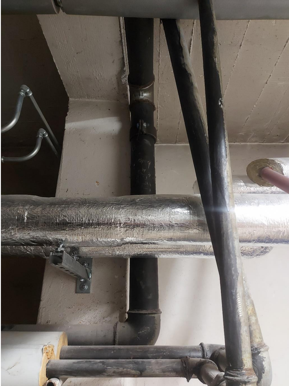
Rysunek 11 Aktualny widok elementów instalacji wodociągowej w części niskiej budynku - piwnica
