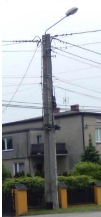
Słup betonowy typu E - podwójny
