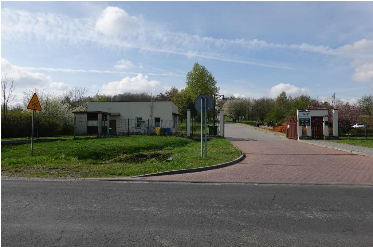
Ryc. 4. Widok na budynek stróżówki od strony ulicy Sosnowej (fot. własna)
