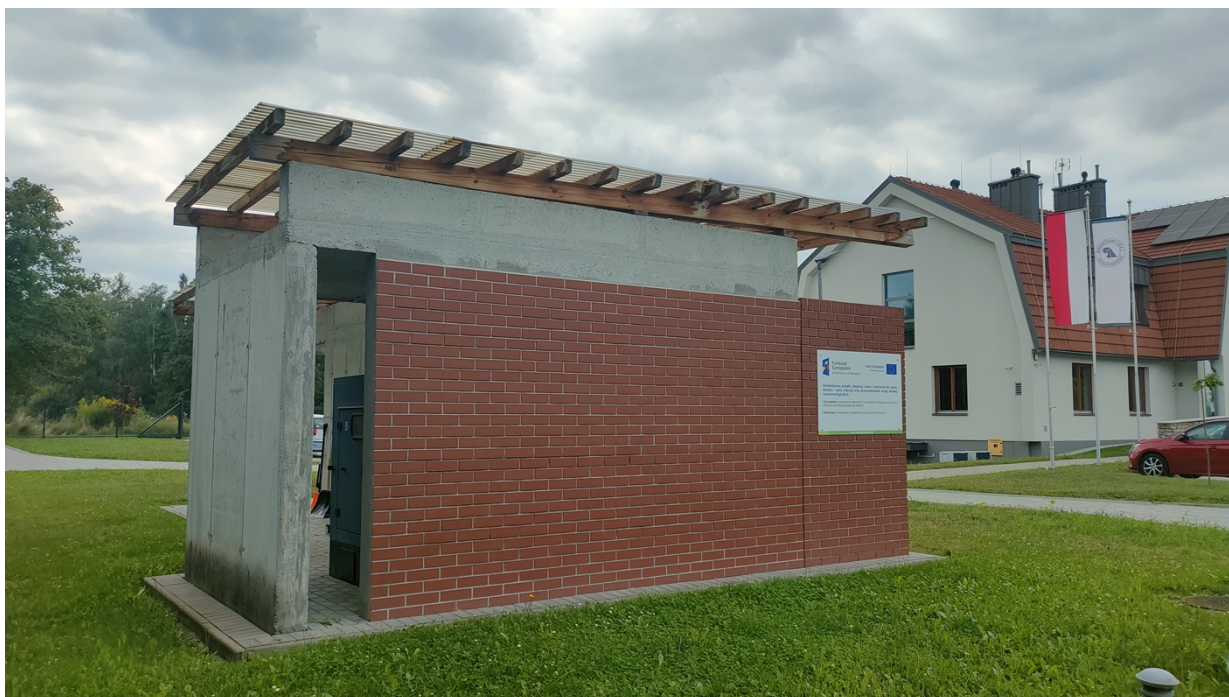
Ryc. 2. Stan istniejący – wiata śmietnikowa (od północy)
