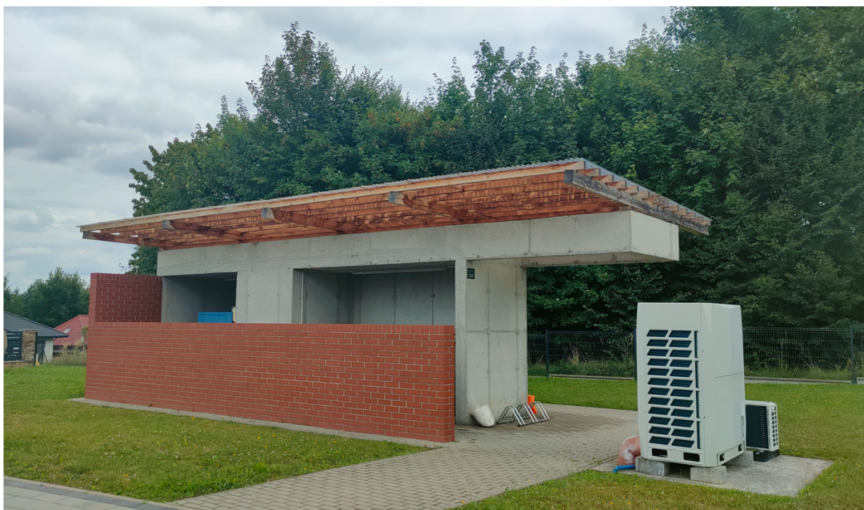
Ryc. 1-3. Stan istniejący – wiaty śmietnikowa (od zachodu)
