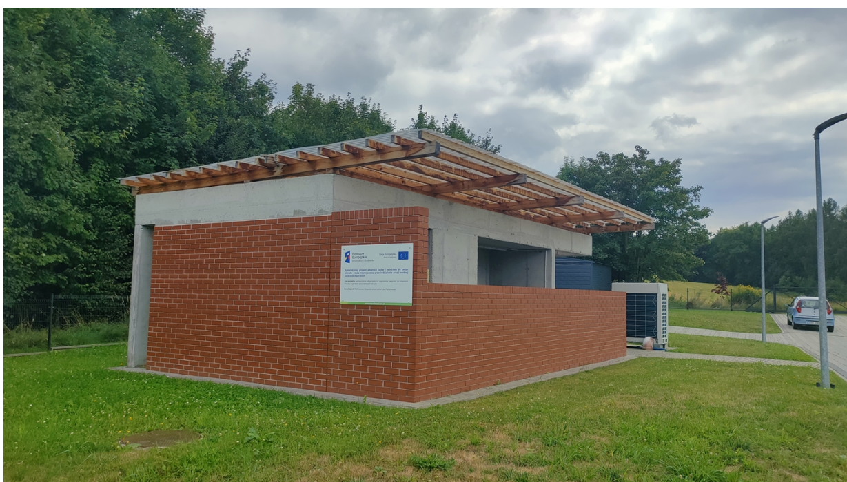
Ryc. 3. Stan istniejący – wiata śmietnikowa (północny -zachód)
