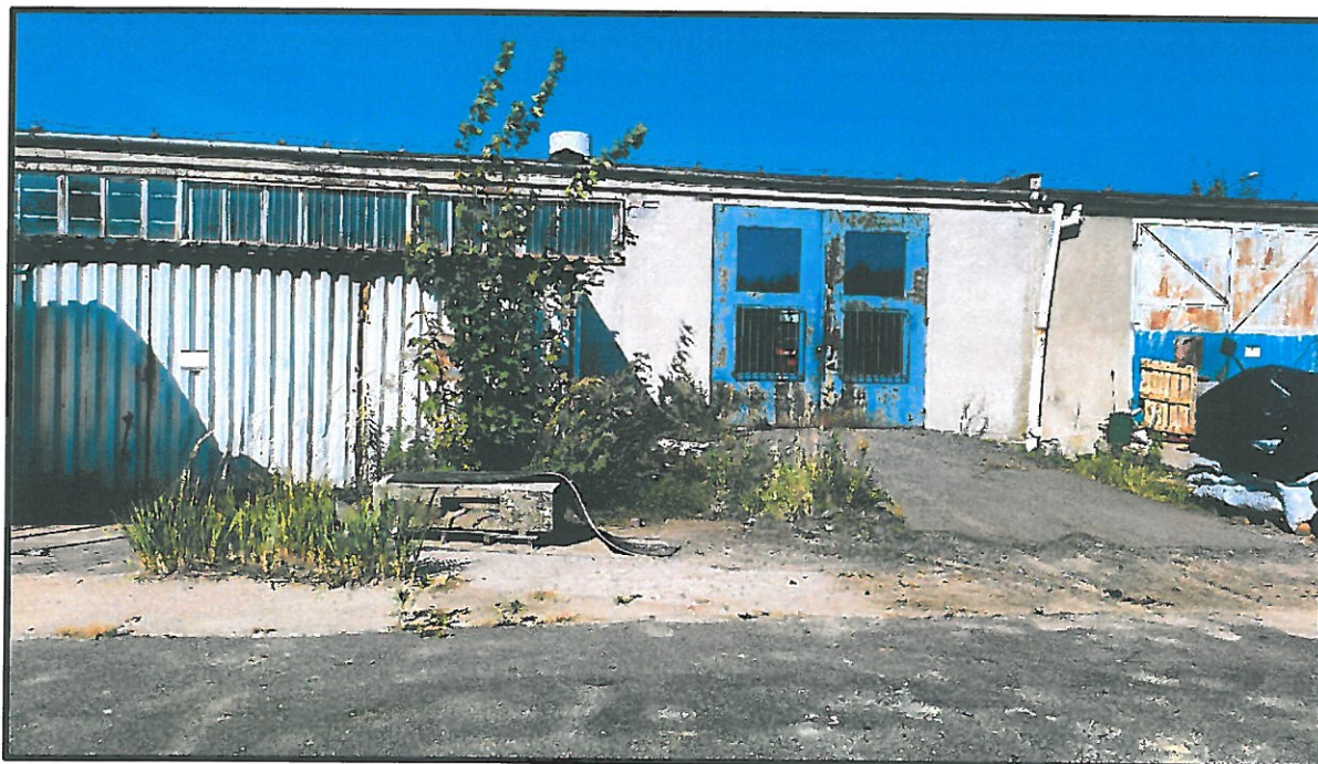
FOT. NR 3 ELEWACJA POŁUDNIOWO-WSCHODNIA
