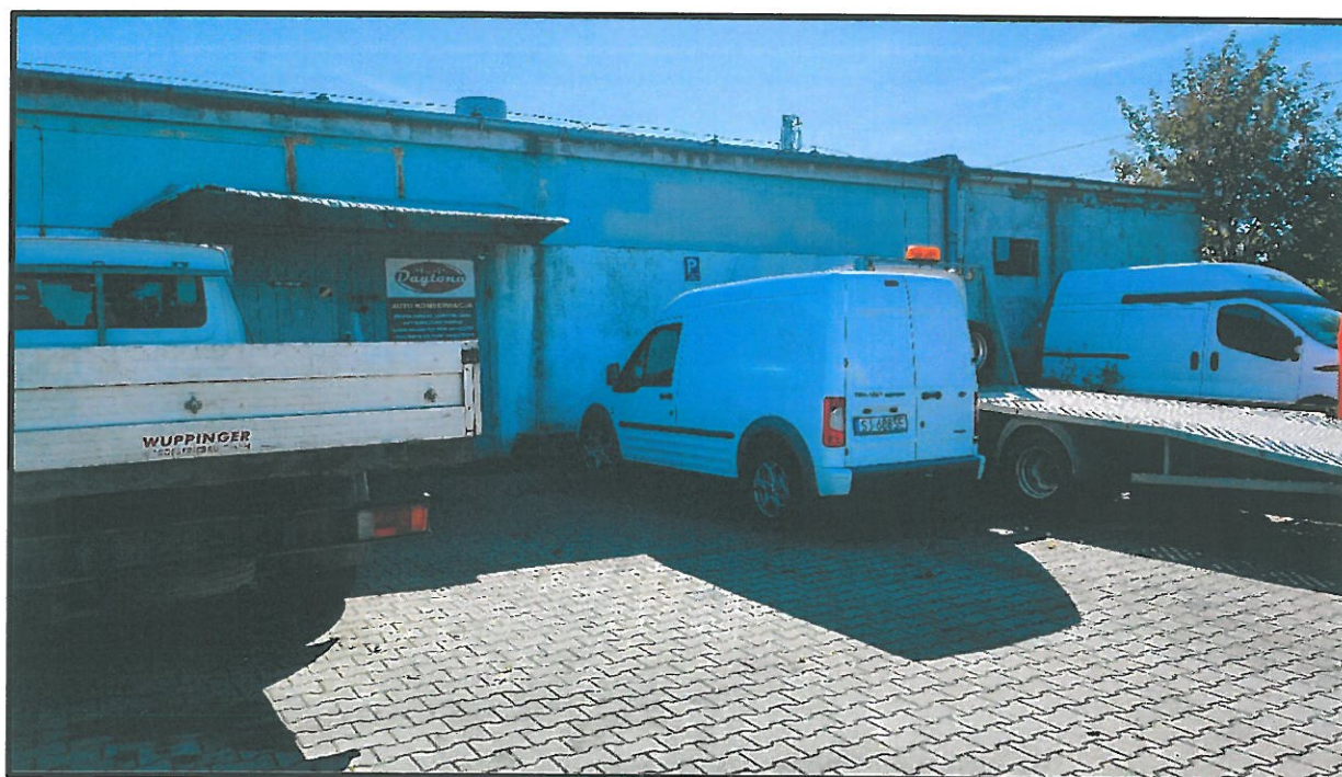
FOT. NR 6 ELEWACJA PÓŁNOCNO-ZACHODNIA
