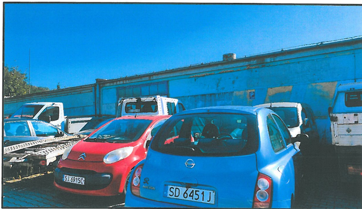
FOT. NR 5 ELEWACJA PÓŁNOCNO-ZACHODNIA
