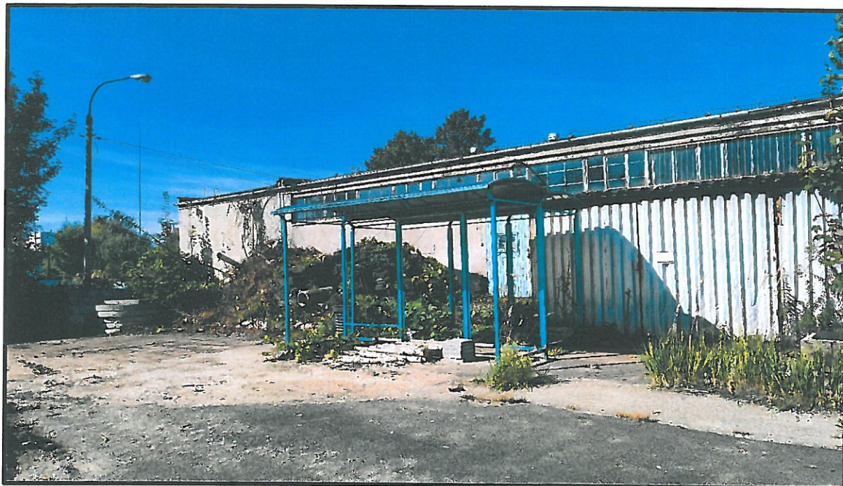
FOT. NR 1 ELEWACJA POŁUDNIOWO-WSCHODNIA
