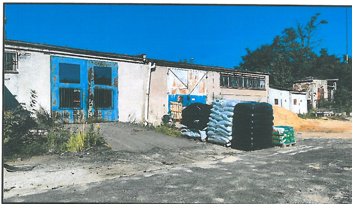
FOT. NR 4 ELEWACJA POŁUDNIOWO-WSCHODNIA
