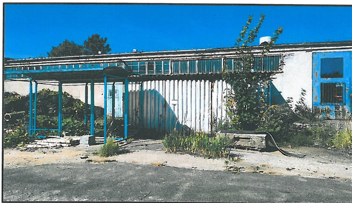
FOT. NR 2 ELEWACJA POŁUDNIOWO-WSCHODNIA
