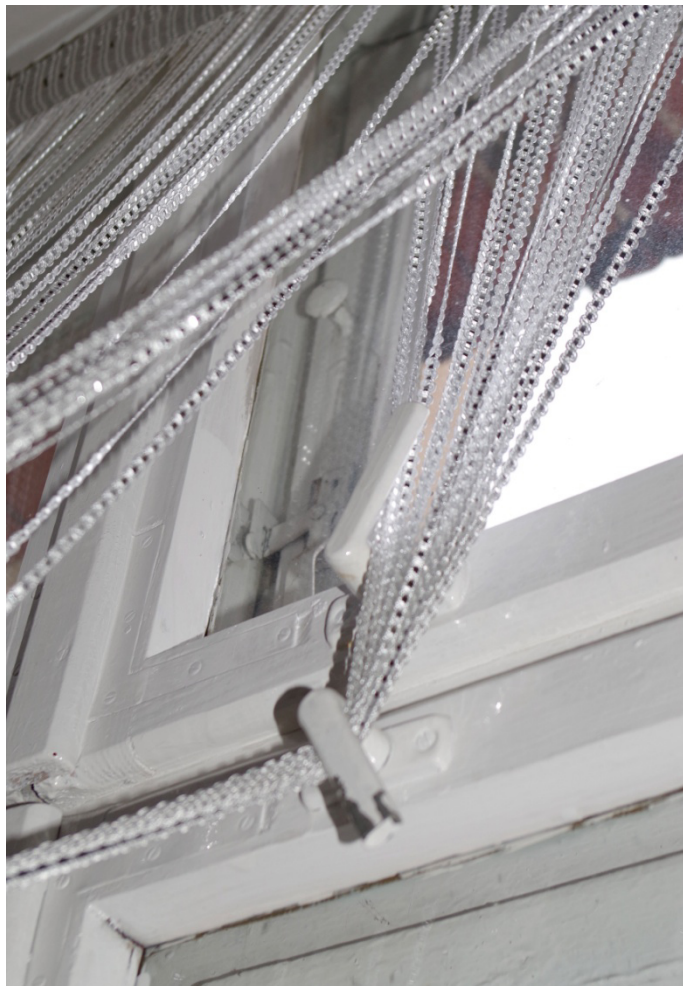
Fot.85. Okno typu O5/2, widok od strony wewnętrznej. Zbliżenie pokazuje wtórne okucia w skrzydle zewnętrznym jak i wewnętrznym oraz pierwotna zachowana gałka.
