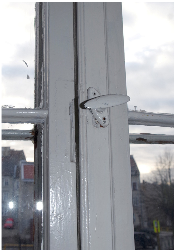
Fot.23. Okno O1/8, widok od strony wewnętrznej. Widoczna wtórna klamka wykonana ze znu oraz próba naprawy ramiaka przy zamku. Skrzydła nie zamykają się przez wzgląd na wypaczenie drewna.
