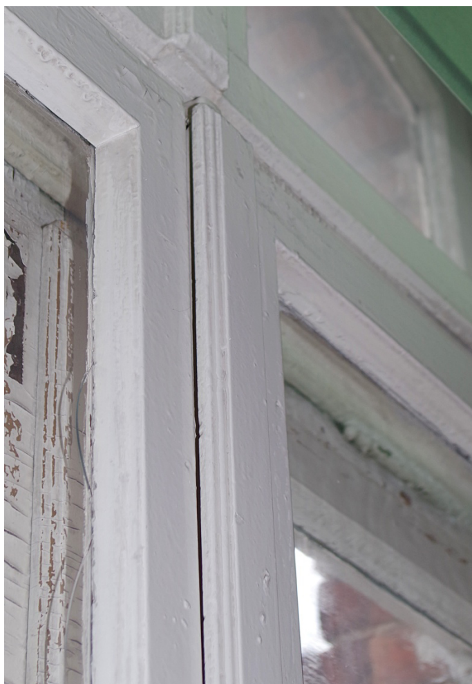
Fot. 15. Okno O1/5, widok od strony wewnętrznej. Widoczne wypaczone skrzydło wraz z listwą przemykową. Baskwil nie trafia w ucho co uniemożliwia zamknięcie okna.
