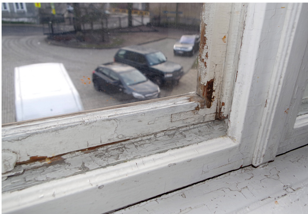
Fot.32. Okno O1/11, widok od strony zewnętrznej. Zbliżenie pokazuje zbutwiałe i zawilgocone drewno ramiaka dolnego. Korozja metalu przyspiesza destrukcję drewna.
