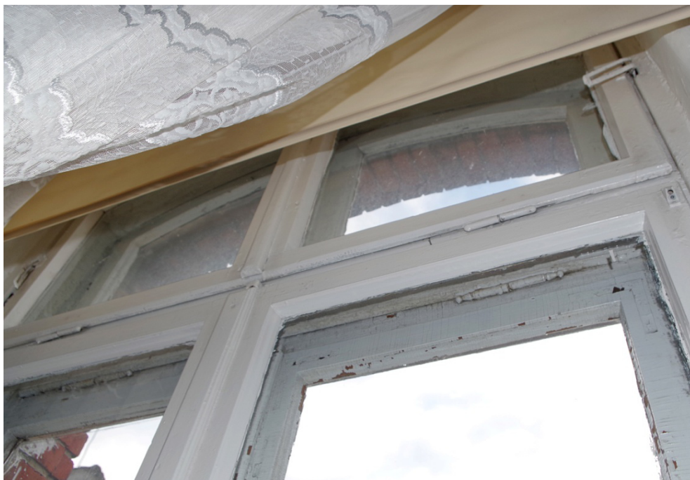
Fot.26. Okno O1/9, widok od strony wewnętrznej. Zbliżenie pokazuje wtórne skrzydło wewnętrzne nadślemienia wraz z wtórnymi zawiasami.
