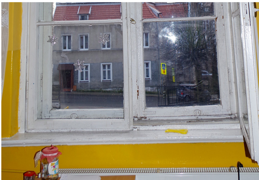
Fot.29. Okno O1/10, widok od strony wewnętrznej. Zbliżenie pokazuje brak pierwotnych przytrzymywaczy grzebieniowych.
