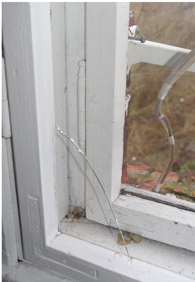
Fot.83. Okno typu O5/1, widok od strony wewnętrznej. Widoczne pierwotne skrzydło zewnętrzne z ozdobnym zawiasem oraz wtórne skrzydło wewnętrzne z pękniętą szybą w wyniku naprężeń drewna.
