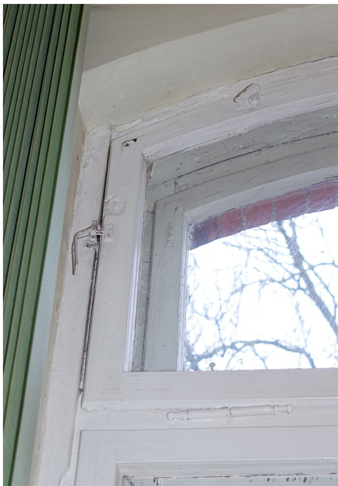
Fot.44. Okno O1/15, widok od strony wewnętrznej. Zbliżenie pokazuje wtórny przytrzymywacz oraz ślad po pierwotnym, u góry wtórna klamka ze znanu.
