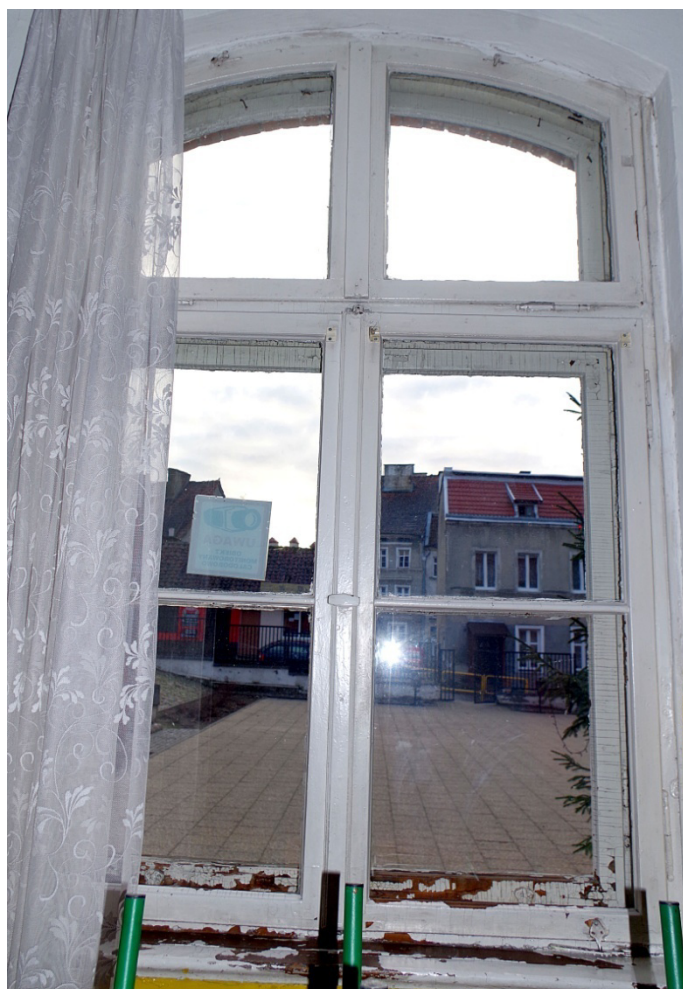
Fot. 4. Okno O1/2, widok od strony wewnętrznej. Widoczne duże ubytki warstwy malarskiej w dolnej partii okna oraz wtórna listwa przymykowa w skrzydle nadślemienia. Listwa jest uproszczona i nie powtarza profilowań oryginału.
