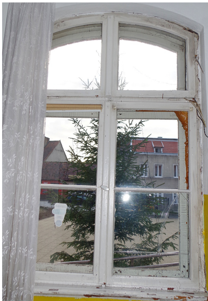
Fot. 1. Okno O1/1, widok od strony wewnętrznej. Widoczne wtórne skrzydło wewnętrzne podślemienia po stronie lewej. skrzydło ma fazowane krawędzie ramiaków i szpros.
