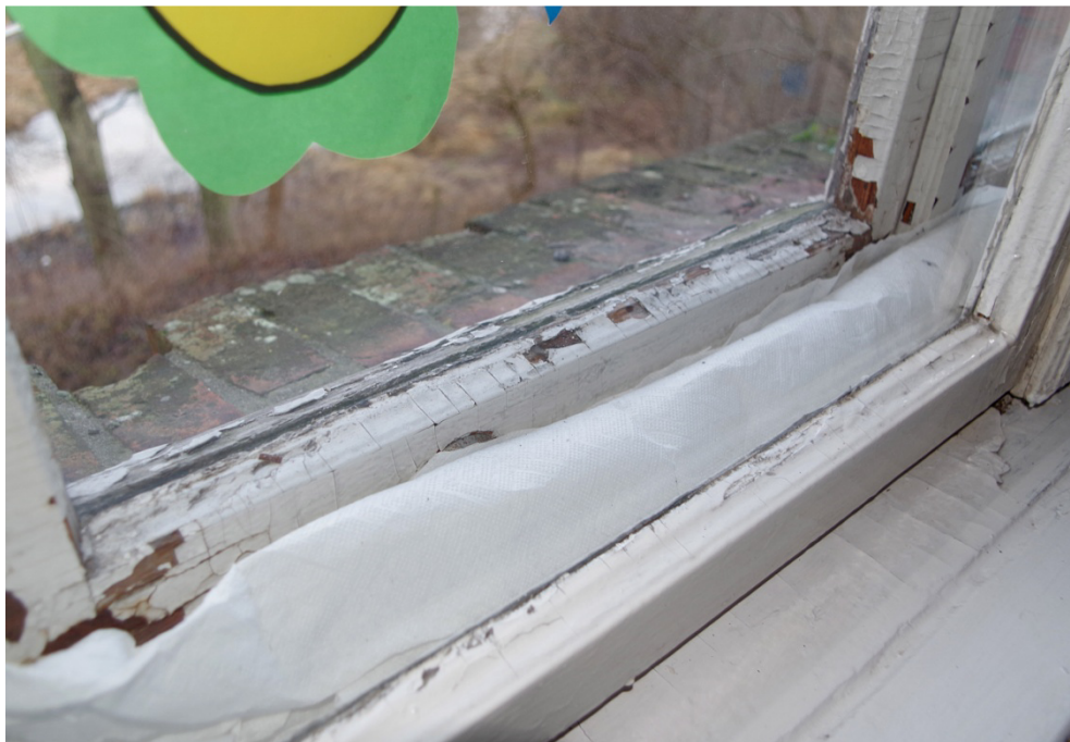
Fot.57. Okno O1/20, widok od strony wewnętrznej. Zbliżenie pokazuje docieplenie nieszczelnego okna za pomocą materiału. Dolna część ramiaka skrzydła zewnętrznego zawilgocona, widoczne spękanie i odspojone warstwy malarskie. Destrukcja okapnika.
