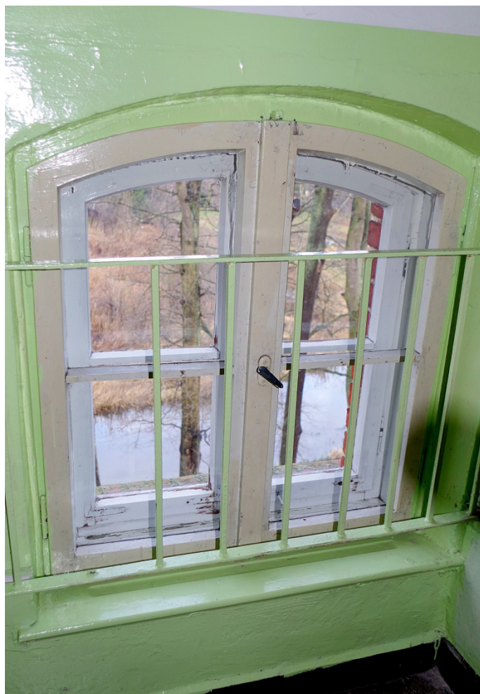
Fot.81. Okno typu O4, widok ogólny od strony wewnętrznej. Stolarstwo jest wtórne, uproszczone, wzorowane na okno pierwotne.
