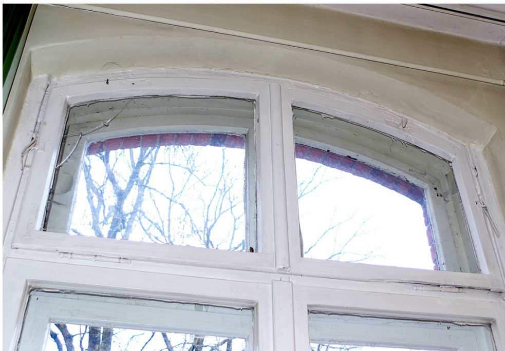
Fot.41. Okno O1/14, widok od strony wewnętrznej. Zbliżenie pokazuje wtórne skrzydło wewnętrzne nadświetlenia oraz wtórne klamki wykonane ze znułu.
