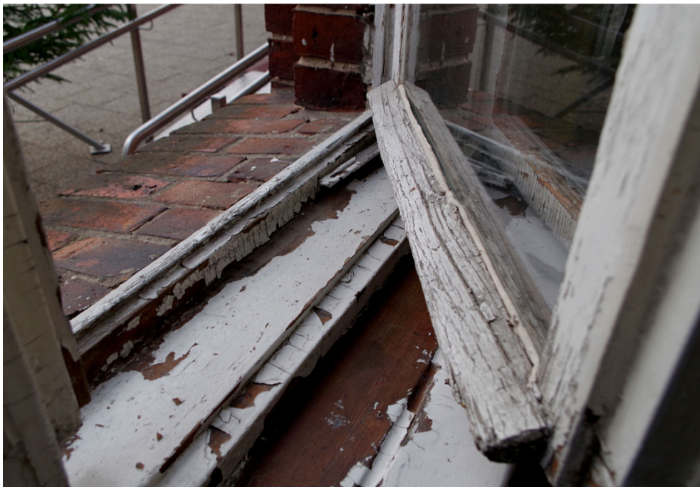
Fot. 5. Okno O1/2, widok od strony wewnętrznej. Widoczny zły stan zachowania okapnika, drewno wypłukane, ubytki formy.
