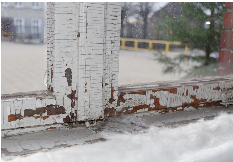
Fot. 8. Okno O1/3, widok od strony wewnętrznej. Widoczne mocno spękanie i odspojone warstwy malarskie oraz baskwil, który nie trafia w ucho. Skrzydła mocno wypaczone, dolne ramiaki zawilgocone.
