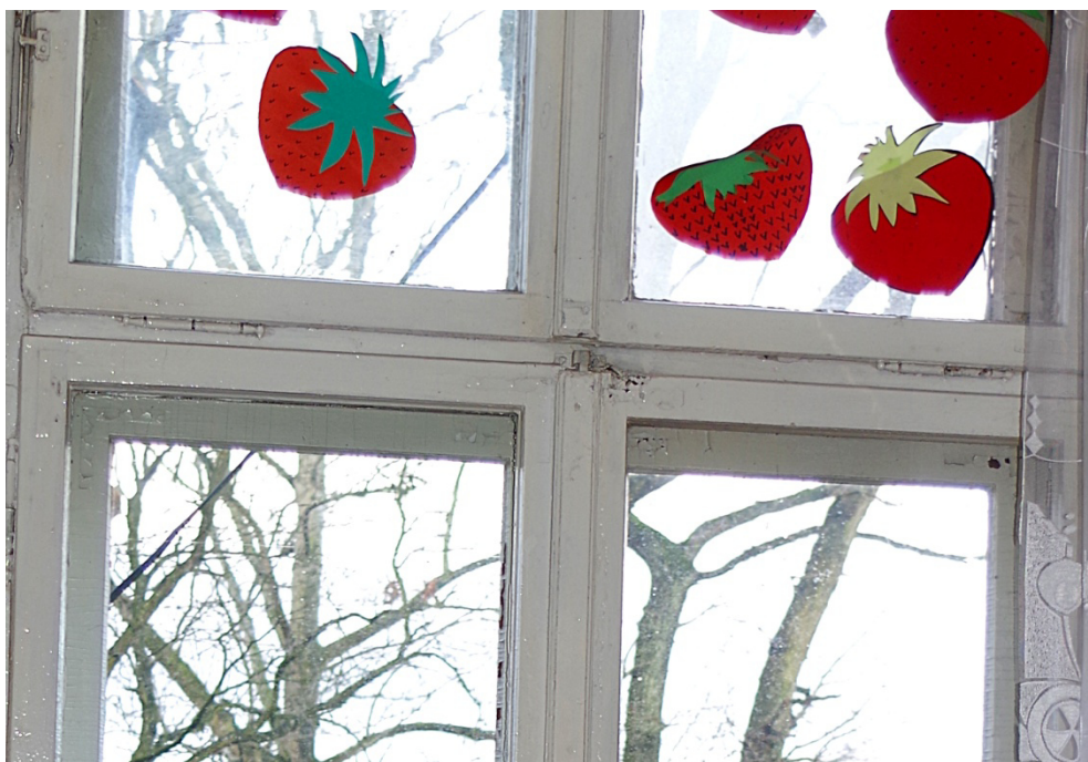
Fot.58. Okno O1/20, widok od strony wewnętrznej. Zbliżenie pokazuje baskwil skrzydeł podsłemiesienia nie trafiający w ucho oraz ubytki mechaniczne ramiaka spowodowane domykaniem skrzydła za pomocą gwoźdźcia.
