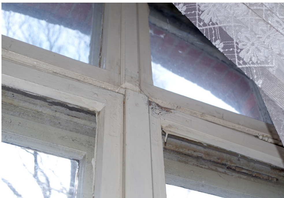
Fot.67. Okno O1/23, widok od strony wewnętrznej. Zbliżenie pokazuje, wtórne wypaczone skrzydła podślemienia wraz z uproszczoną listwą przymykową.
