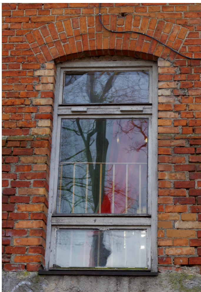
Fot.86. Zdjęcie pokazuje wtórne okno elewacji tylnej doświetlające klatkę schodową. Okno osadzono w zmienionym otworze.
