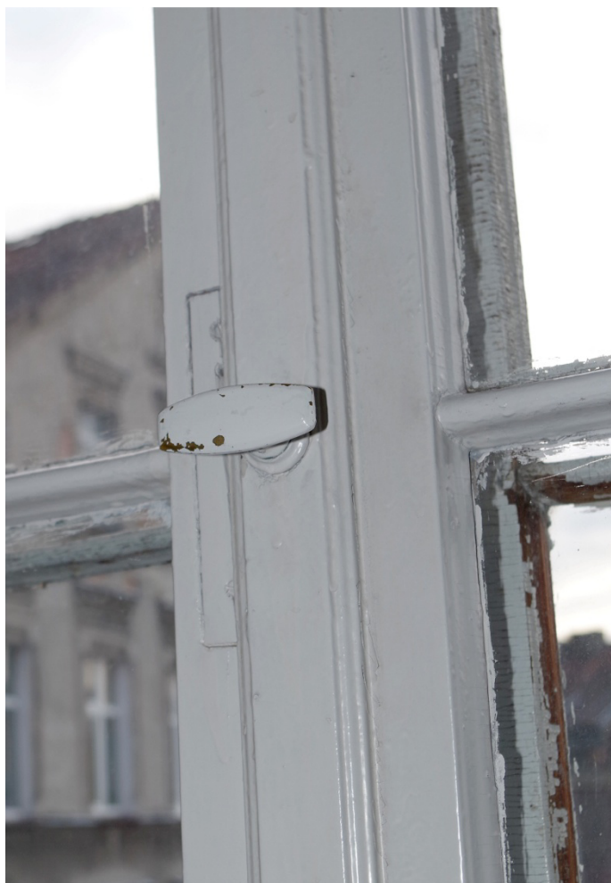
Fot.27. Okno O1/9, widok od strony wewnętrznej. Zbliżenie pokazuje próbę flekowania skrzydła w okolicy zamka. Skrzydła są wypaczone i flek nie spowodował prawidłowego domyknięcia okna.
