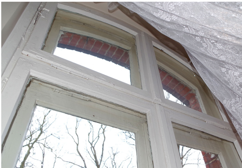
Fot.70. Okno O1/25, widok od strony wewnętrznej. Zbliżenie pokazuje wtórne przytrzymywacze w skrzydle nadświetlenia i brak zakrętki zamykającej okno.
