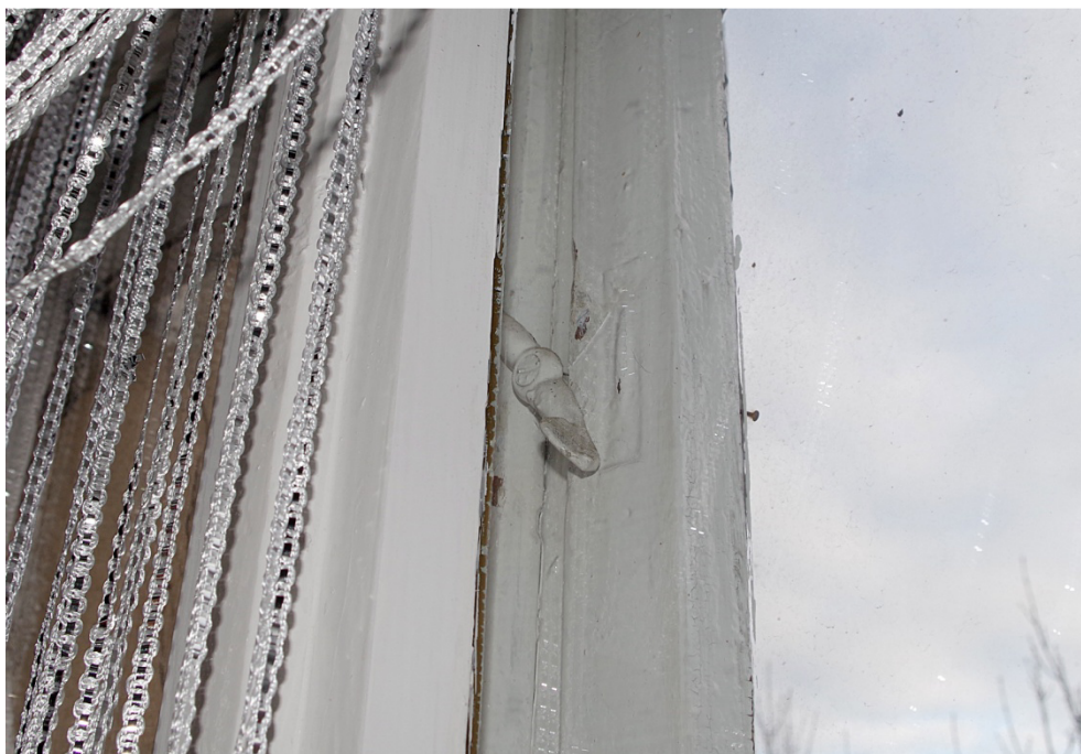
Fot.83. Okno typu O5/1, widok od strony wewnętrznej. Zbliżenie pokazuje pierwotną zakrętkę dwuskrzydłkową zamocowaną w stałym słupku.
