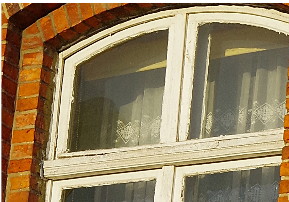
Fot.30. Okno O1/10, widok od strony zewnętrznej. Zbliżenie pokazuje wypaczenie skrzydeł zewnętrznych uniemożliwiające domykanie skrzydeł.
