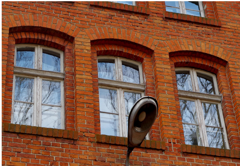
Fot.75. Okna typu O2 w elewacji tylnej, widok od strony zewnętrznej. Widoczne pierwotne ślężona oraz wtórne skrzydła z uproszczonymi listwami przymykowymi.
