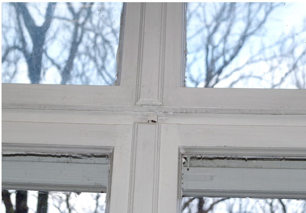
Fot.38. Okno O1/13, widok od strony wewnętrznej. Zbliżenie pokazuje poprawnie osadzony baskil w uchu. Okno dobrze się zamyka.
