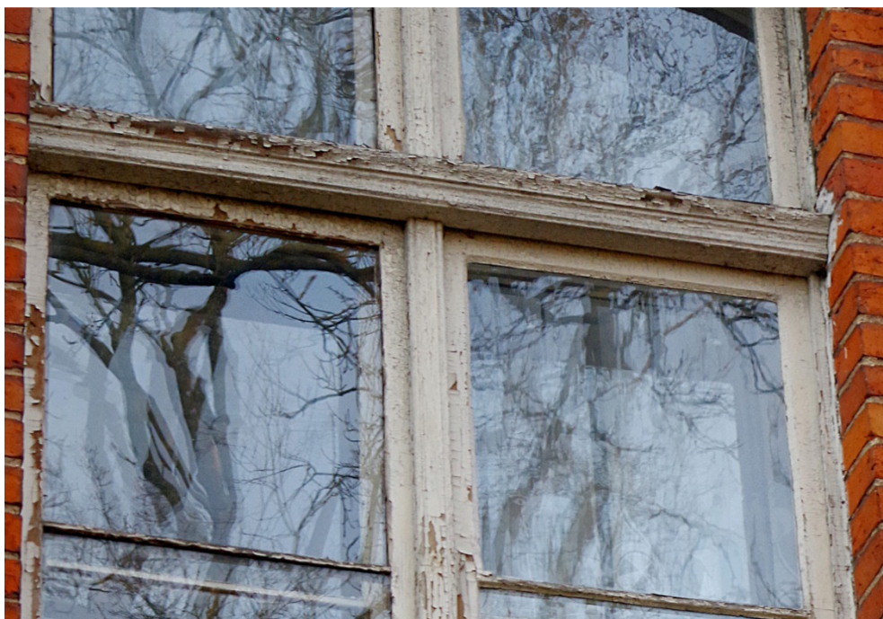
Fot.63. Okno O1/22, widok od strony zewnętrznej. Zbliżenie pokazuje wypaczenie skrzydeł podślemienia, widoczna szpara pod ślemieniem, która powoduje przenikanie wilgoci do wewnątrz skrzynki.
