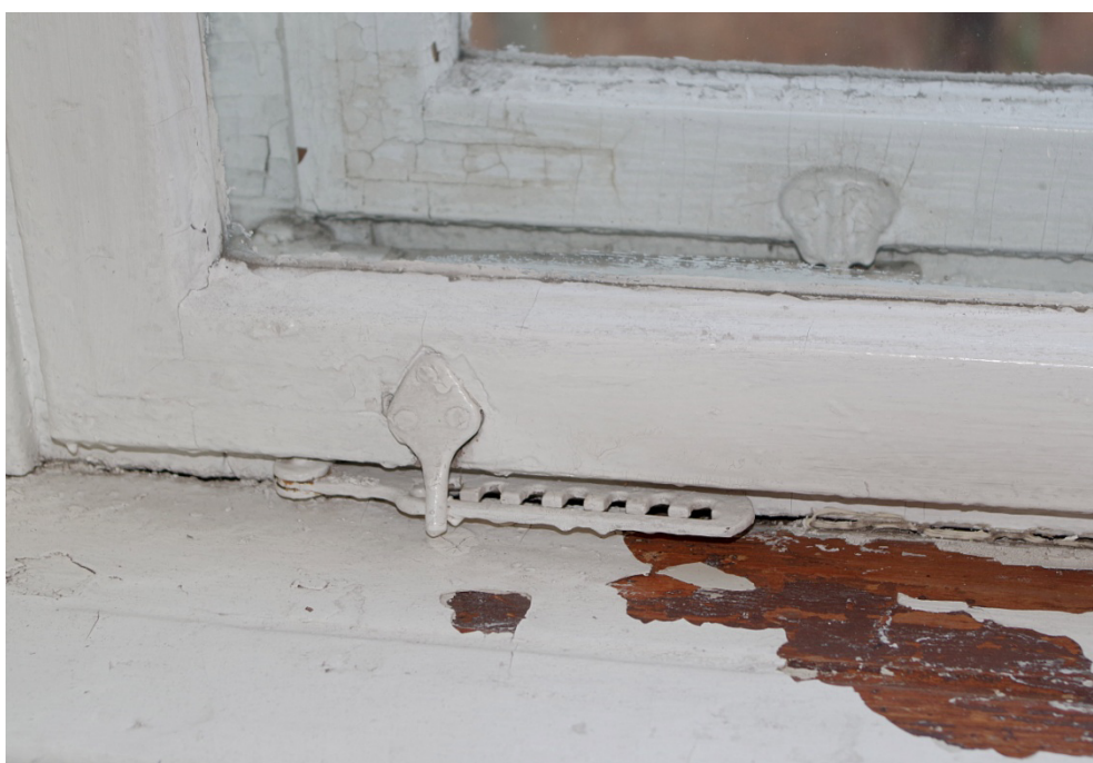
Fot.39. Okno O1/13, widok od strony wewnętrznej. Zbliżenie pokazuje zachowany przytrzymywacz grzebieniowy oraz wtórny haczyk od przytrzymywacza w skrzydle zewnętrznym.
