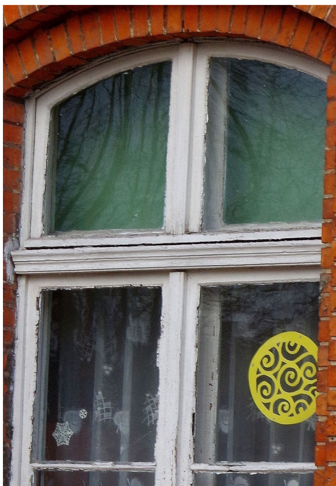
Fot. 12. Okno O1/4, widok od strony zewnętrznej. Zbliżenie na wtórne skrzydło nadświetlenia.
