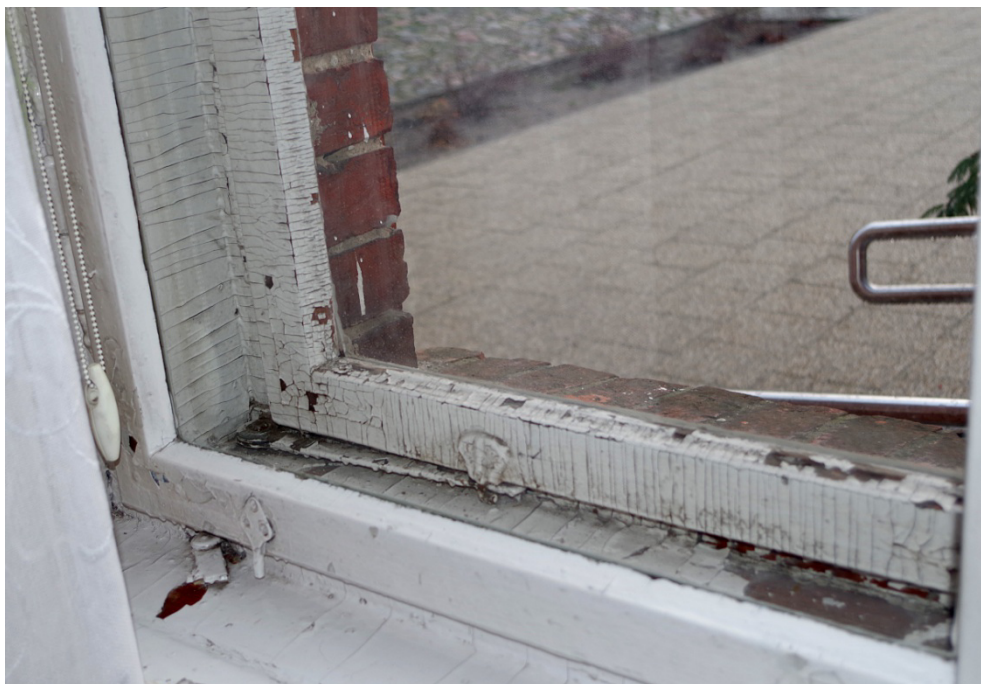
Fot. 2. Okno O1/1, widok od strony wewnętrznej. Widoczne silne spękania warstw malarskich, łuszczące się aż do warstwy drewna oraz ubytki przytrzymywaczy grzebieniowych.
