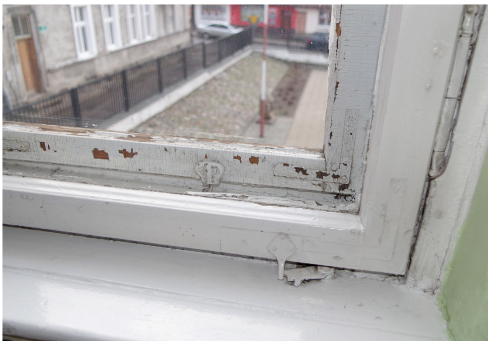
Fot.24. Okno O1/8, widok od strony wewnętrznej. Widoczne uszkodzone przytrzymywacze grzebieniowe oraz łuszczące i odpajające się warstwy malarskie.
