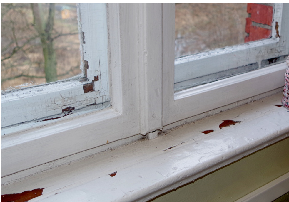
Fot.45. Okno O1/15, widok od strony wewnętrznej. Zbliżenie pokazuje ubytki mechaniczne ramiaka poziomego skrzydeł wewnętrznych, oraz poprawnie domknięty baskwil w uchu.
