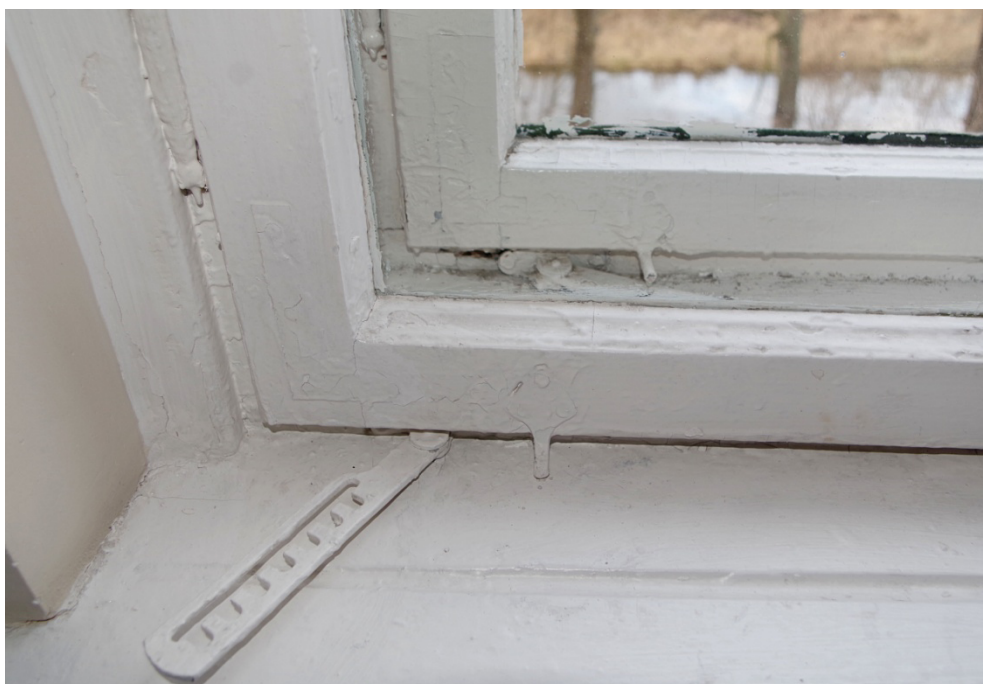
Fot.71. Okno O1/25, widok od strony wewnętrznej. Zbliżenie pokazuje zachowany przytrzymywacz grzebieniowy w skrzydle wewnętrznym.
