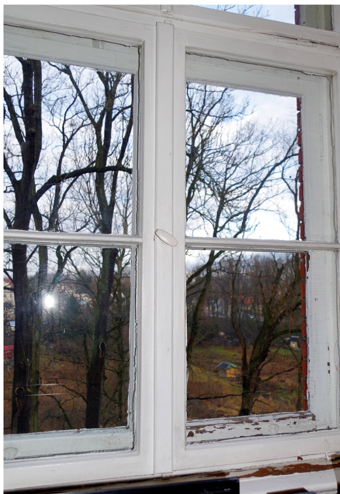
Fot.40. Okno O1/14, widok od strony wewnętrznej. Zbliżenie pokazuje wtórną listwę przemykową w skrzydłach podślemienia.
