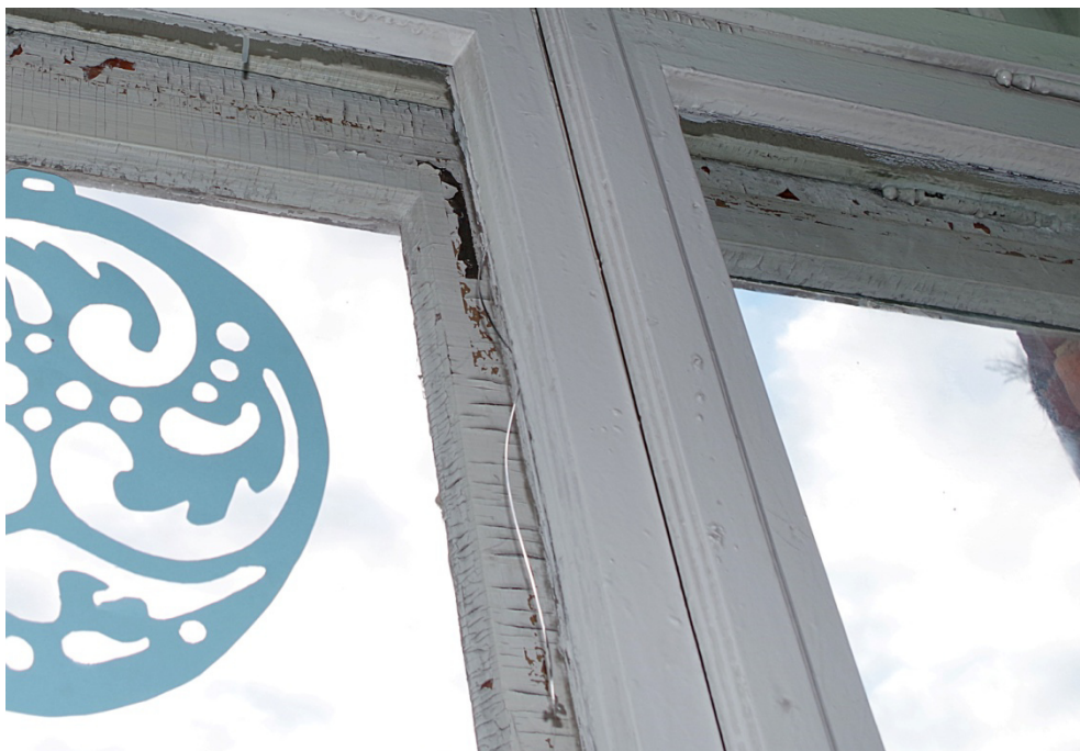
Fot. 14. Okno O1/5, widok od strony wewnętrznej. Widoczna pęknięta szyba w wyniku powstałych naprężeń drewna.
