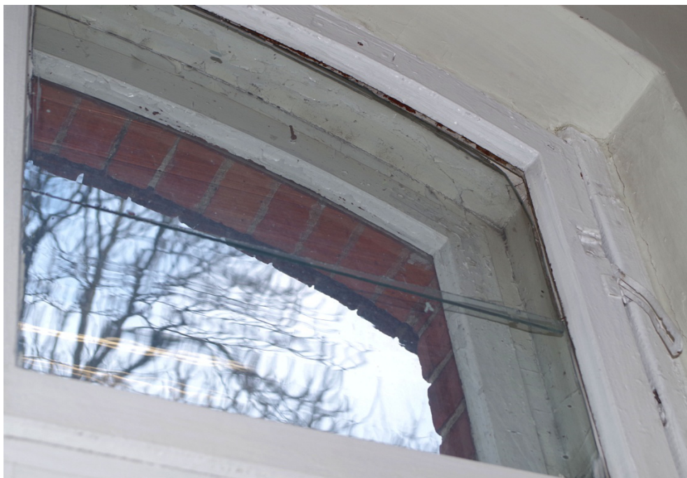
Fot.47. Okno O1/16, widok od strony wewnętrznej. Zbliżenie pokazuje, luźno osadzoną nową szybę składającą się z dwóch części. Szyby nie zakitowano, trzymają ją na sztywno gwoździe co spowodowało, że pękła w narożniku.
