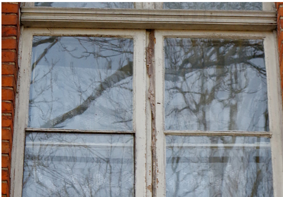
Fot.66. Okno O1/23, widok od strony zewnętrznej. Zbliżenie pokazuje brak listwy przymykowej oraz brak kitów szklarskich. Woda opadowa osiada na szprosach oraz dostaje się do wnętrza skrzynki.
