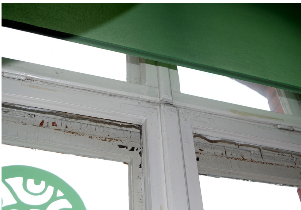
Fot. 18. Okno O1/6, widok od strony wewnętrznej. Widoczne wtórne skrzydło nadślepienia i zawiasy czopowe.
