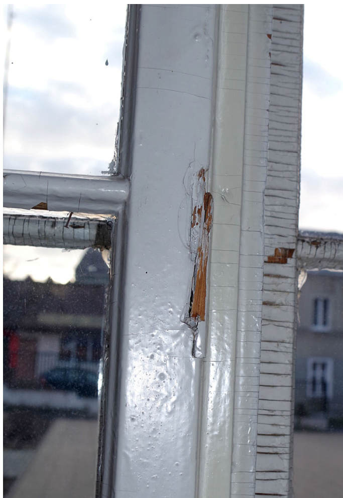
Fot. 9. Okno O1/3, widok od strony wewnętrznej. Widoczne ubytki mechaniczne przy systemie zamykania.
