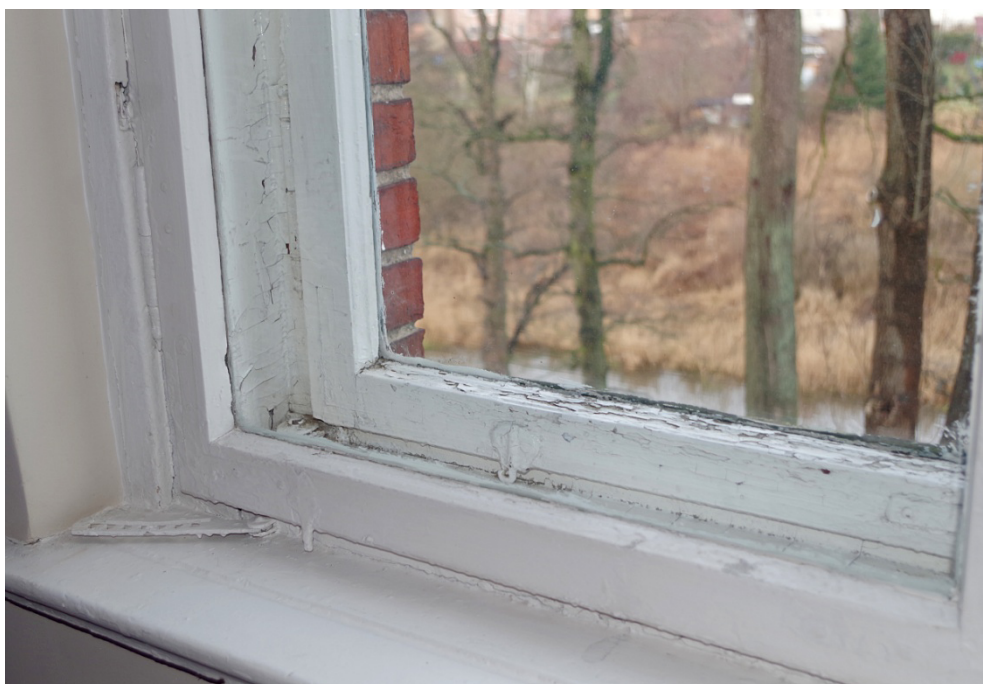
Fot.74. Okno O1/26, widok od strony wewnętrznej. Zbliżenie pokazuje zachowany przytrzymywacz grzebieniowy oraz zawilgocone i łuszczące się warstwy malarskie ramiaka skrzydła zewnętrznego.
