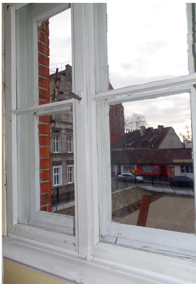
Fot.77. Okna typu O2 w elewacji frontowej, widok od strony wewnętrznej. Zbliżenie na skrzydła pokazuje brak profilowań krawędzi ramiaków, uproszczone listwy oraz klamkę ze znalu.
