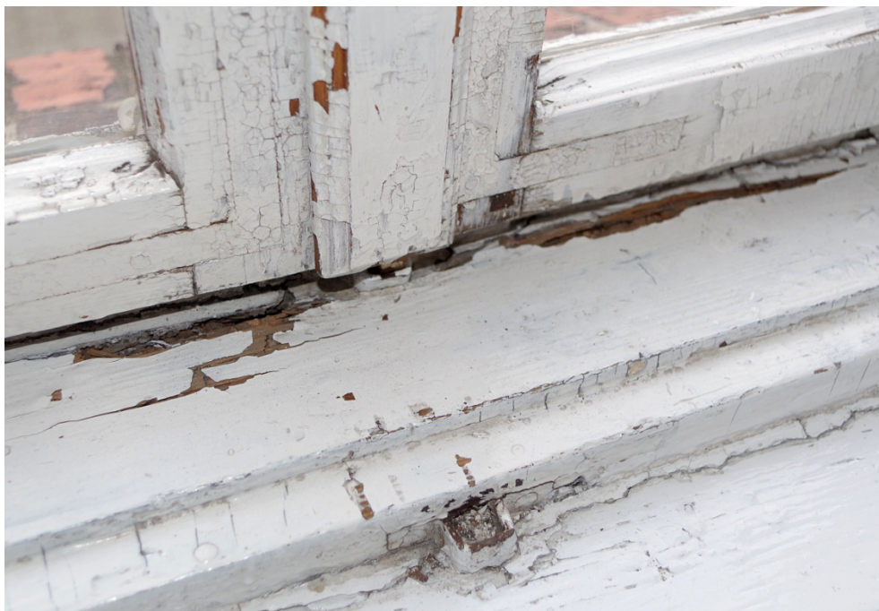
Fot.22. Okno O1/8, widok od strony wewnętrznej. Widoczna destrukcja drewna ościeżnicy, drewno jest miękkie i zdeintegrowane, nie zachowuje właściwości fizycznych.
