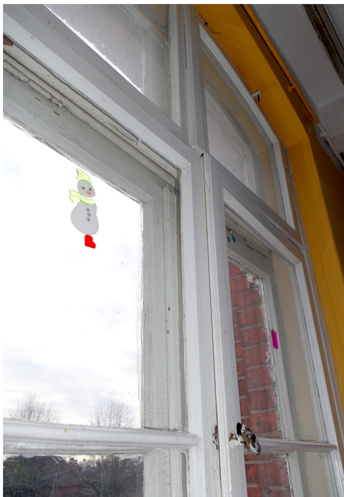
Fot.36. Okno O1/12, widok od strony wewnętrznej. Zbliżenie pokazuje mocno wypaczone skrzydła wewnętrzne podślemienia oraz wtórne klamki w skrzydle nadślemienia.
