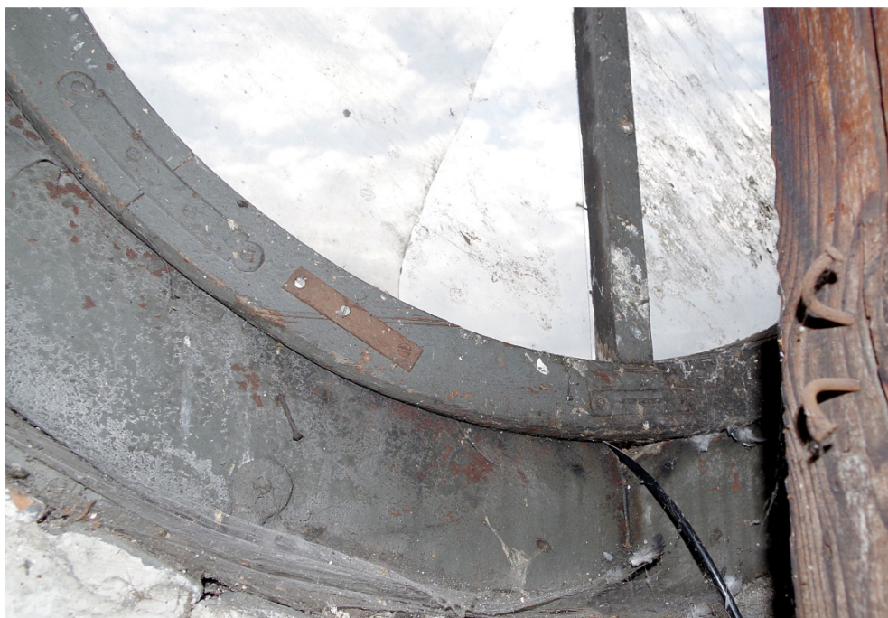
Fot.79. Okno O3, widok od strony wewnętrznej. Zbliżenie pokazuje pierwotne ozdobne blaszki wzmacniające połączenia ramiaka oraz kotwę mocującą ościeżnicę do muru.
