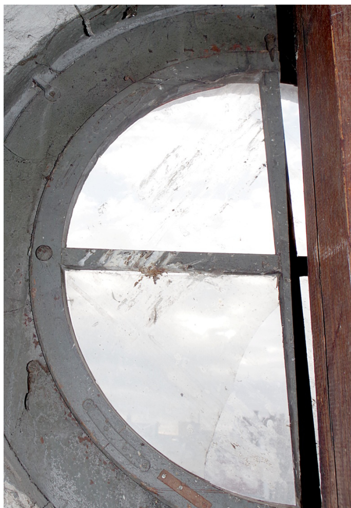
Fot.80. Okno O3, widok od strony wewnętrznej. Zbliżenie pokazuje zachowaną gałkę służącą do wyjmowania okna oraz dwie zakrętki zamykające skrzydło.
