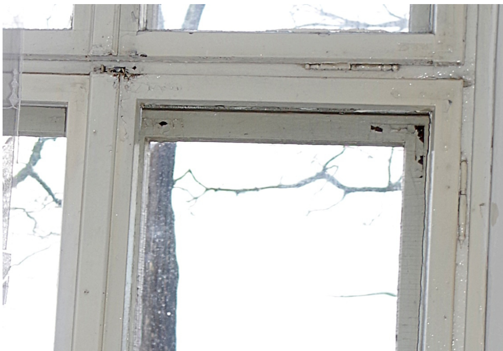
Fot.64. Okno O1/22, widok od strony wewnętrznej. Zbliżenie pokazuje wypaczenie skrzydeł i niedopasowanie skrzydła wtórnego - prawego. Baskwil nie trafia w ucho.
