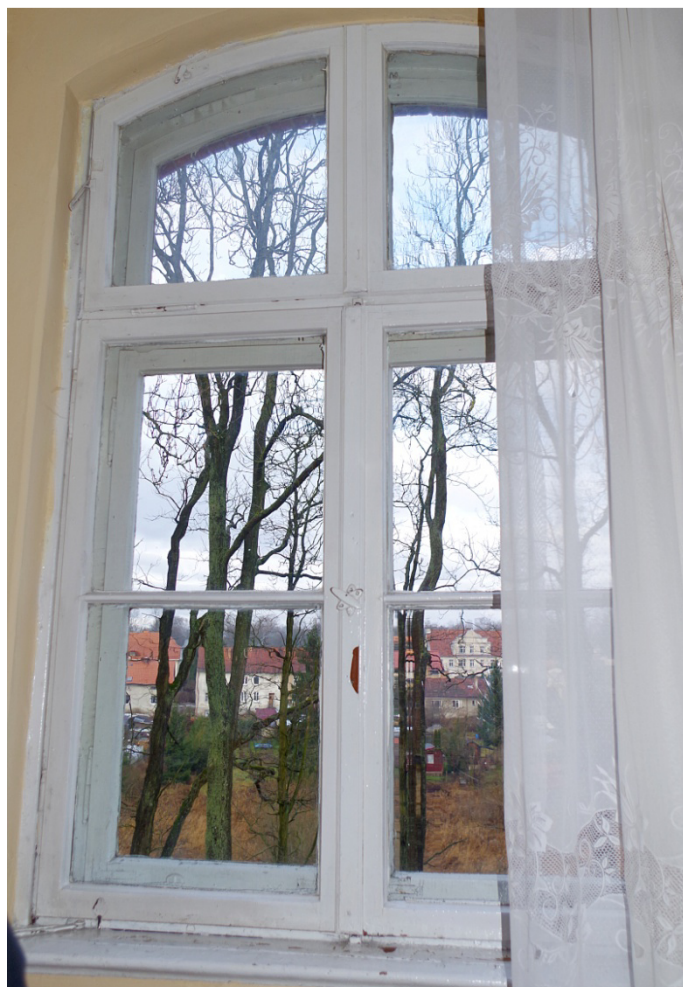
Fot.49. Okno O1/17, widok ogólny od strony wewnętrznej. Brak widocznych uszkodzeń stolarki.
