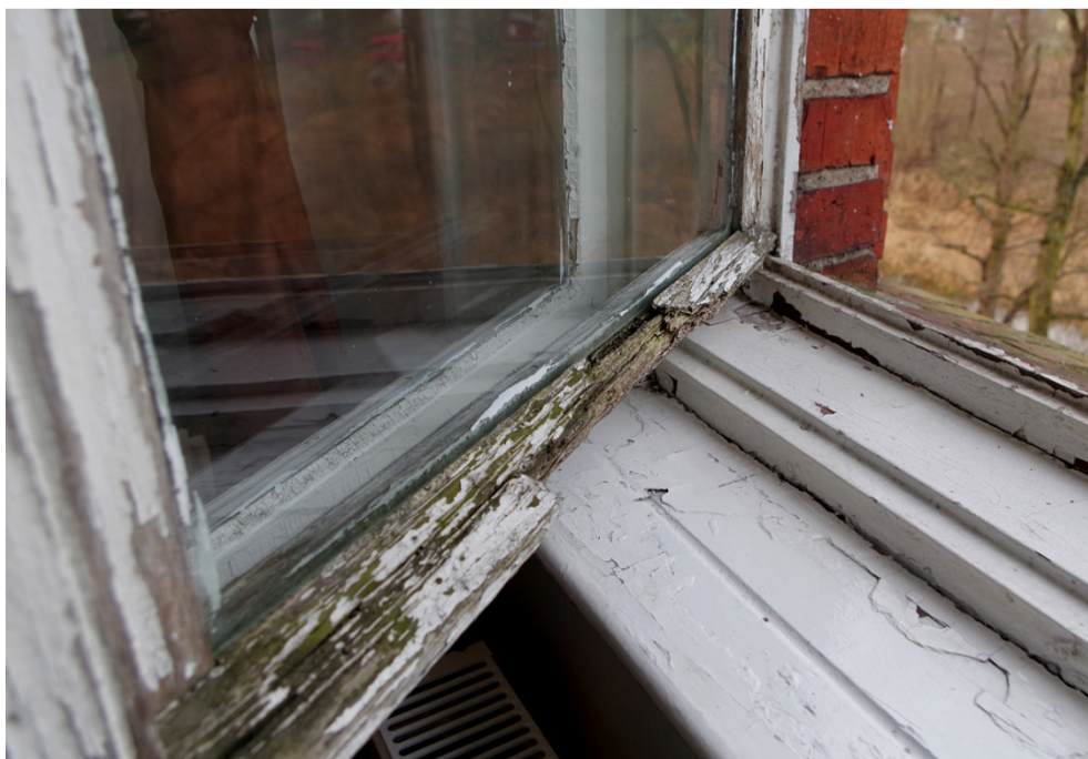
Fot.51. Okno O1/18, widok od strony zewnętrznej. Zbliżenie pokazuje zły stan zachowania drewna oraz rozległe ubytki okapnika.
