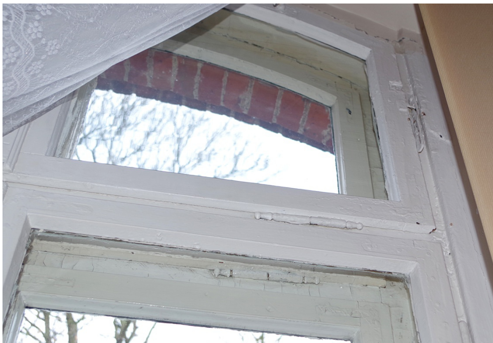
Fot.73. Okno O1/26, widok od strony wewnętrznej. Zbliżenie pokazuje wtórne przytrzymywacze grzebieniowe w skrzydle nadślemienia, oraz uproszczona forma ramiaka skrzydła podślemienia.
