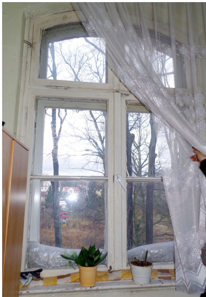
Fot.65. Okno O1/23, widok ogólny od strony wewnętrznej. Widoczne wtórne skrzydła podślemienia oraz wtórna listwa przymykowa z klamką.
