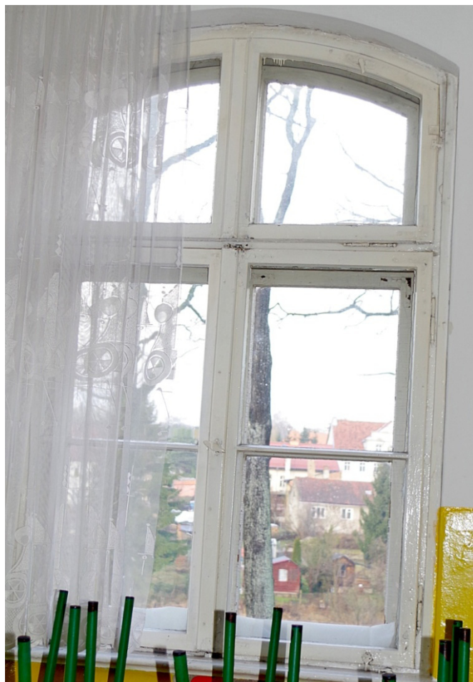
Fot.62. Okno O1/22, widok ogólny od strony wewnętrznej. Widoczne wtórne skrzydło prawe podślemienia oraz wtórna listwa przymykowa z klamką.
