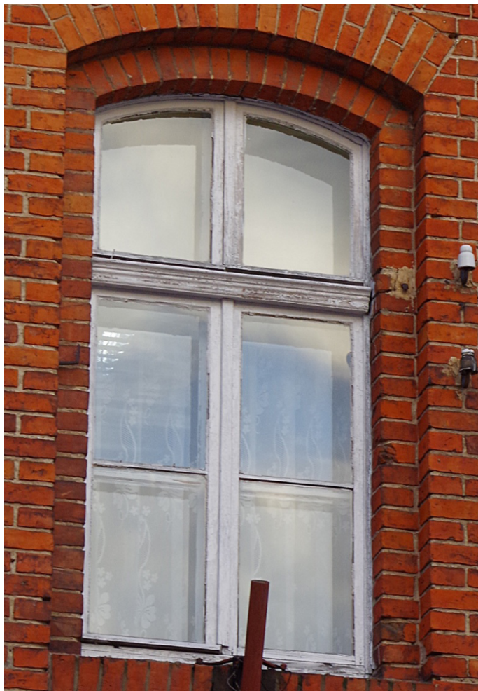
Fot.76. Okno typu O2 w elewacji frontowej, widok od strony zewnętrznej. Widoczne pierwotne ślepię oraz wtórne skrzydła z uproszczonymi listwami przymykowymi.
