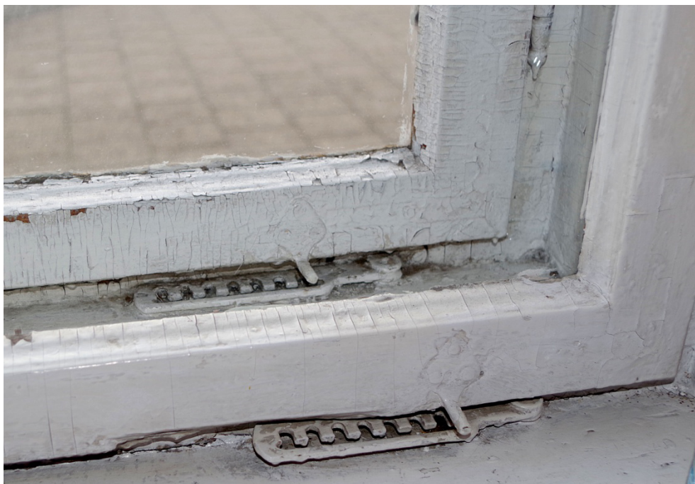
Fot. 11. Okno O1/4, widok od strony wewnętrznej. Widoczne zachowane przytrzymywacze grzebieniowe. Elementy mocowane do skrzydła pozbawione części haczyka co sprawia, że mechanizm nie działa. Widoczny ubytek mechaniczny ramiaka.
