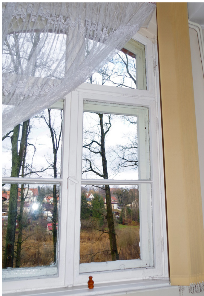
Fot.72. Okno O1/26, widok ogólny na okno od strony wewnętrznej. Widoczne wtórne skrzydła podślemienia.
