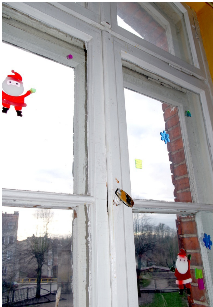
Fot.31. Okno O1/11, widok od strony zewnętrznej. Zbliżenie pokazuje, ubytki mechaniczne ramiaka w okolicy zamka, oraz wychodzący sylikon, na który ustalono szyby w skrzydłach podślemienia.
