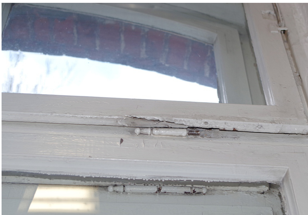
Fot.55. Okno O1/19, widok od strony zewnętrznej. Zbliżenie pokazuje ubytek konstrukcyjny ramiaka poziomego skrzydła nadświetlenia oraz wtórne mocowanie przytrzymywacza grzebieniowego.
