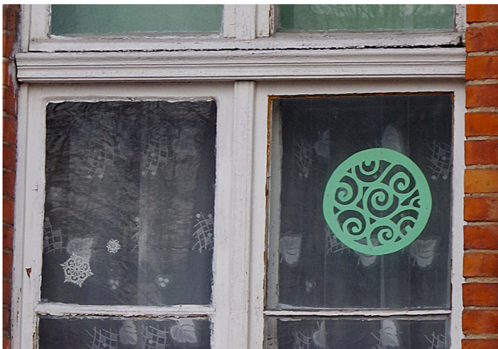
Fot. 17. Okno O1/6, widok od strony zewnętrznej. Zdjęcie pokazuje ubytki kitów szklarskich, co powoduje szybką degradację drewna oraz zaciekanie wody opadowej do wnętrza skrzynki.
