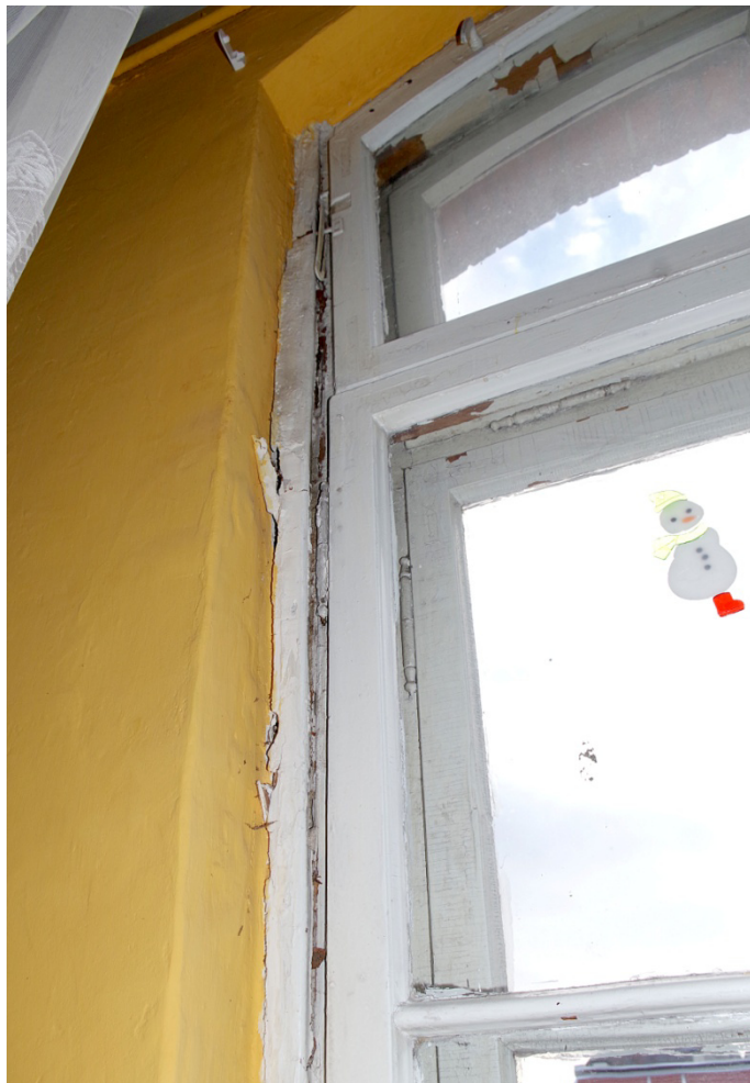
Fot.35. Okno O1/12, widok od strony wewnętrznej. Zbliżenie pokazuje zawilgoconą i zbutwiałą ościeżnicę.
