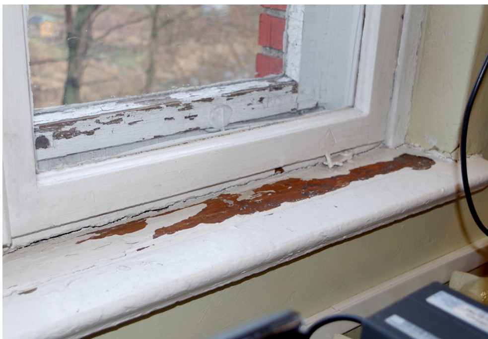
Fot.42. Okno O1/14, widok od strony wewnętrznej. Zbliżenie pokazuje ułamany przytrzymywacz grzebieniowy oraz łuszczące się i odpajające warstwy malarskie.
