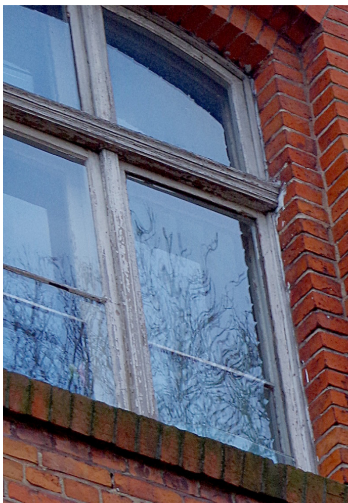
Fot.48. Okno O1/16, widok od strony zewnętrznej. Zbliżenie pokazuje, brak szprosu w skrzydle podślemienia oraz dużą tafelę szkła, która pękła w wyniku naprężeń drewna.
