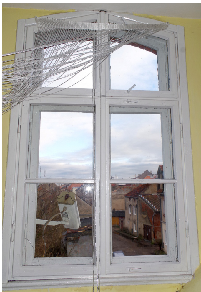
Fot.82. Okno typu O5/1, widok ogólny od strony wewnętrznej. Widoczne wtórne skrzydła wewnętrzne niedopasowane do łuku zwieńczenia glifu.
