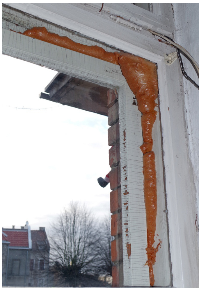
Fot. 3. Okno O1/1, widok od strony wewnętrznej. Widoczne uszczelnienie i zamocowanie wypadającego skrzydła przy pomocy pianki.
