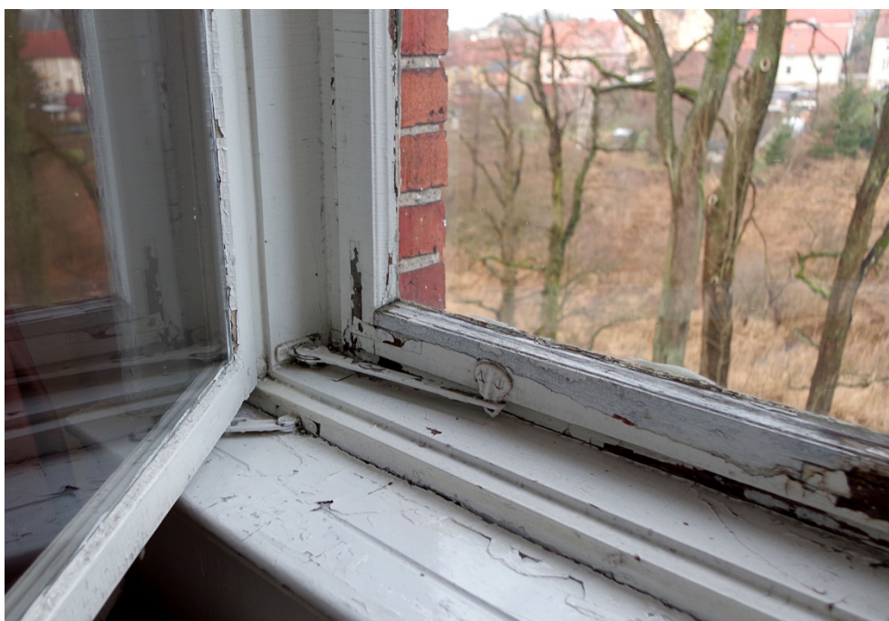
Fot.52. Okno O1/18, widok od strony zewnętrznej. Zbliżenie pokazuje zawilgocone i zbutwiałe drewno dolnego ramiaka i ościeżnicy. Wtórny przytrzymywacz grzebieniowy.
