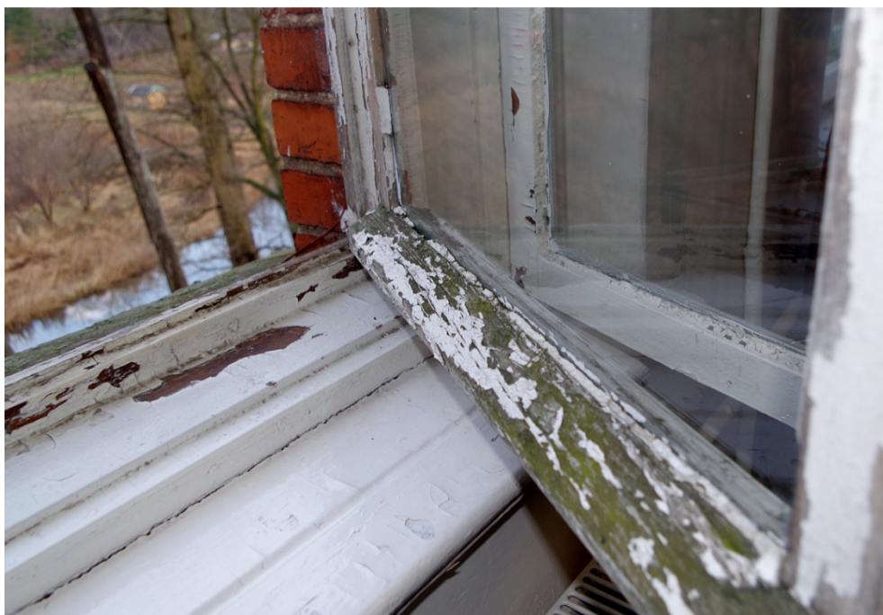
Fot.54. Okno O1/19, widok od strony zewnętrznej. Zbliżenie pokazuje zły stan zachowania okapnika, drewno jest zbutwiałe i zmurszałe, pokryte mikroorganizmami.
