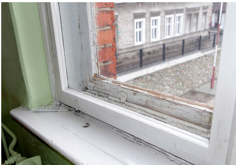
Fot.21. Okno O1/7, widok od strony wewnętrznej. Widoczny brak przytrzymywacza grzebieniowego w skrzydle zewnętrznym oraz łuszczenie się warstw malarskich.
