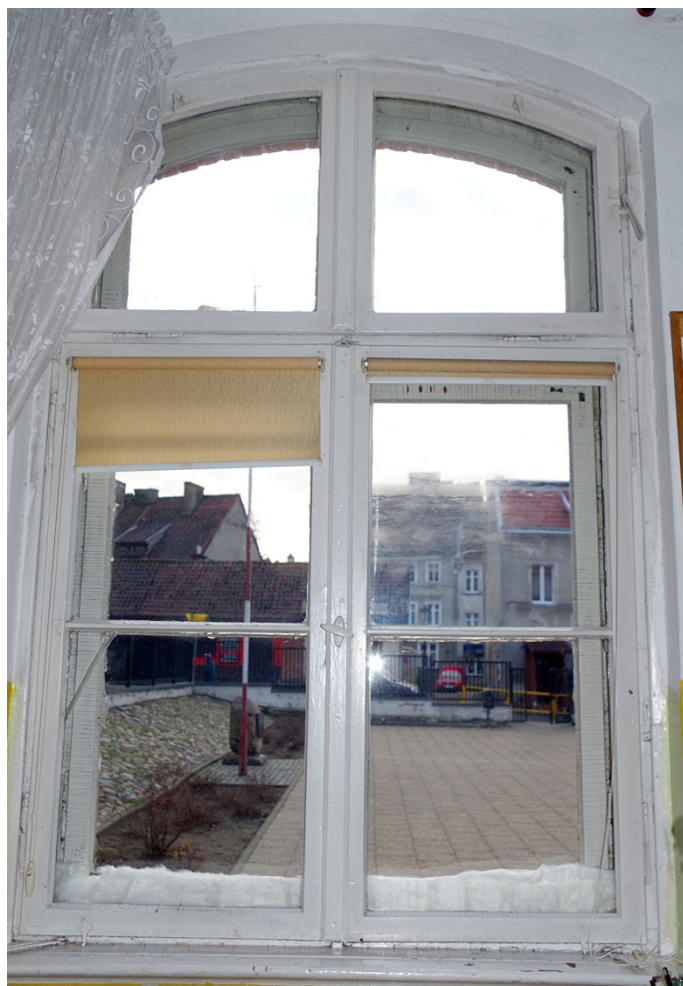
Fot. 7. Okno O1/3, widok ogólny od strony wewnętrznej. Widoczne uszczelnienie okna watą, wtórne klamki wykonane ze znalu oraz pęknięta szyba skrzydła lewego podślemienia. Pęknięcie powstało w wyniku naprężeń.
