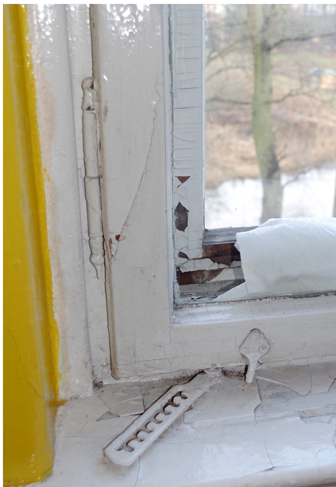
Fot.60. Okno O1/21, widok od strony wewnętrznej. Zbliżenie pokazuje pęknięcie konstrukcyjne ramiaka, spowodowane naprężeniami i wypaczeniem drewna.
