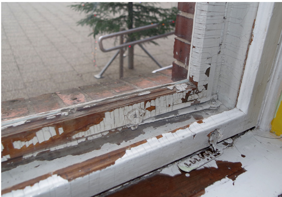
Fot. 6. Okno O1/2, widok od strony wewnętrznej. Widoczne spękania warstw malarskich i rozległe odspojenia. Widoczne różne przytrzymywacze grzebieniowe.
