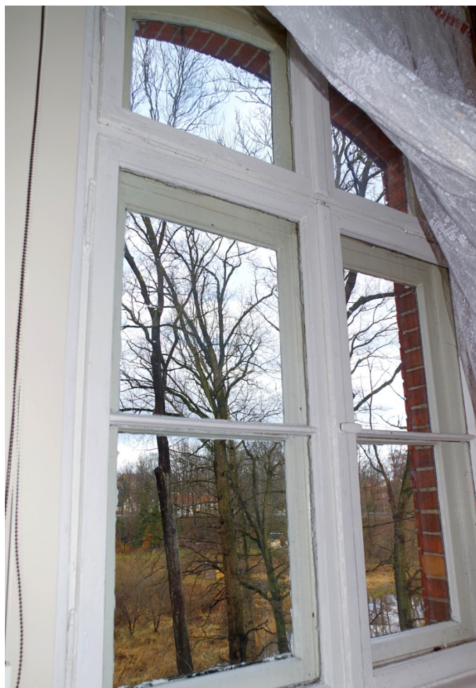
Fot.69. Okno O1/25, widok ogólny na dobrze zachowaną stolarkę okienną od strony wewnętrznej.
