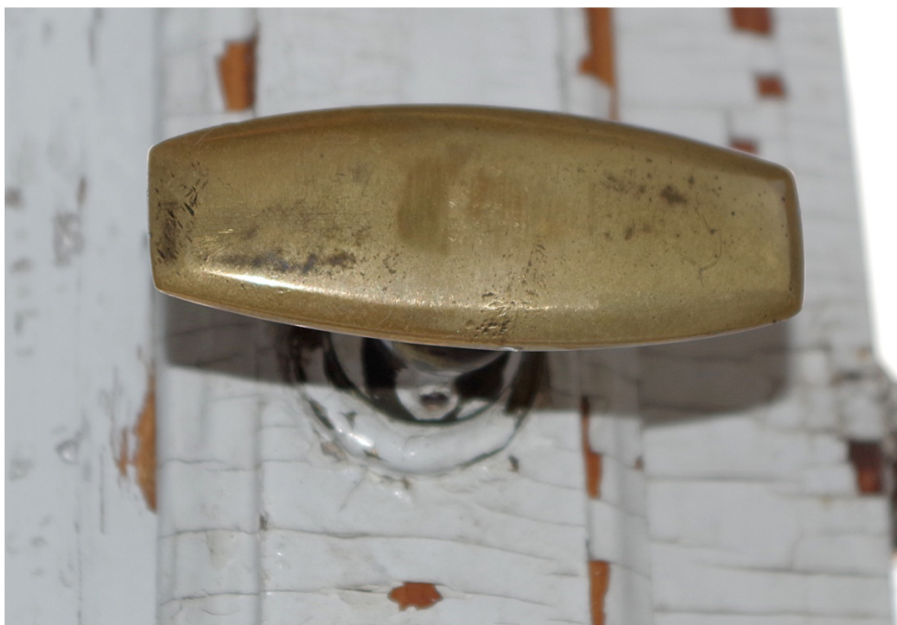
Fot. 20. Okno O1/7, widok od strony wewnętrznej. Widoczna zachowana i nieprzemalowana pierwotna klamka równoramienna.
