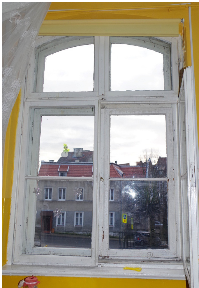
Fot.28. Okno O1/10, widok ogólny od strony wewnętrznej. Widoczne wtórne skrzydła wewnętrzne.
