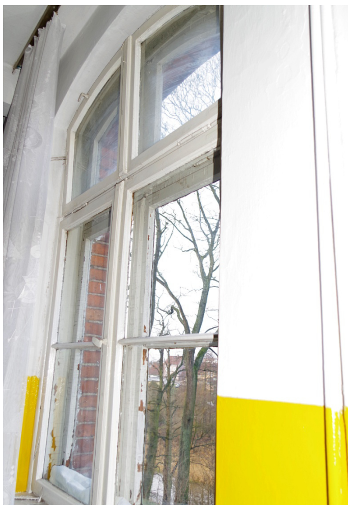
Fot.61. Okno O1/21, widok od strony wewnętrznej. Zbliżenie pokazuje odkształcenie od pionu skrzydła nadświetlenia. Skrzydło nie zamyka się.
