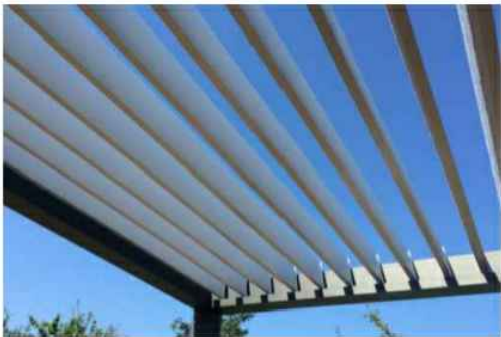
Fot. PRZYKŁADOWE ROZWIĄZANIE PRZESZKLONEGO ZADASZENIA TARASÓW Z ZASTOSOWANIEM ALUMINIOWYCH LAMELI RUCHOMYCH SYSTEMOWYCH STAŁYMI
