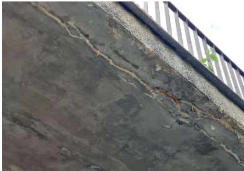
Fot.7,8. Zawilgocenia i uszkodzenia tynków stropowych.
