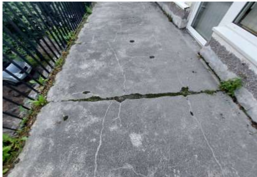
Fot.12,13. Widok nawierzchni płyty balkonowej.
