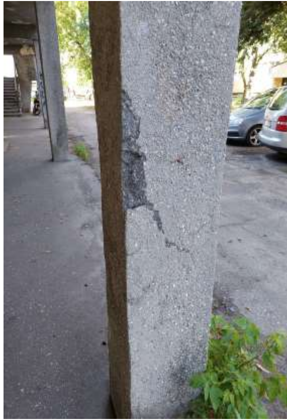
Fot.11. Uszkodzenie trzonu słupa żelbetowego.
