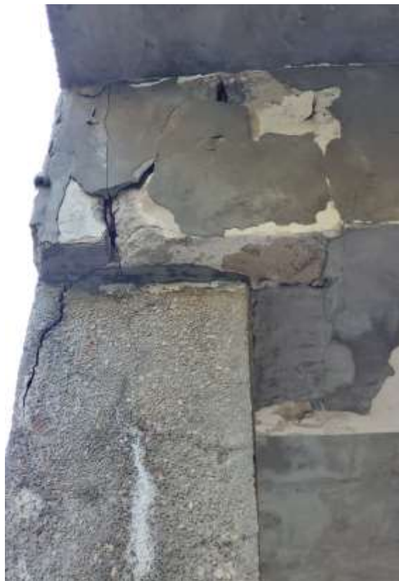
Fot.9,10. Uszkodzone podciągi żelbetowe.
