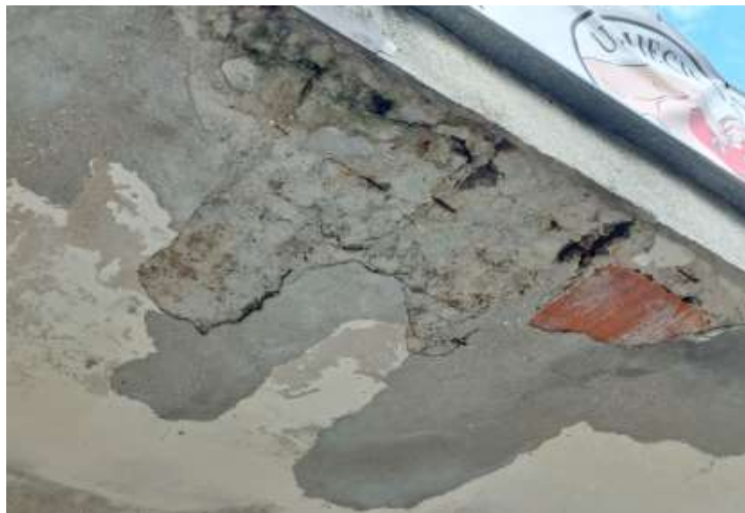
Fot.3,4. Pozbawione otuliny i skorodowane zbrojenie żeber.
