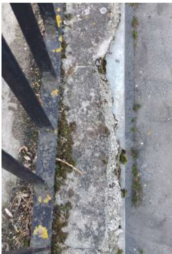
Fot.14,15. Uszkodzenia płyty betonowej w części czołowej.
