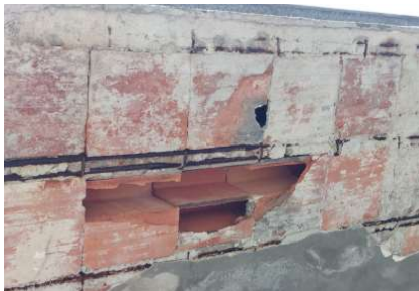
Fot.5,6. Uszkodzenia pustaków stropowych.
