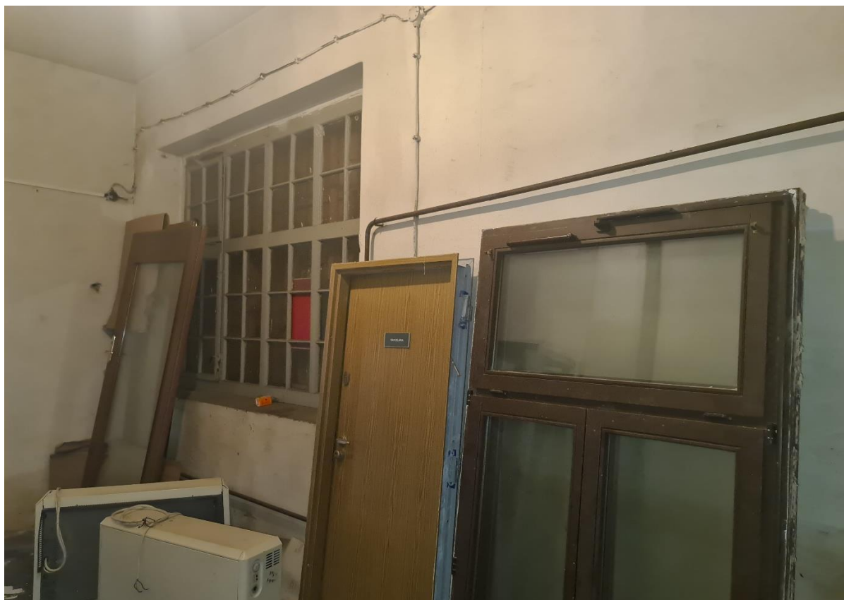
Zdjęcie 6 – ściana wspólna z budynkiem magazynowym (nie do rozbiórki)
