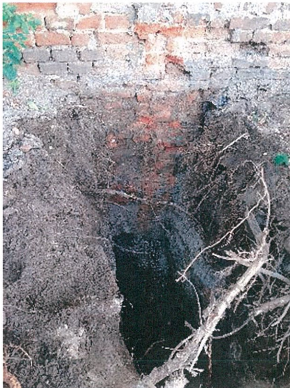
RYS.4. Fundament budynku w lokalizacja nr 2
