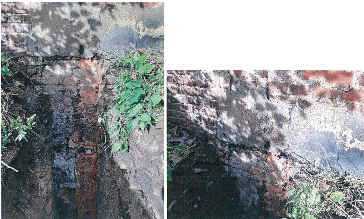
RYS.8. Fundament budynku w lokalizacja nr 4
