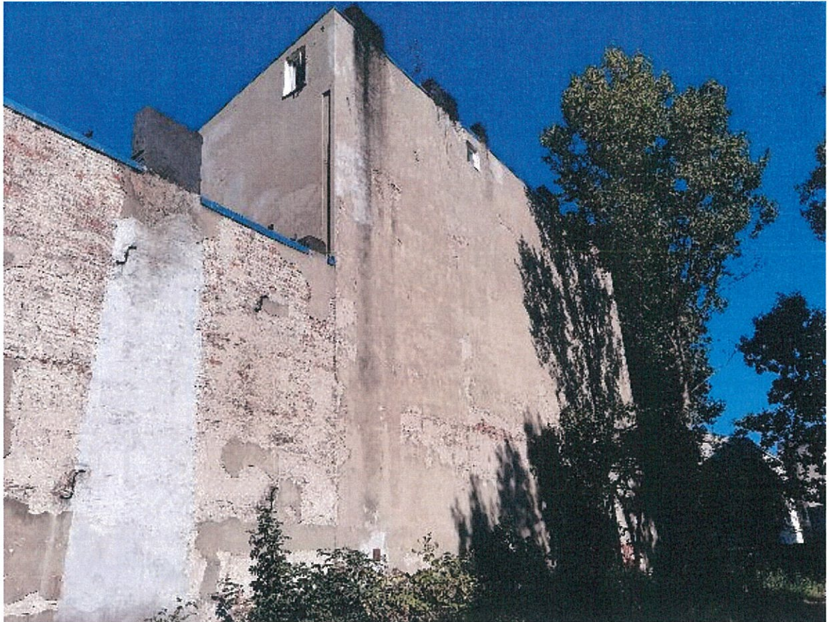
RYS.7. Budynki w granicy zachodniej
