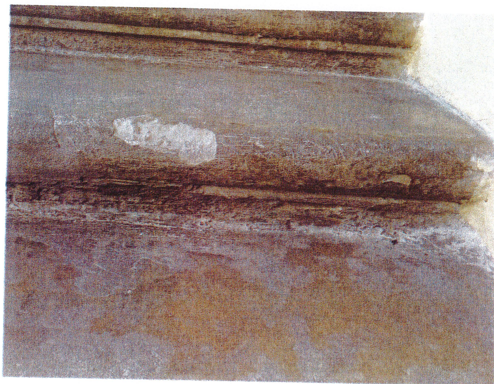
Fot. 5, 6. Klatka schodowa (XIX/XX w.) we wnętrzu Pałacu Kottłajów w Wiśniowej. Stan przed konserwacją, zbliżenia zniszczeń powierzchni kamiennej i lastrykowej. Fot. A. Bracha 2020 r.
