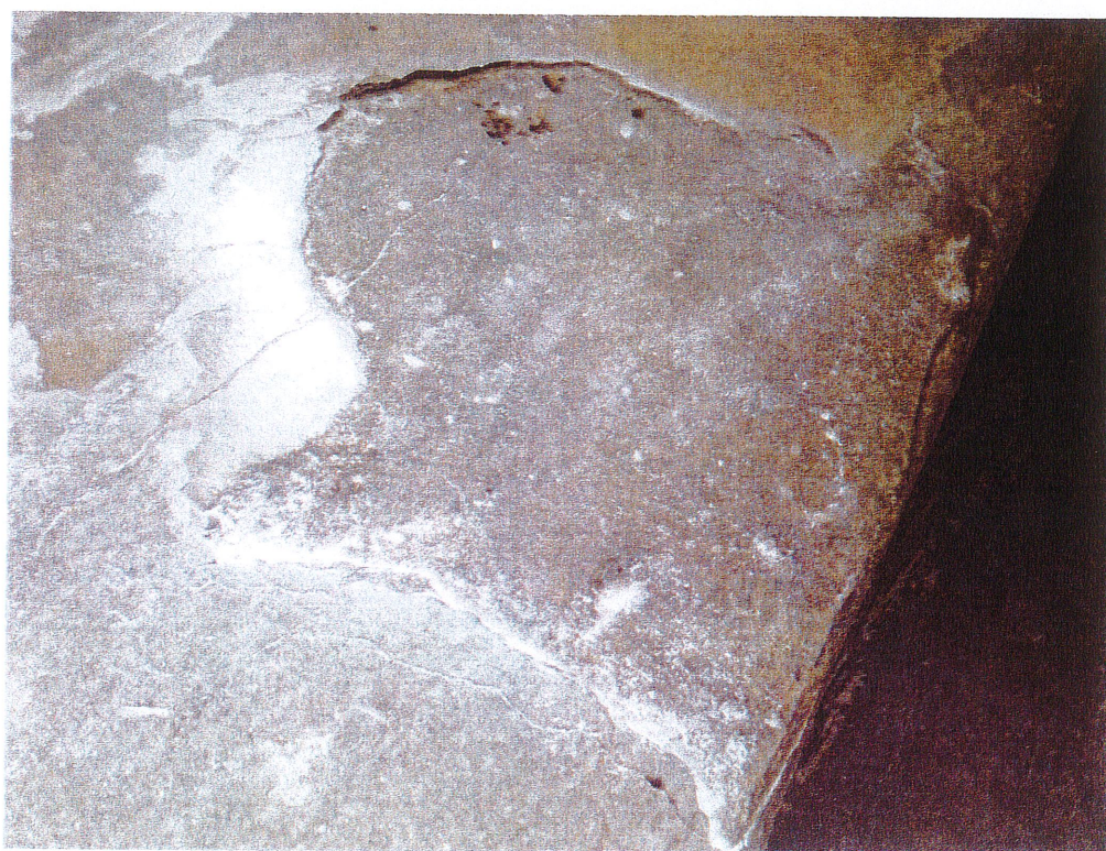
Fot. 7, 8. Klatka schodowa (XIX/XX w.) we wnętrzu Pałacu Kottłagów w Wiśniewie. Stan przed konserwacją, zbliżenia zniszczeń powierzchni kamiennych. Fot. A. Bracha 2020 r.
