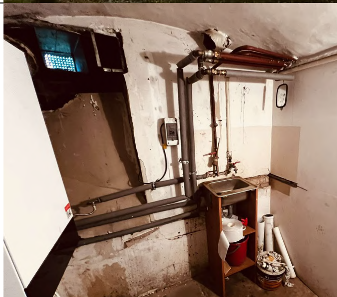
Kotłownia – widok na otwór okienny z wnętrza pomieszczenia
