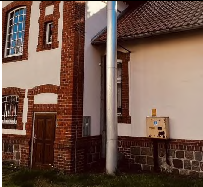
Elewacja północna – w części przyziemia częściowo zamurowany otwór okienny prowadzący do piwnicy (możliwość wykorzystania do zainstalowania wentylacji decentralnej)
