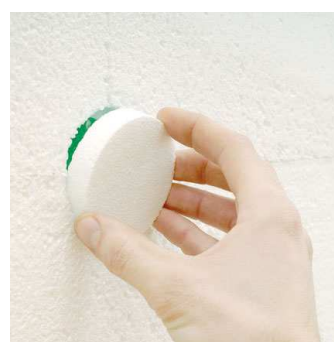
Zaślepki styropianowe do otworów po kołkach –likwidacja mostków
