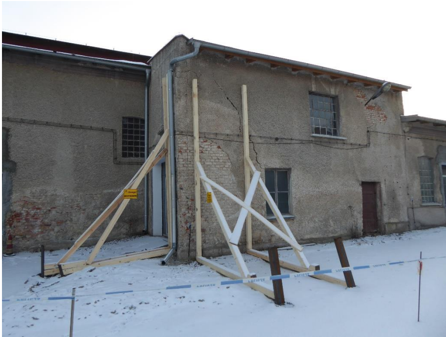
2. Budynek garażowy przeznaczony do rozbiórki
