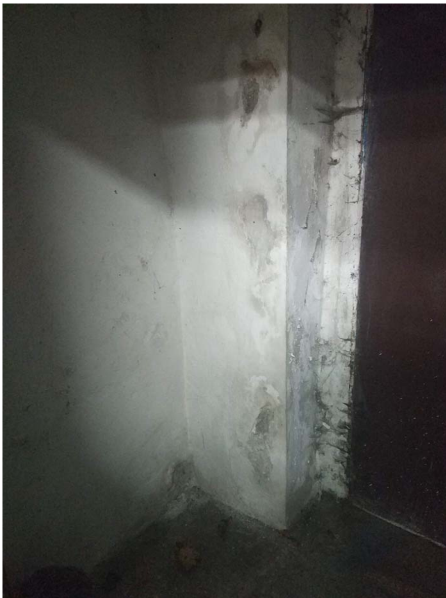
Fotografia nr 2: Silnie zawilgocono ściana przy wejściu do pomieszczeń piwnicznych-prawa strona. Na ścianie występują intensywne wysolenia, które powodują odspajanie tynków i destrukcję wypraw malarskich.
