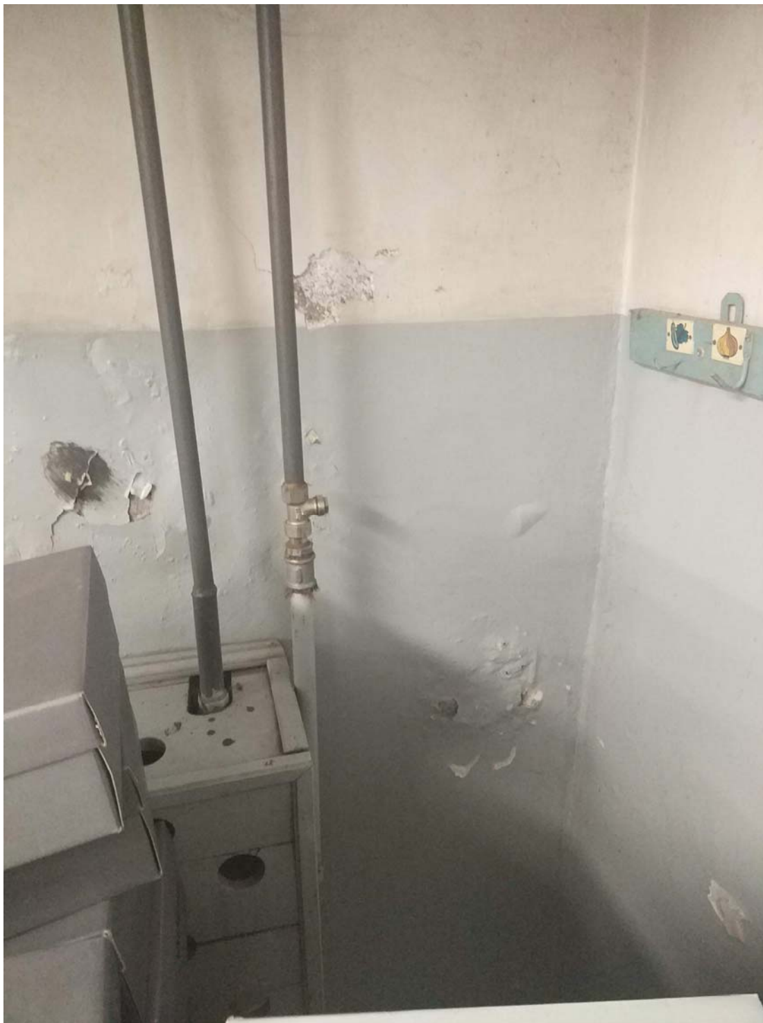
Fotografia nr 4: To samo pomieszczenie piwniczne po prawej stronie głównego wejścia. Silnie zawilgocone naroże ścian. Wysolenia powodują uszkodzenie tynków.
