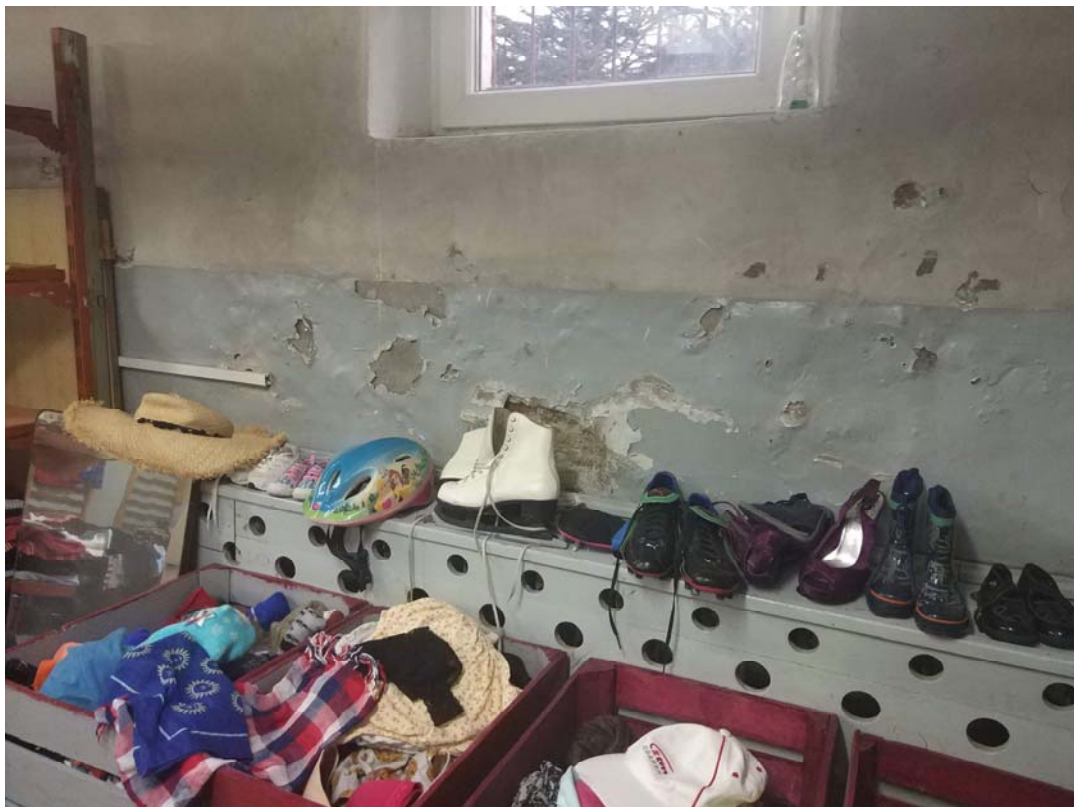
Fotografia nr 3: Pomieszczenie piwniczne po prawej stronie głównego wejścia. Silnie zawilgocona ściana, na której występują wysolenia niszczące tynki, ściana od strony głównego wejścia do budynku.
