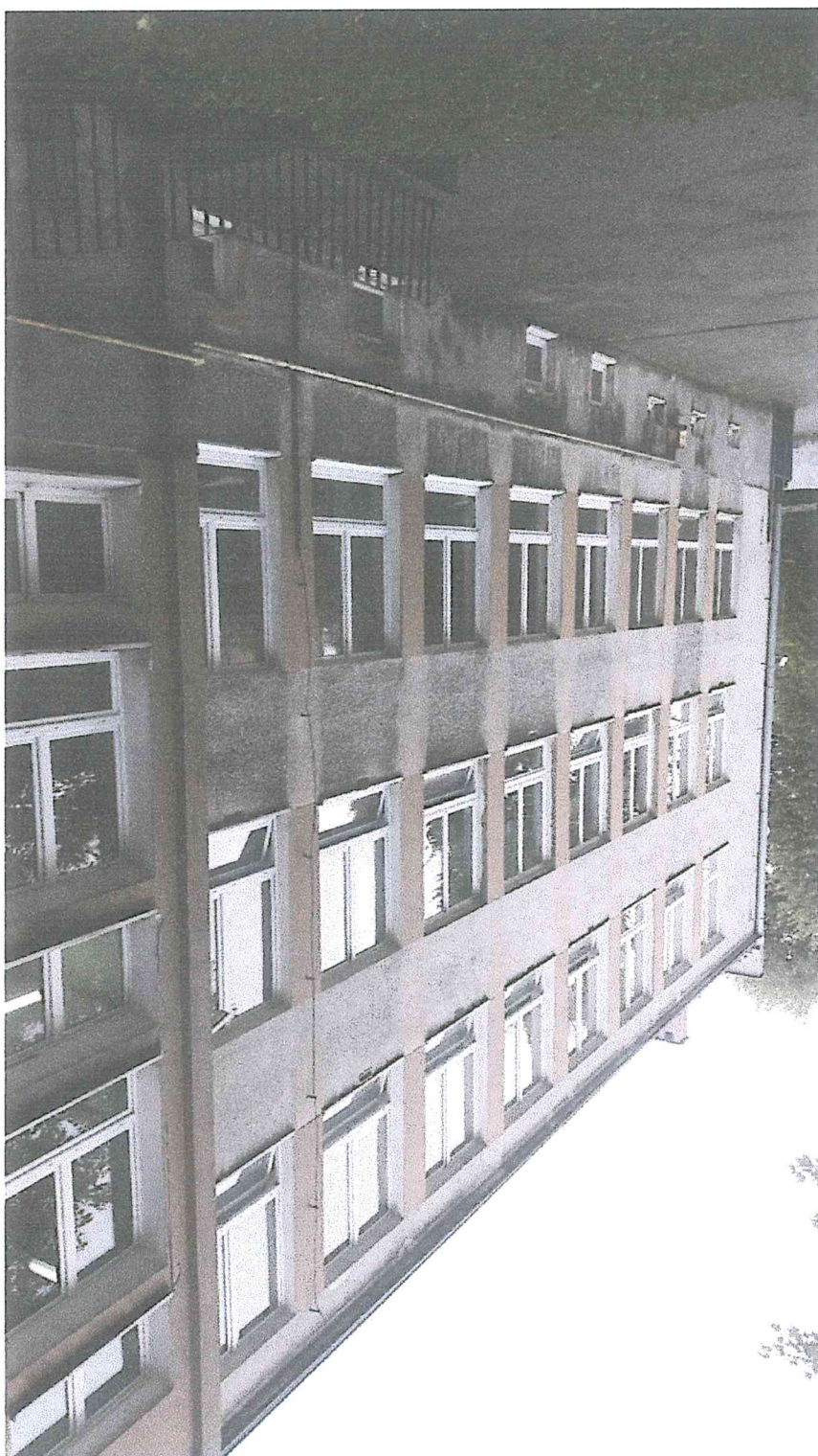
Fot. 8. Szkoła Podstawowa nr 21 w Gdańsku. Fragment ściany od strony północnej. Widoczne pod oknami przysłonięte otwory wentylacyjne.
