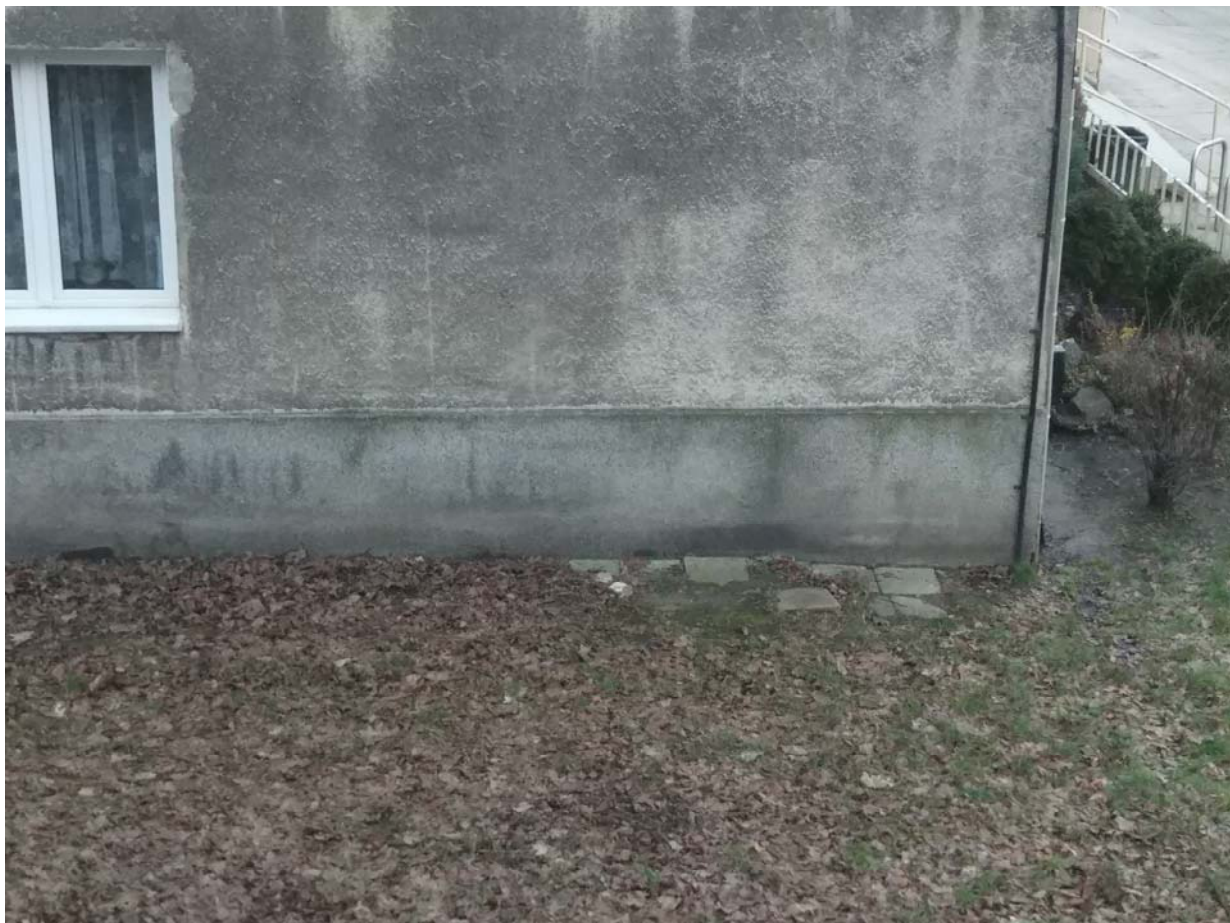
Fotografia nr 11: Niewłaściwe ukształtowanie terenu przy budynku oraz brak strefy cokołowej potęgują zjawiska mikologiczne wewnątrz obiektu.
