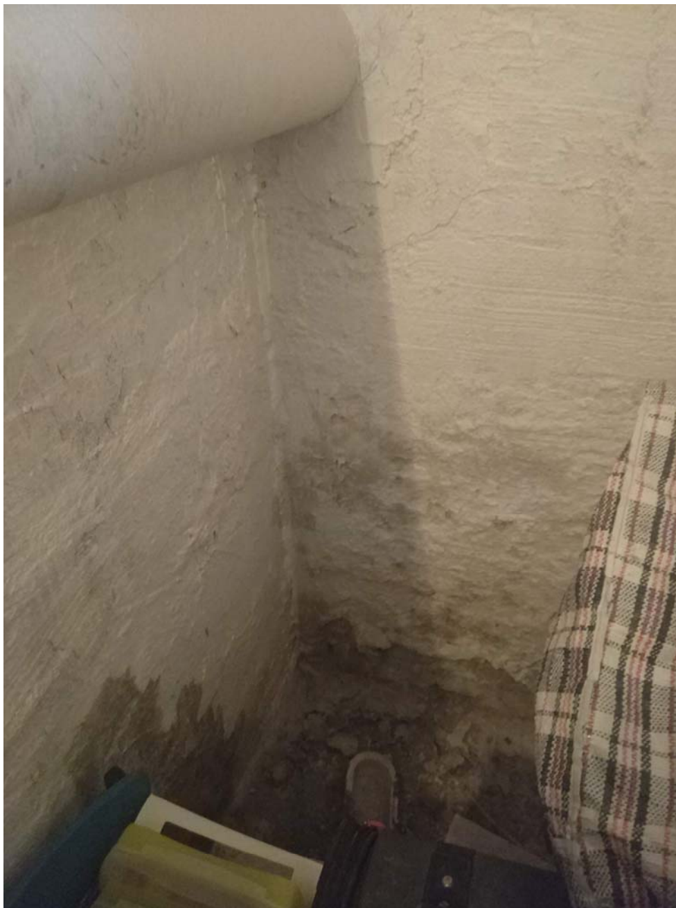
Fotografia nr 5: Pomieszczenie po stronie głównego wejścia do budynku, graniczące z węzłem CO. Ściany silnie zwilgocone oraz w ich sąsiedztwie posadzka.
