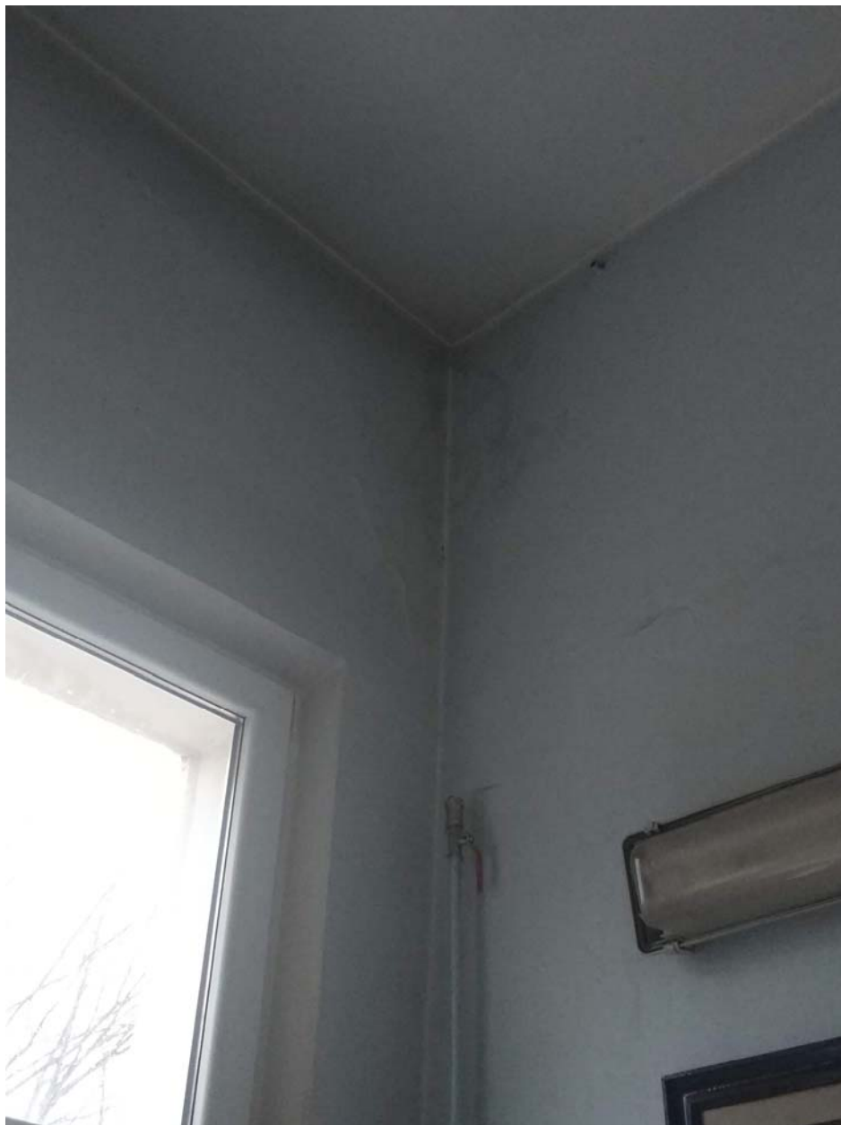
Fotografia nr 8: Ślady korozji biologicznej spowodowane kondensacją pary wodnej w miejscu występowania mostka termicznego.
