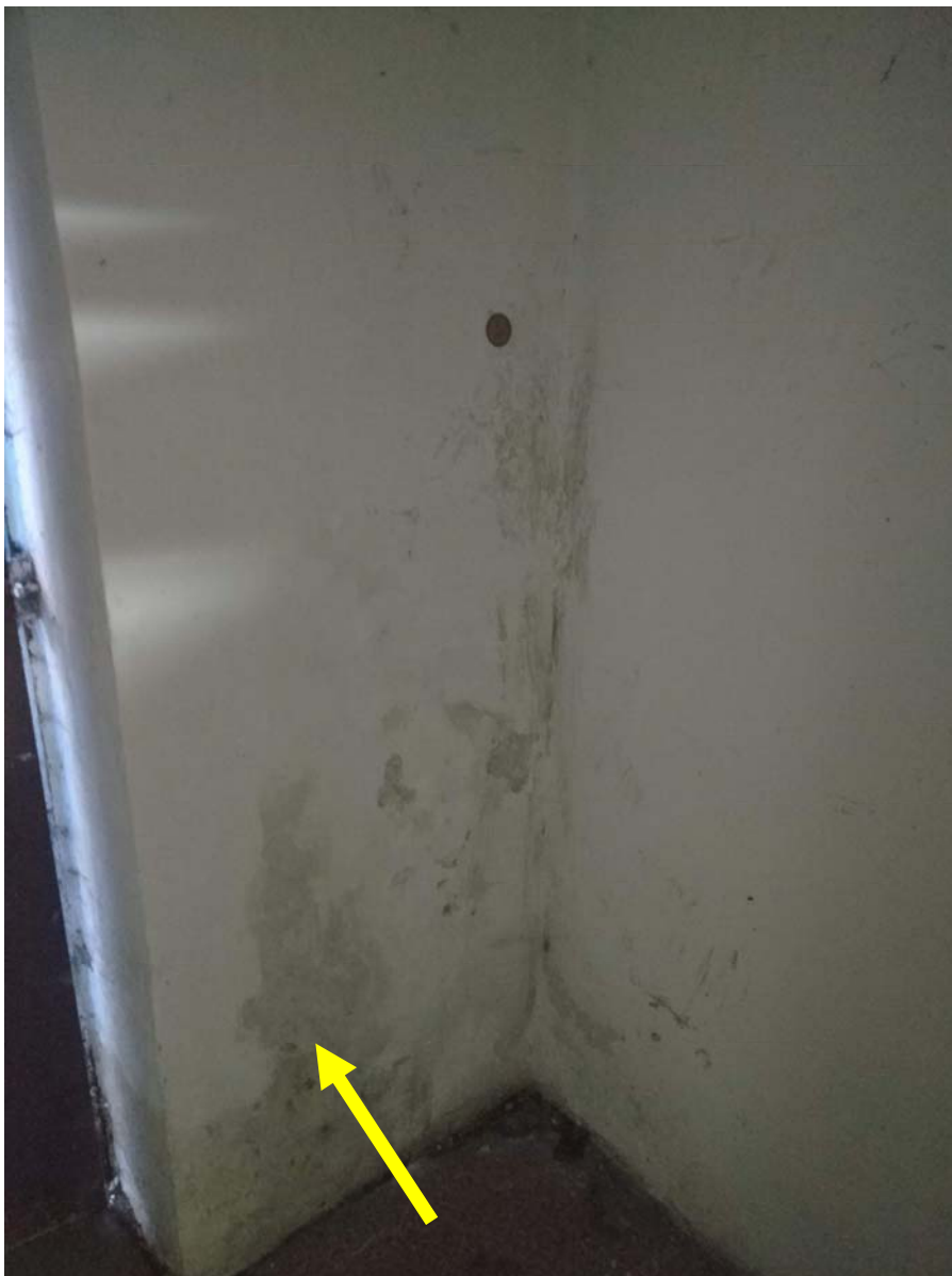
Fotografia nr 1: Silnie zawilgocono ściana przy wejściu do pomieszczeń piwnicznych-lewa strona. Strzałką zaznaczono miejsce pobrania próbki do badań mykologicznych-próbka nr 1/8/19 (zaznaczono na załączonym rzucie). Na ścianie występują w znacznym nasileniu wysolenia.
