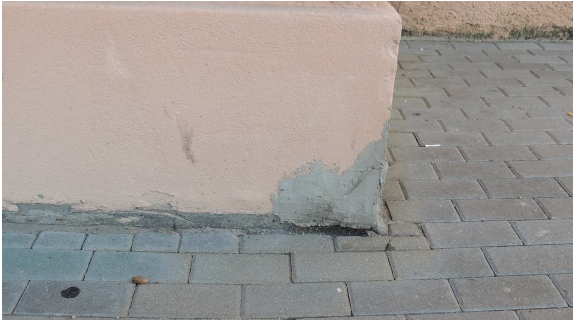
27. Wtórne uzupełnienia wykonane zaprawą klejową.
