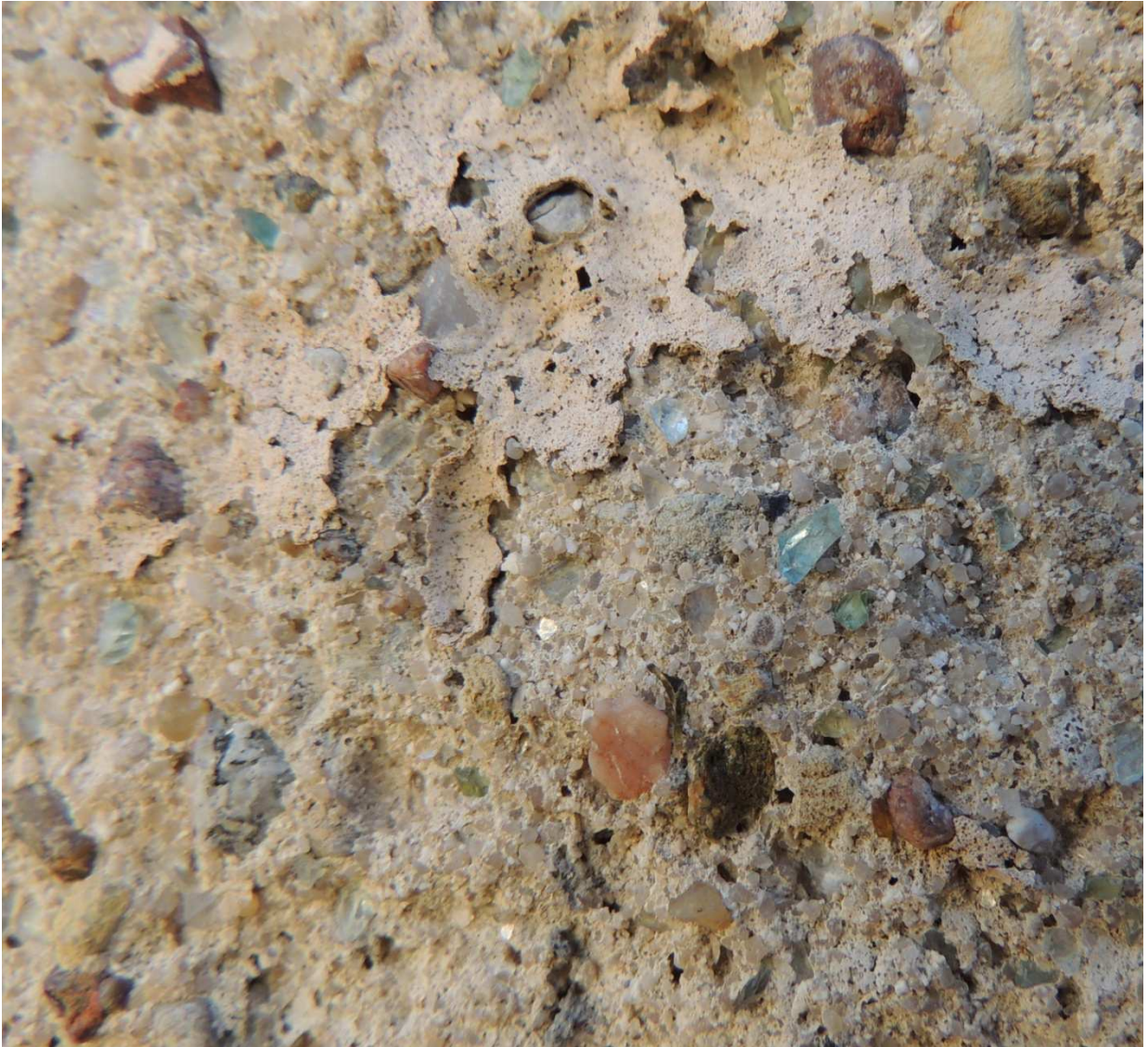
45. Drobiny błękitnego szkła w tynku.
