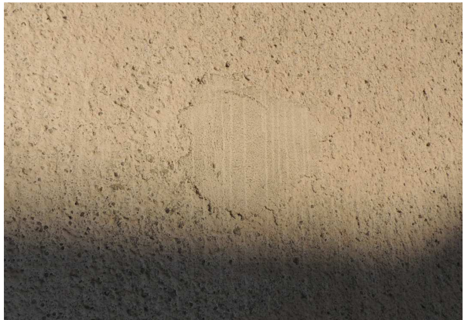
29. Wtórne uzupełnienie ubytku.
