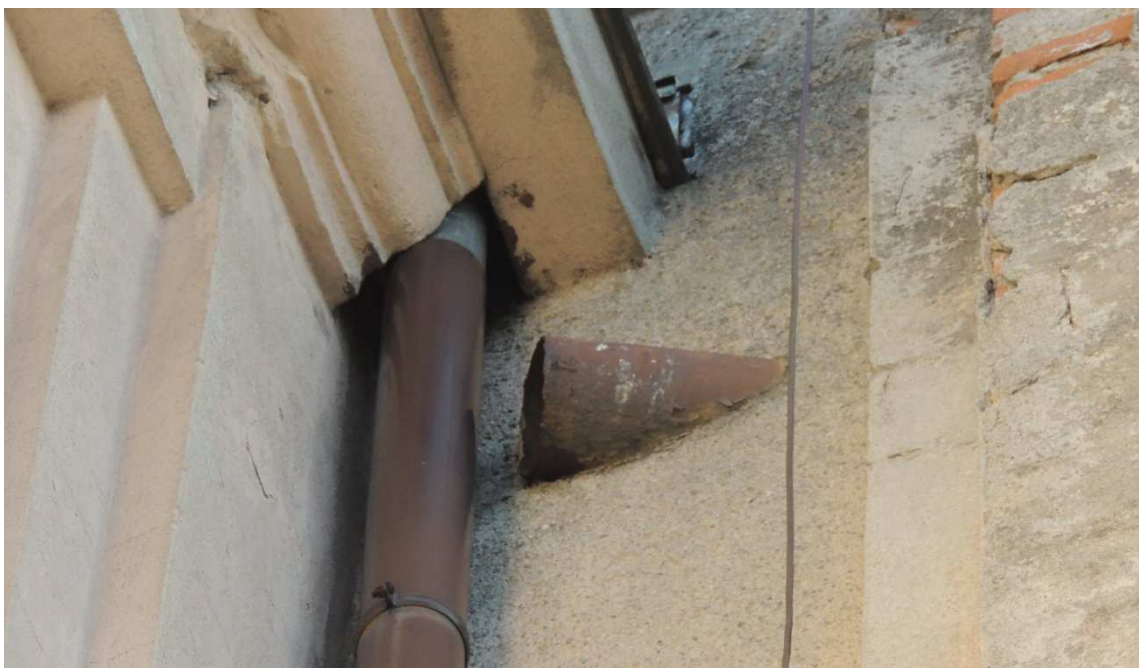
18. Żeliwna rura prawdopodobnie ze starego systemu odprowadzania wody.
