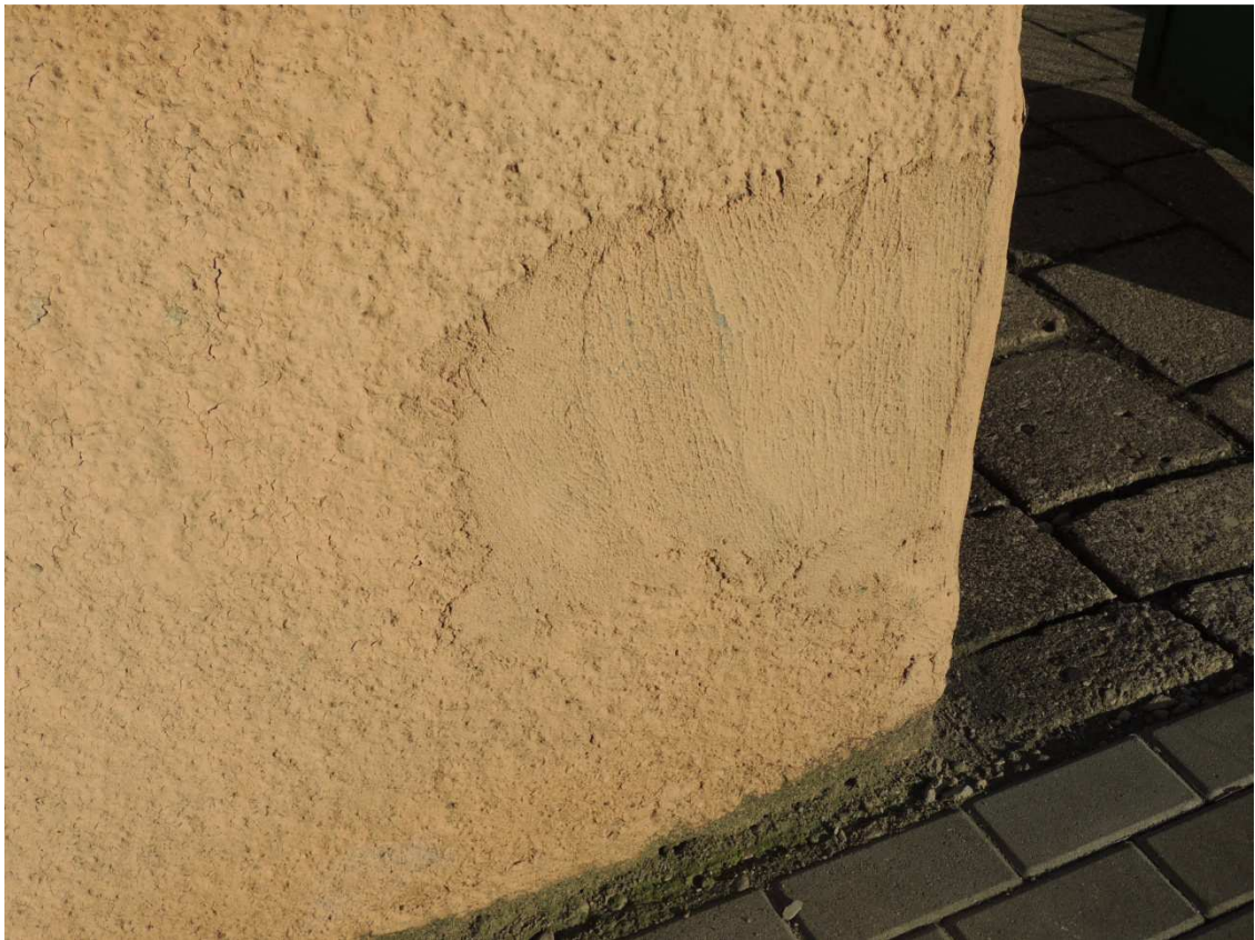
30. Wtórne uzupełnienie ubytku.
