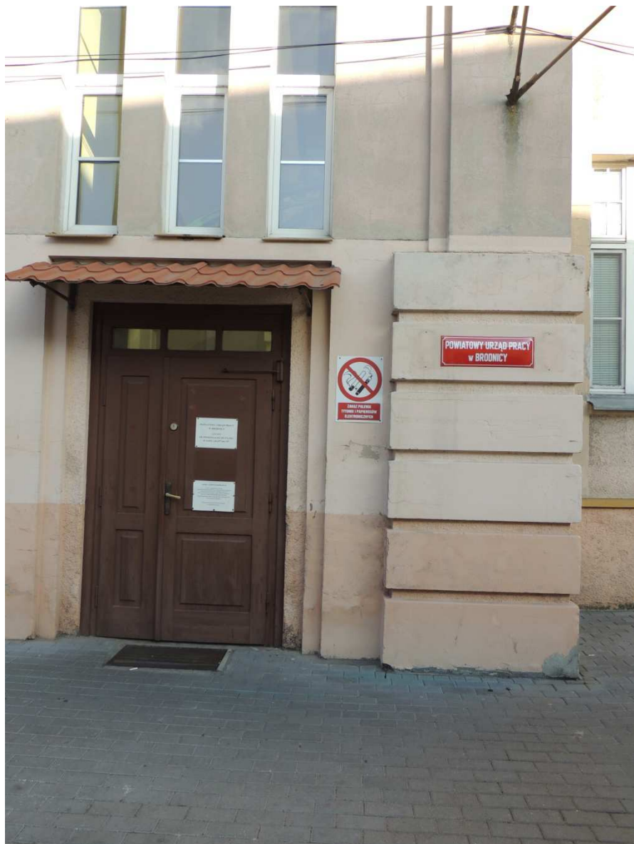
13. Portal wejścia do klatki schodowej.
