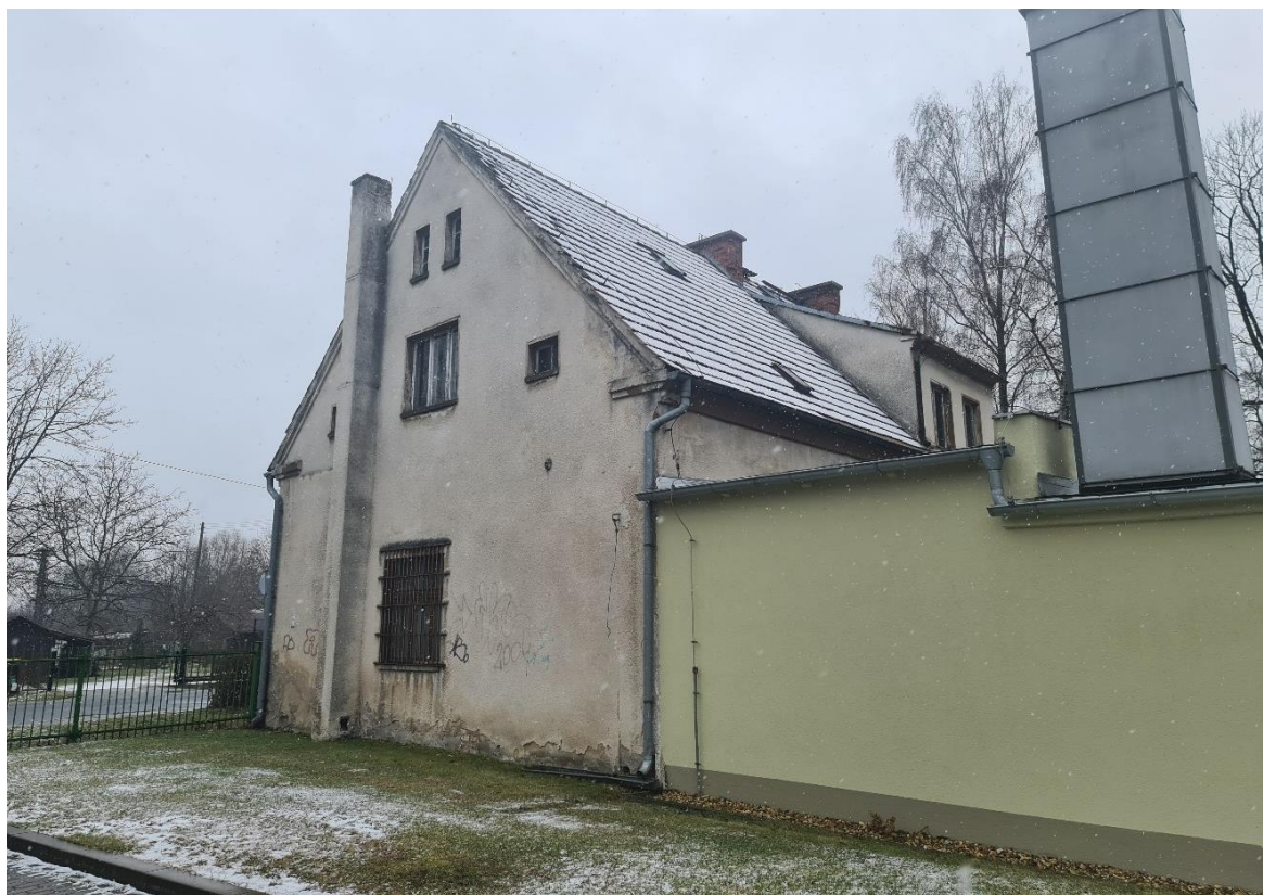
Zdjęcie 3 - ściana szczytowa (widok połączenia z budynkiem przyległym -2)
