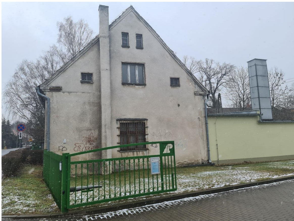
Zdjęcie 2 - ściana szczytowa (widok połączenia z budynkiem przyległym-1)
