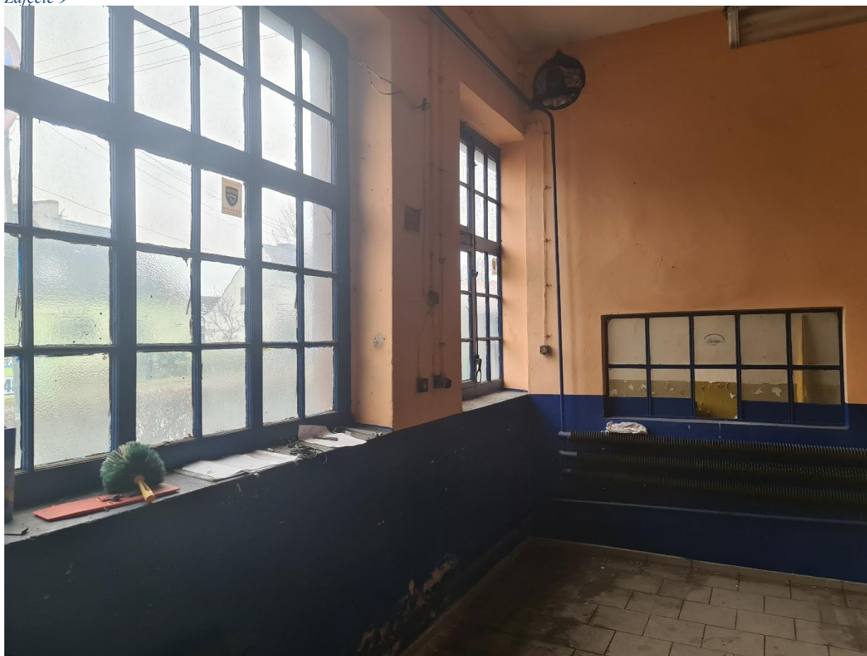
Zdjęcie 10 – widok wnętrza (parter- pomieszczenie od strony ulicy)
