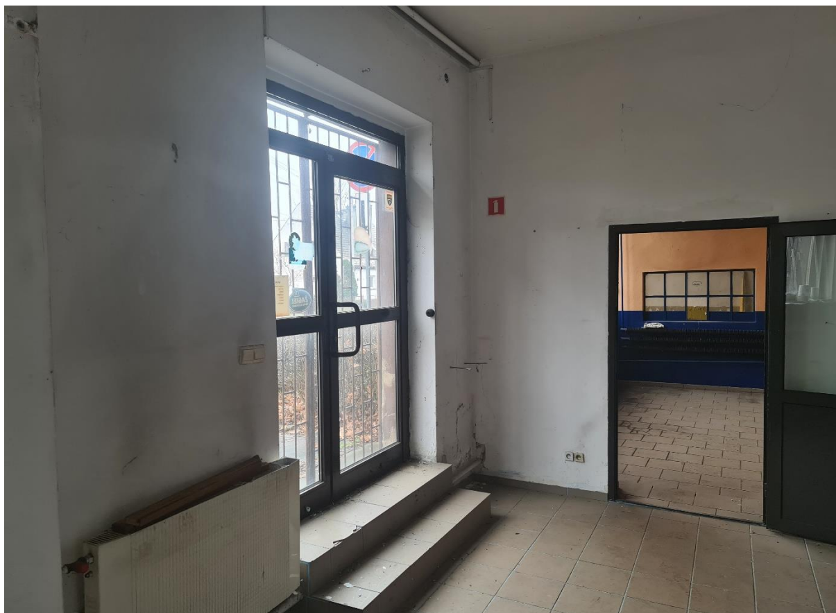
Zdjęcie 8 – widok wnętrza (parter- pomieszczenie od strony ulicy)
