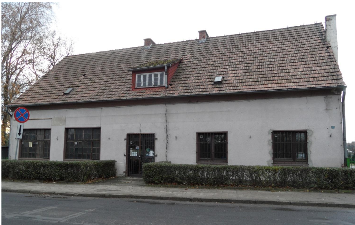
Zdjęcie 1 – widok od strony ulicy
