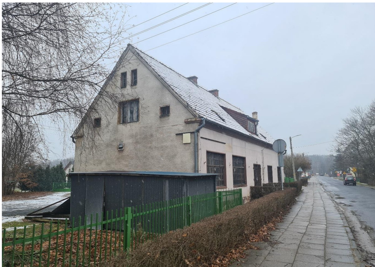
Zdjęcie 5 - widok od strony ulicy
