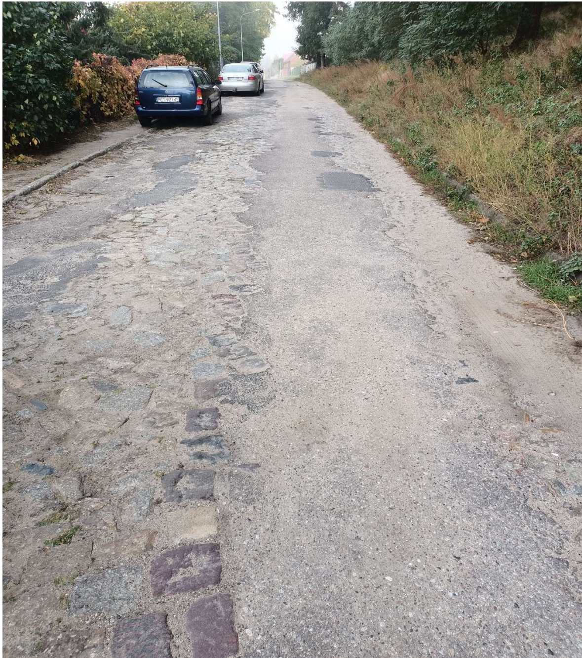
Rys. 2. Nawierzchnia drogi wraz z uszkodzeniami
