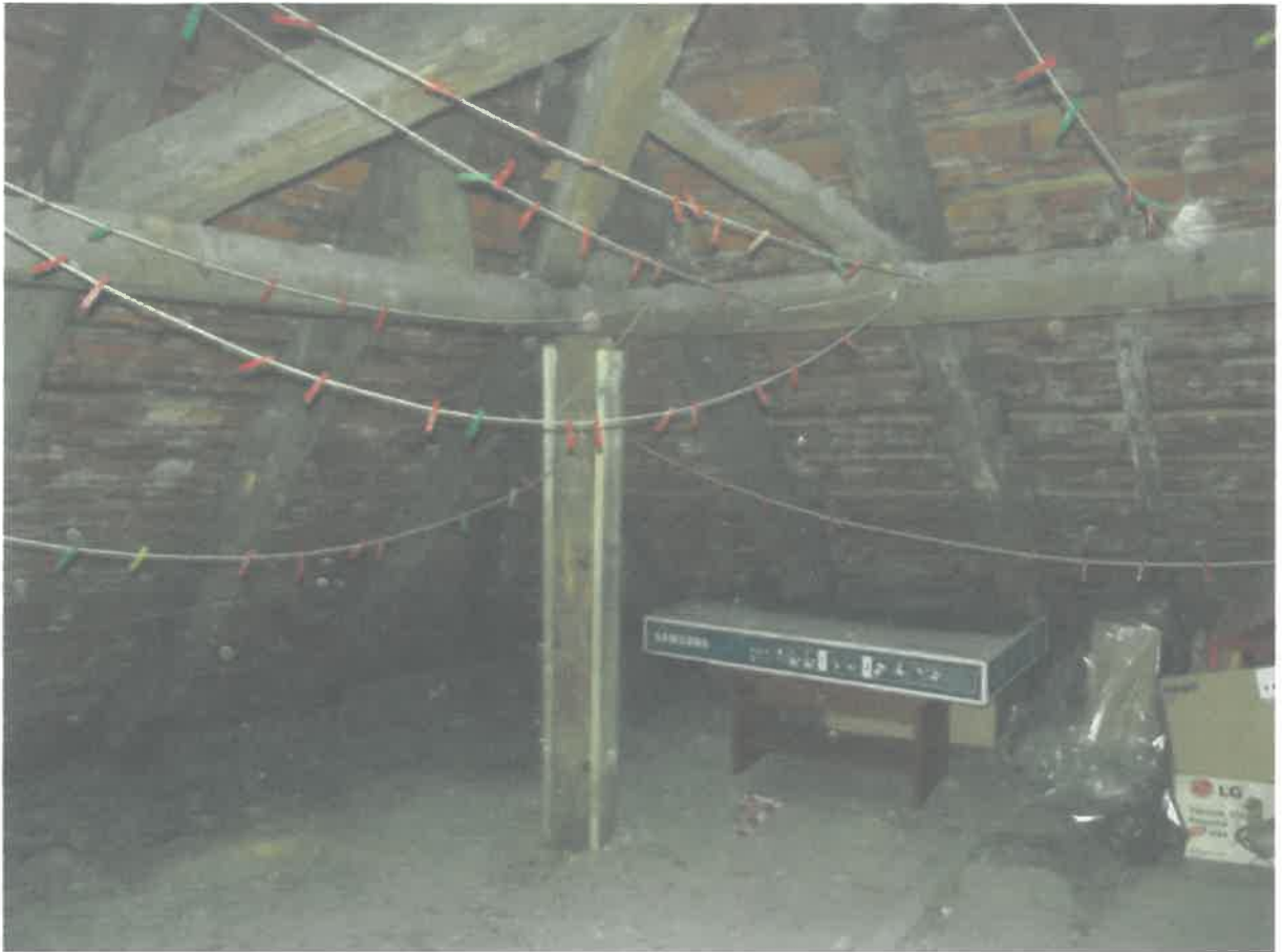
Widok słupa narożnego
