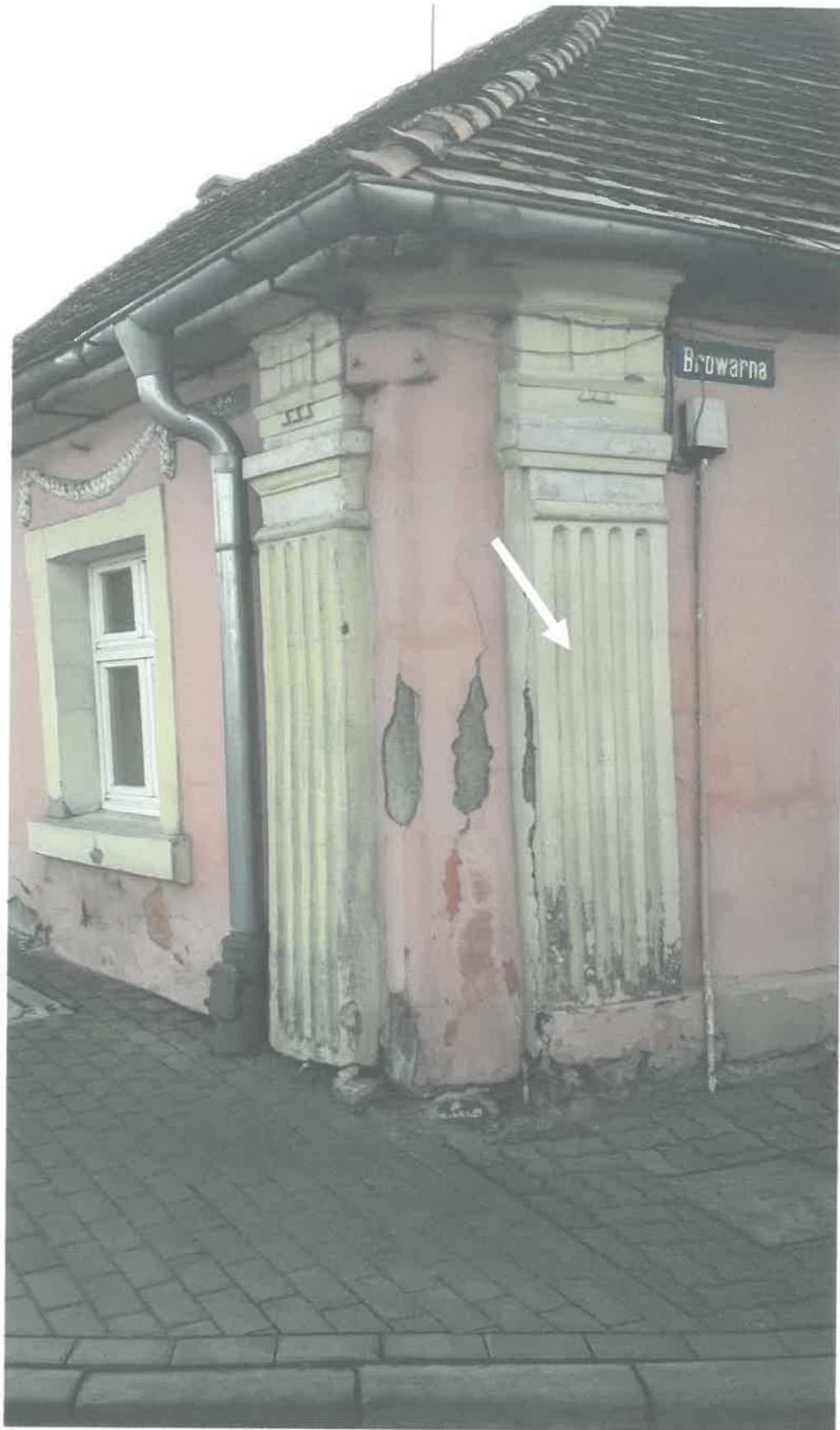
Tynk kanelowany na pilastrze murowanym
