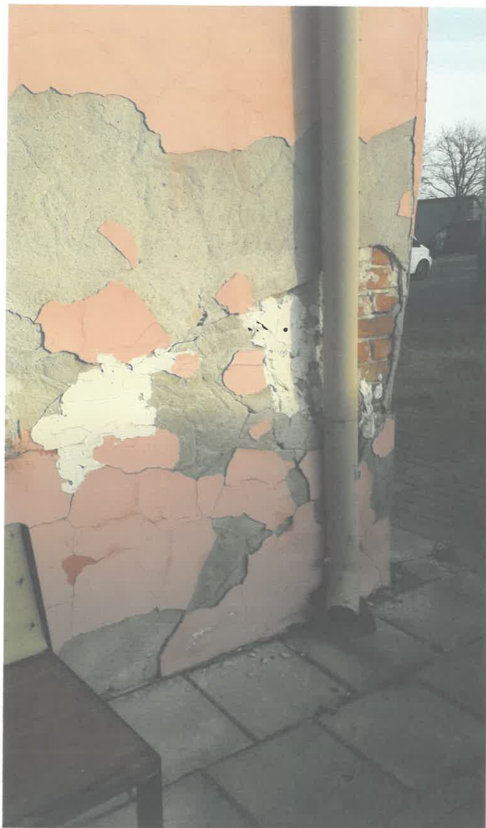
Widok rury spustowej od strony podwórza
