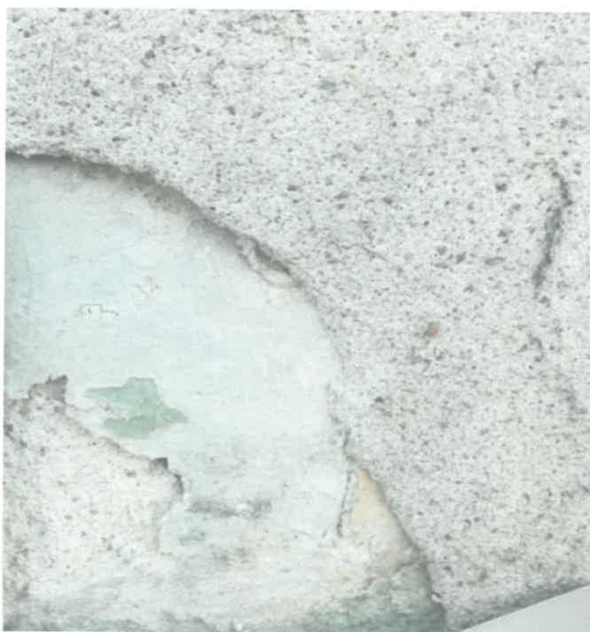
Nałożona warstwa tynku na istniejącej warstwie pomalowanej
